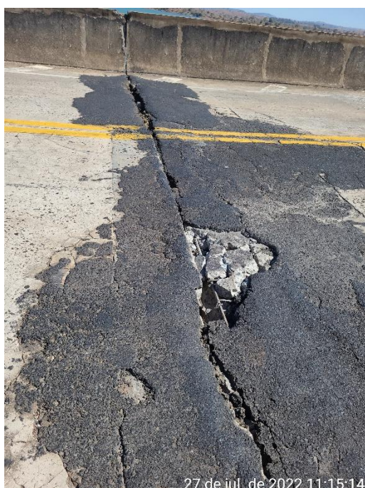
Foto 2 – Detalhe de junta de dilatação e desagregação na pista de rolamento
