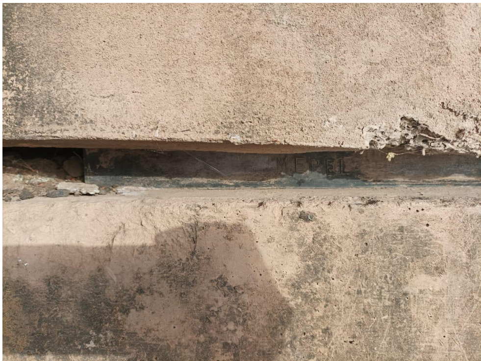
Foto 41 – Detalhe do neopreme existente
