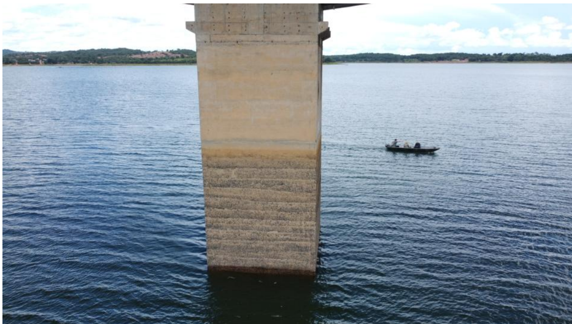
Foto 63 – Pilar P4 íntegro, apenas com desagregação superficial, marcas de escoamento superficial de água e reparos superficiais (Coordenadas: 18°19'36.79"S, 48°33'51.63"W)
