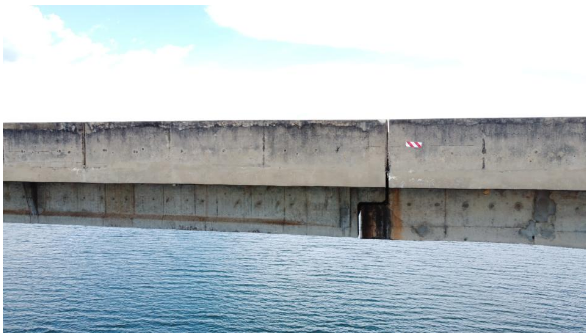
Foto 129 – Vão P4-P5 com detalhes do apoio entre lajes, com marcas de escoamento superficial de água e reparos superficiais. Observação: detalhes dos aparelhos de apoio, em sua maioria rompidos, estão nas imagens iniciais (Coordenadas: 18°19'36.26"S, 48°33'52.07"W)
