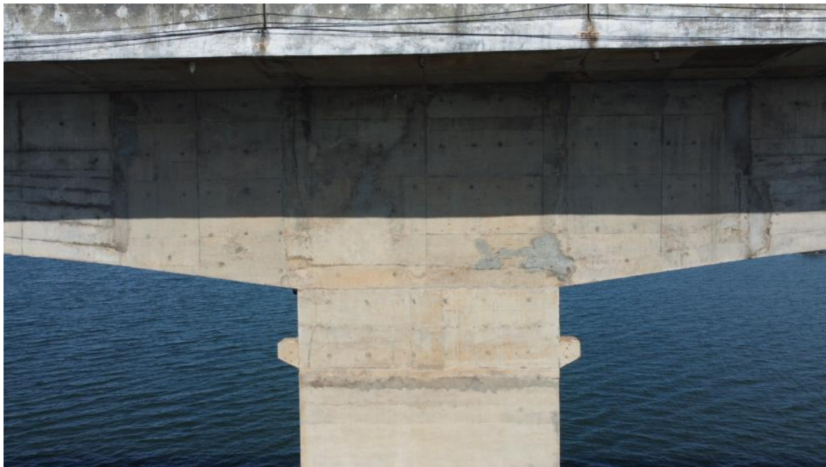
Foto 100 – Pilar P11 íntegro, apenas com desagregação superficial, marcas de escoamento superficial de água e reparos superficiais (Coordenadas: 18°19'18.06"S, 48°33'48.63"W)
