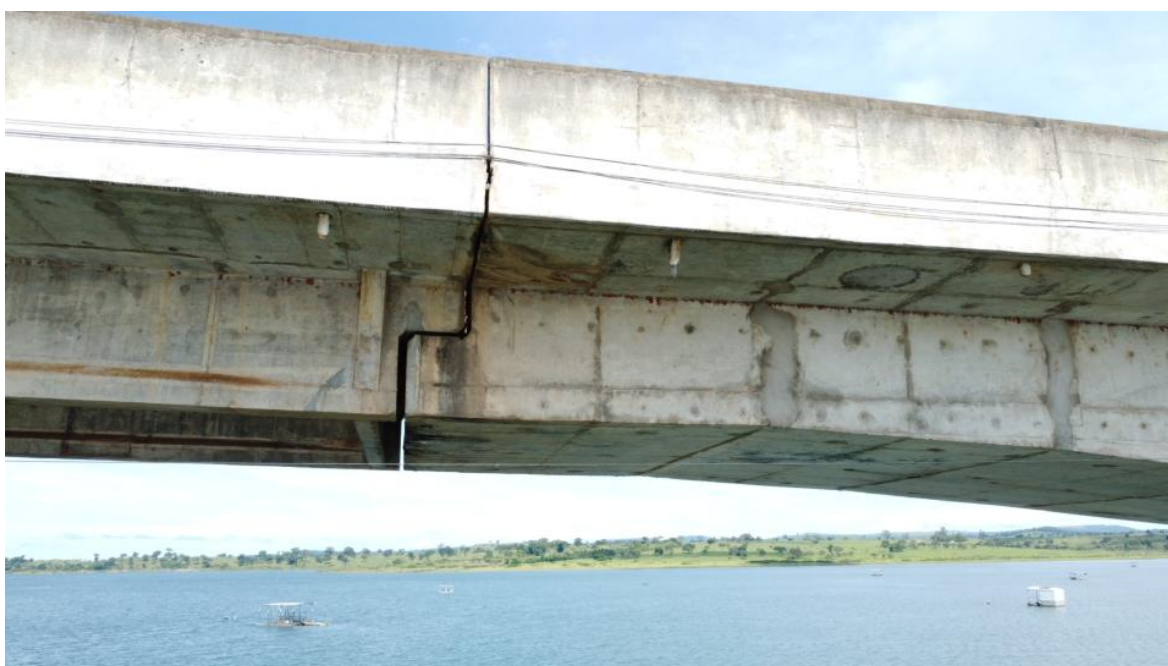
Foto 161 – Vão P12-P13 com detalhes do apoio entre lajes, com marcas de escoamento superficial de água e reparos superficiais. Observação: detalhes dos aparelhos de apoio, em sua maioria rompidos, estão nas imagens iniciais (Coordenadas: 18°19'14.09"S, 48°33'47.48" W)
