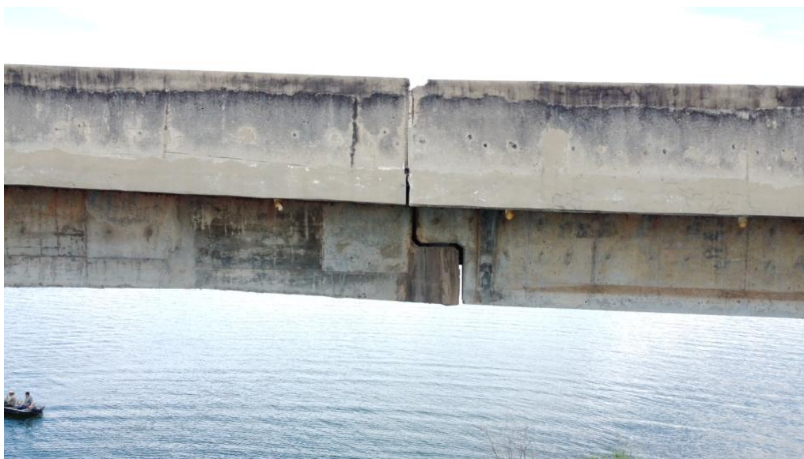
Foto 125 – Vão P2-P3 com detalhes do apoio entre lajes, sem problemas aparentes, com marcas de escoamento superficial de água e reparos superficiais. (Coordenadas: 18°19'41.04"S, 48°33'52.76"W)
