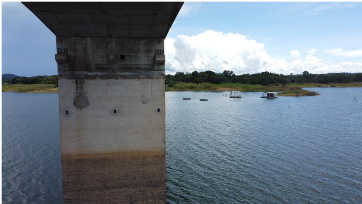
Foto 64 – Pilar P5 íntegro, apenas com desagregação superficial, marcas de escoamento superficial de água e reparos superficiais (Coordenadas: 18°19'34.03"S, 48°33'51.27"W)
