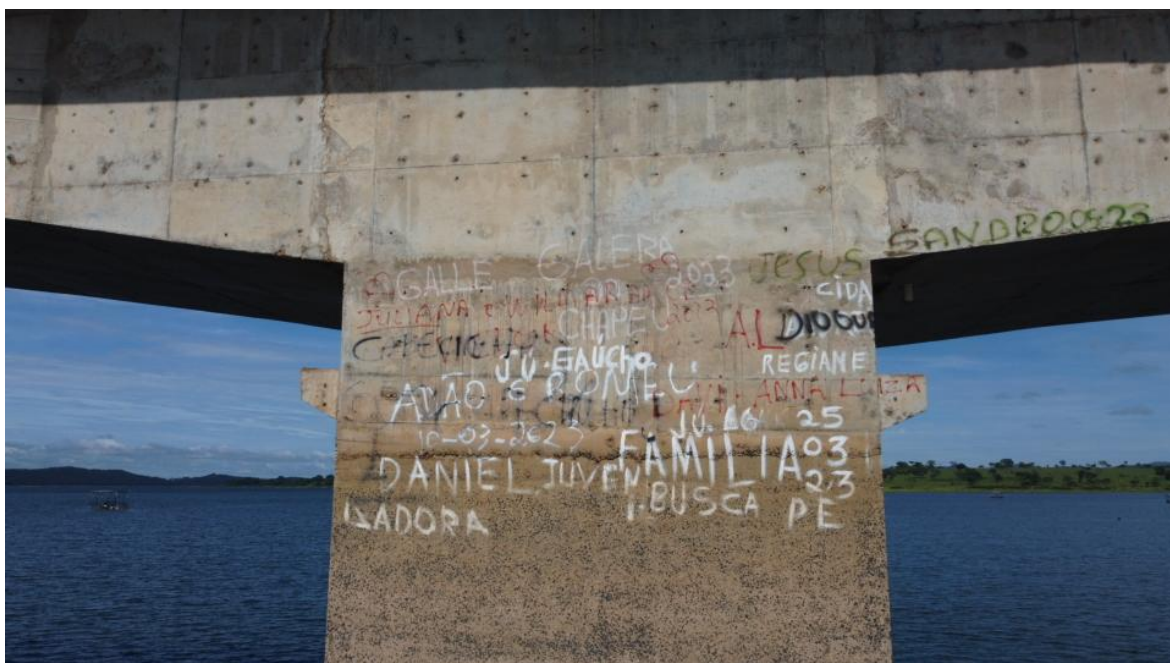
Foto 111 – Pilar P14 íntegro, apenas com desagregação superficial, marcas de escoamento superficial de água e reparos superficiais (Coordenadas: 18°19'10.19"S, 48°33'47.62"W)
