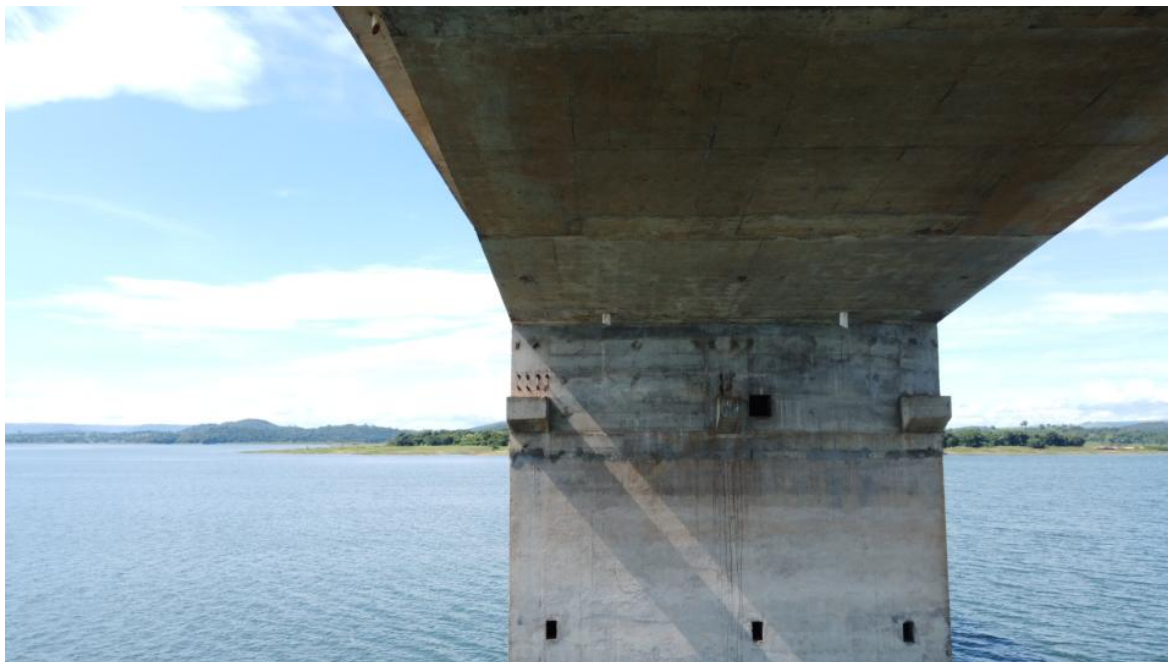
Foto 93 – Pilar P10 íntegro, apenas com desagregação superficial, marcas de escoamento superficial de água e reparos superficiais. Observação: drenos na laje contribuindo para a drenagem interna dos “caixões” (Coordenadas: 18°19'20.66”S, 48°33'48.92”W)
