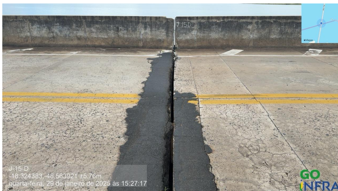
Foto 185 – Junta 15 sentido GO/MG, reparos superficiais
