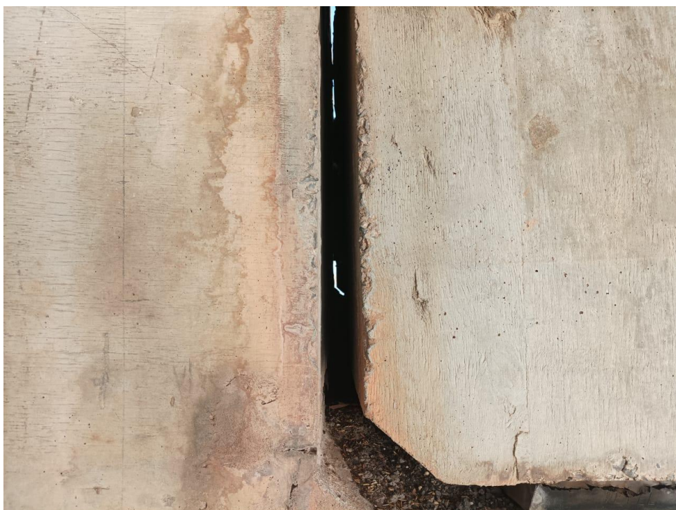
Foto 46 – Detalhe de encontro de viga Gerber
