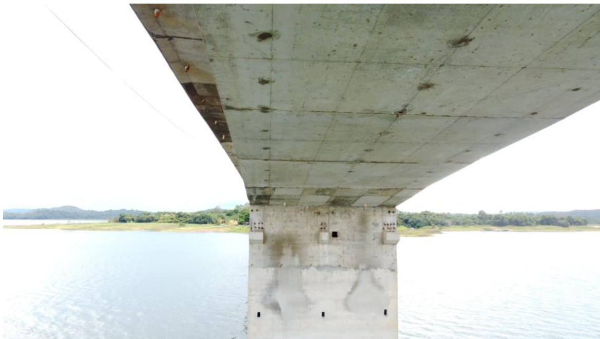
Foto 80 – Pilar P7 íntegro, apenas com desagregação superficial, marcas de escoamento superficial de água e reparos superficiais (Coordenadas: 18°19'29.20"S, 48°33'50.75"W)
