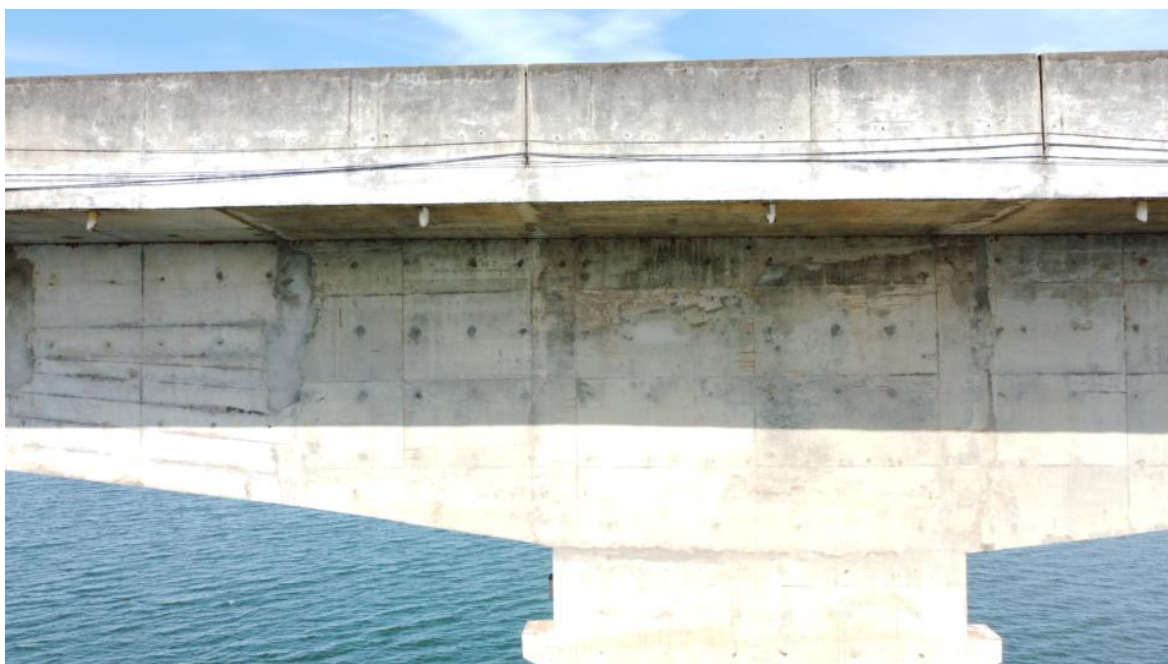
Foto 103 – Pilar P12 íntegro, apenas com desagregação superficial, marcas de escoamento superficial de água e reparos superficiais (Coordenadas: 18°19'15.63"S, 48°33'48.68"W)
