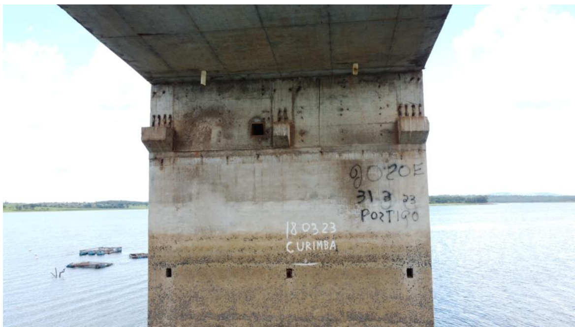
Foto 58 – Pilar P3 íntegro, apenas com desagregação superficial e marcas de escoamento superficial de água. Observação: drenos na laje contribuindo para a drenagem interna dos “caixões” (Coordenadas: 18°19'39.60"S, 48°33'52.08"W)
