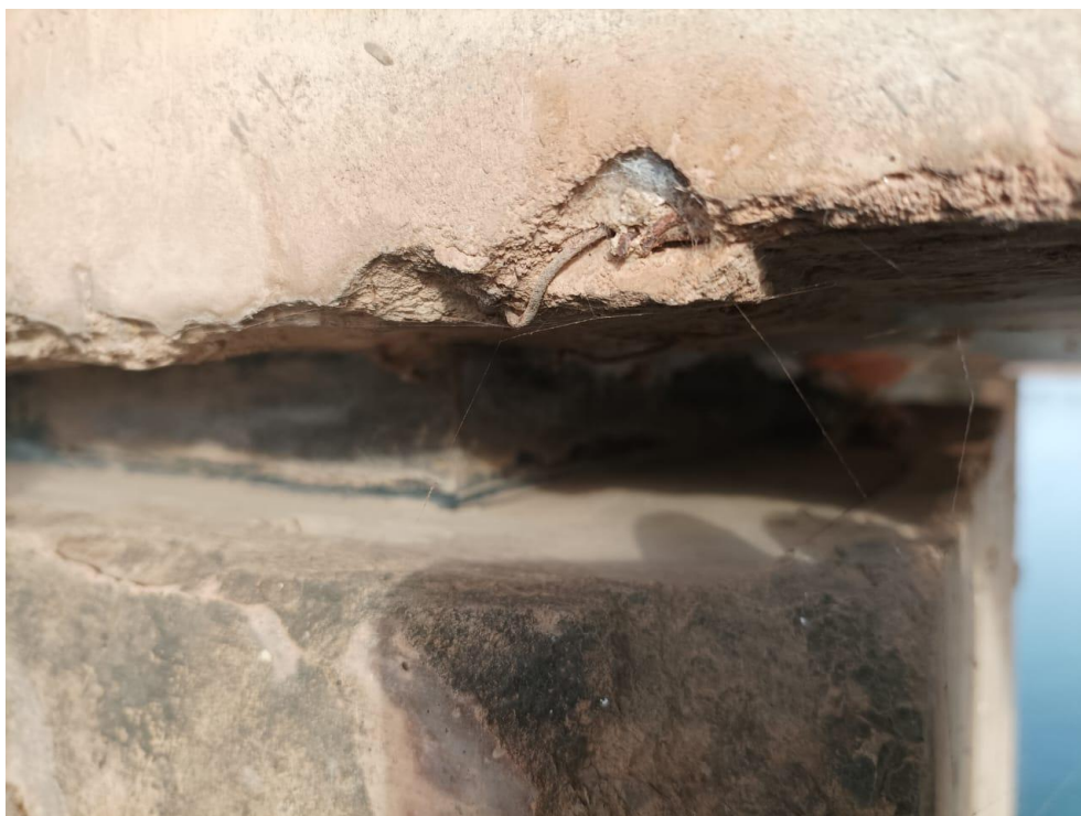
Foto 43 – Detalhe do neopreme existente
