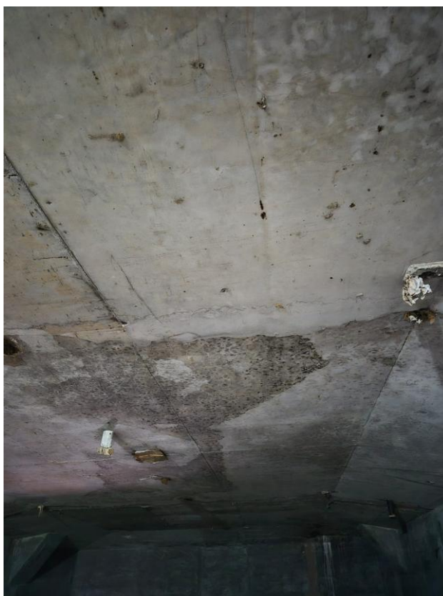
Foto 217 – Vista interna do caixão sem indicações de patologias
