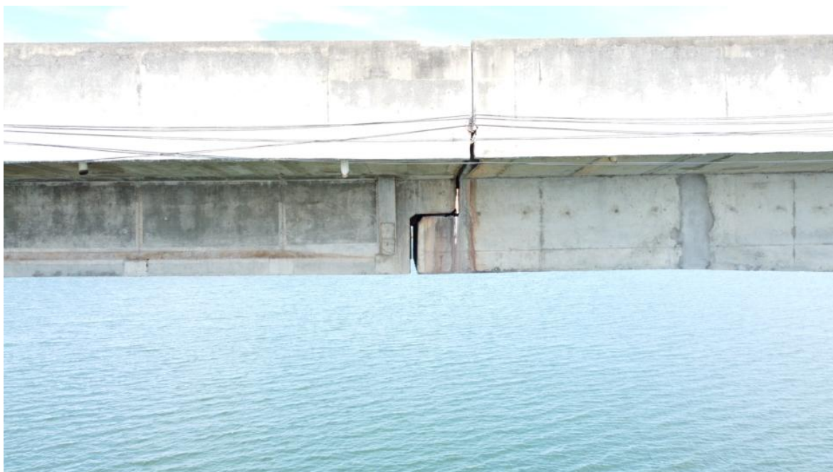
Foto 147 – Vão P8-P9 com detalhes do apoio entre lajes, com marcas de escoamento superficial de água e reparos superficiais. Observação: detalhes dos aparelhos de apoio, em sua maioria rompidos, estão nas imagens iniciais (Coordenadas: 18°19'24.95"S, 48°33'49.33" W)
