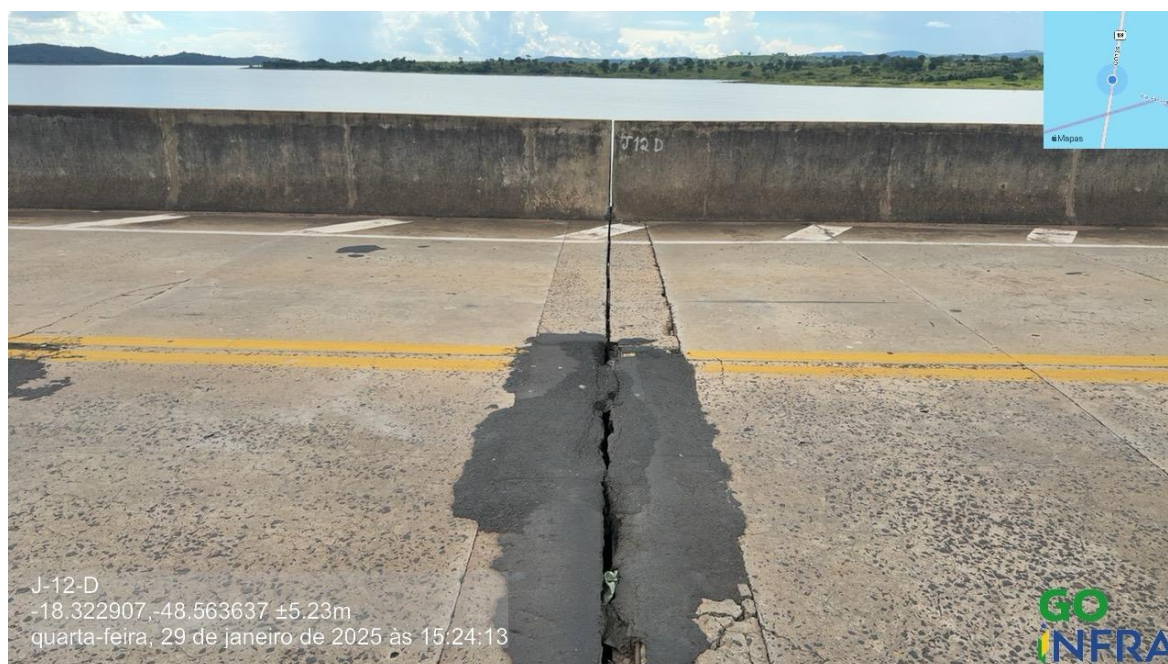
Foto 182 – Junta 12 sentido GO/MG, reparos superficiais
