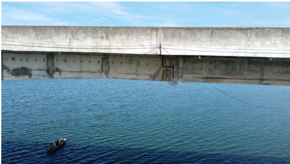
Foto 160 – Vão P12-P13 com detalhes do apoio entre lajes, com marcas de escoamento superficial de água e reparos superficiais. Observação: detalhes dos aparelhos de apoio, em sua maioria rompidos, estão nas imagens iniciais (Coordenadas: 18°19'14.60"S, 48°33'48.39" W)
