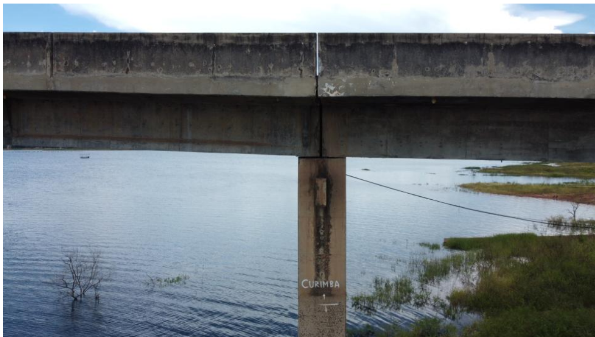
Foto 52 – Pilar P2 íntegro, apenas com desagregação superficial e marcas de escoamento superficial de água (Coordenadas: 18°19'41.69"S, 48°33'53"W)
