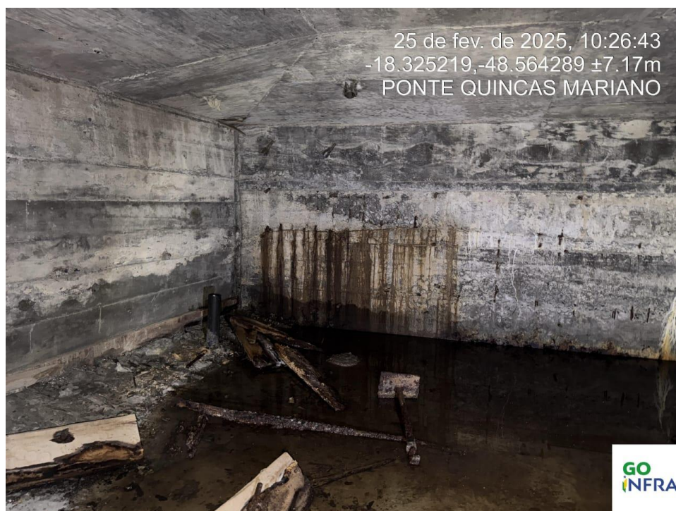
Foto 208 – Vista aproximada de parte interna da estrutura localizada entre os pilares P6 e P7, com desagregação e armadura exposta. Caso de adoção da solução 3 da Nota Técnica.
