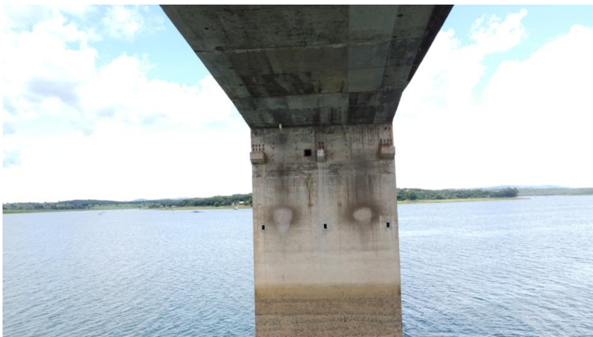
Foto 75 – Pilar P6 íntegro, apenas com desagregação superficial, marcas de escoamento superficial de água e reparos superficiais. Observação: drenos na laje contribuindo para a drenagem interna dos “caixões” (Coordenadas: 18°19'32.02"S, 48°33'50.53"W)
