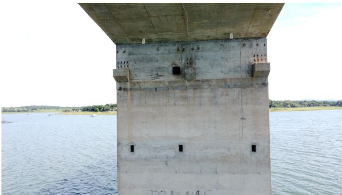
Foto 95 – Pilar P10 íntegro, apenas com desagregação superficial, marcas de escoamento superficial de água e reparos superficiais. Observação: drenos na laje contribuindo para a drenagem interna dos “caixões” (Coordenadas: 18°19'20.66"S, 48°33'48.92"W)
