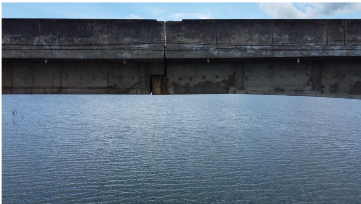
Foto 131 – Vão P4-P5 com detalhes do apoio entre lajes, com marcas de escoamento superficial de água e reparos superficiais. Observação: detalhes dos aparelhos de apoio, em sua maioria rompidos, estão nas imagens iniciais (Coordenadas: 18°19'35.74"S, 48°33'50.94"W)
