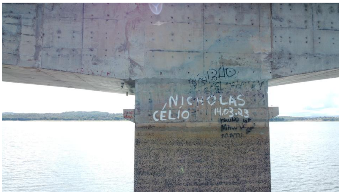
Foto 109 – Pilar P14 íntegro, apenas com desagregação superficial, marcas de escoamento superficial de água e reparos superficiais (Coordenadas: 18°19'10.19”S, 48°33'47.62”W)
