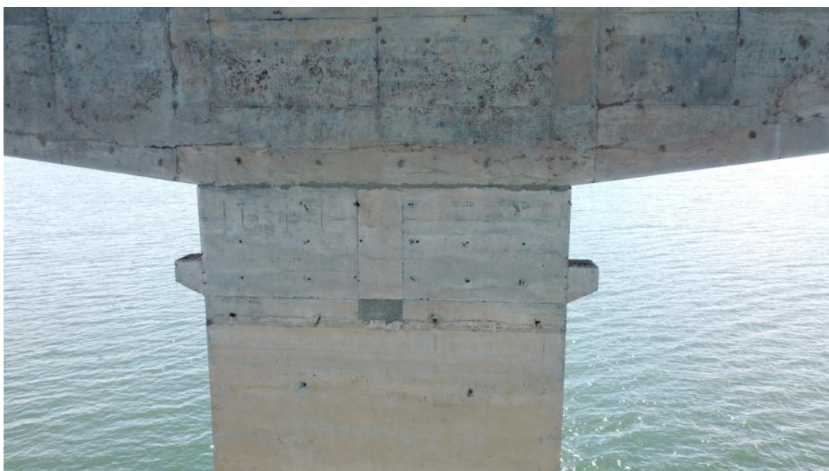
Foto 89 – Pilar P9 íntegro, apenas com desagregação superficial, marcas de escoamento superficial de água e reparos superficiais (Coordenadas: 18°19'23.83"S, 48°33'49.90"W)
