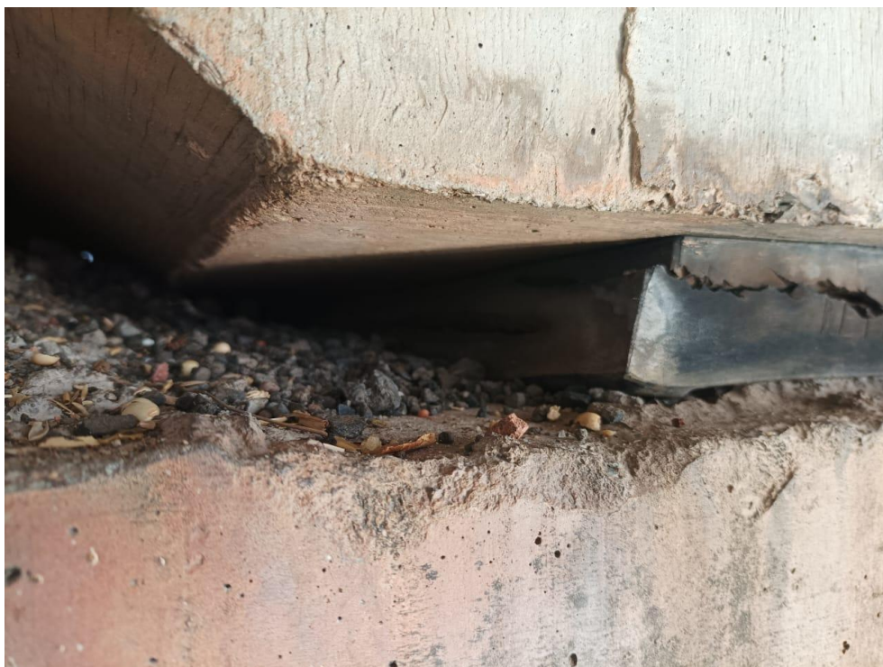
Foto 45 – Detalhe do neopreme existente
