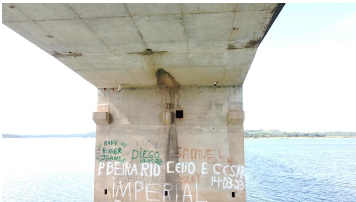
Foto 106 – Pilar P13 íntegro, apenas com desagregação superficial, marcas de escoamento superficial de água de pequenas infiltrações do caixão e reparos superficiais. Observação: drenos na laje contribuindo para a drenagem interna dos “caixões” (Coordenadas: 18°19'12.94”S, 48°33'48.13”W)
