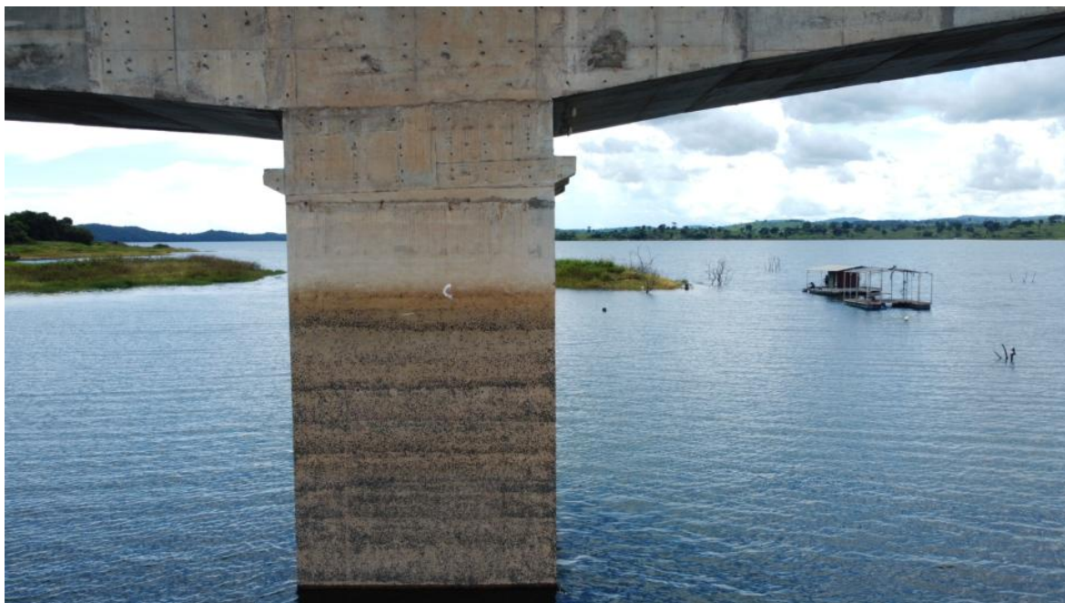
Foto 57 – Pilar P3 íntegro, apenas com desagregação superficial e marcas de escoamento superficial de água (Coordenadas: 18°19'39.60"S, 48°33'52.08"W)
