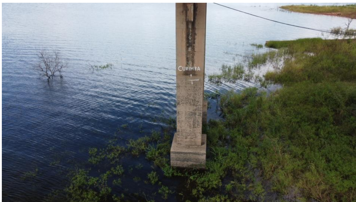
Foto 53 – Pilar P2 íntegro, apenas com desagregação superficial e marcas de escoamento superficial de água (Coordenadas: 18°19'41.69"S, 48°33'53"W)
