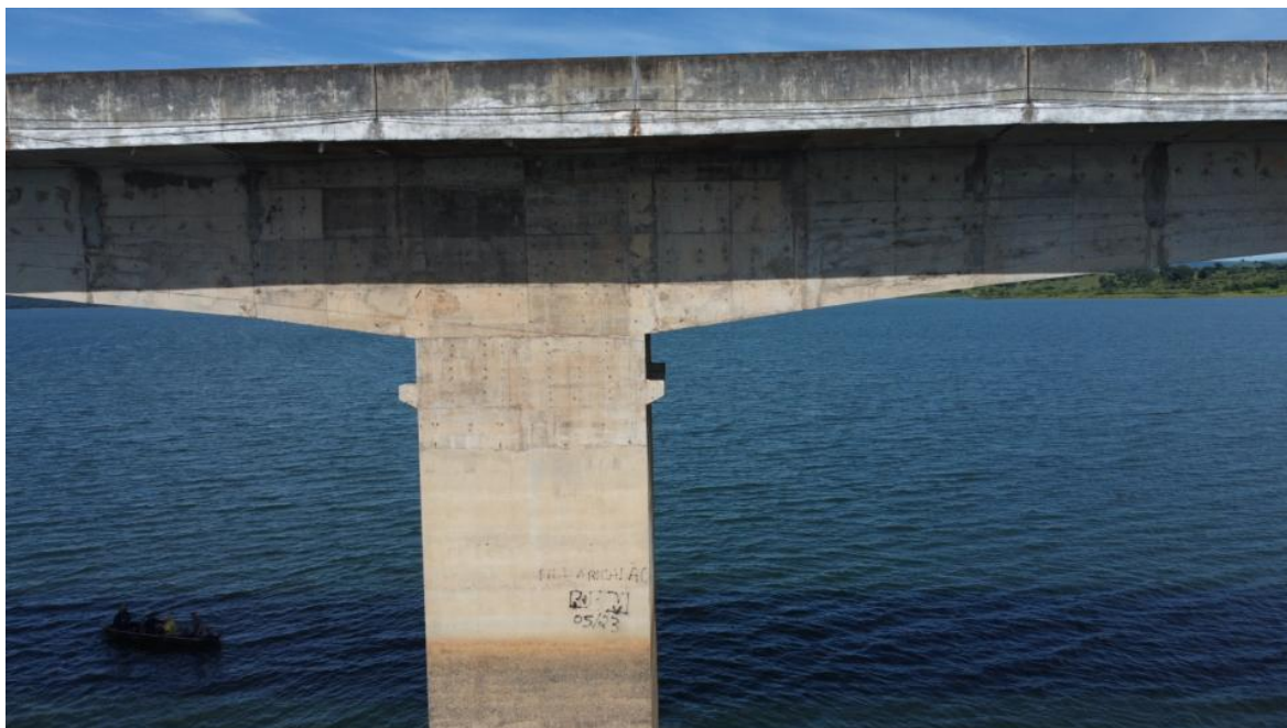
Foto 78 – Pilar P7 íntegro, apenas com desagregação superficial, marcas de escoamento superficial de água e reparos superficiais (Coordenadas: 18°19'29.20"S, 48°33'50.75"W)
