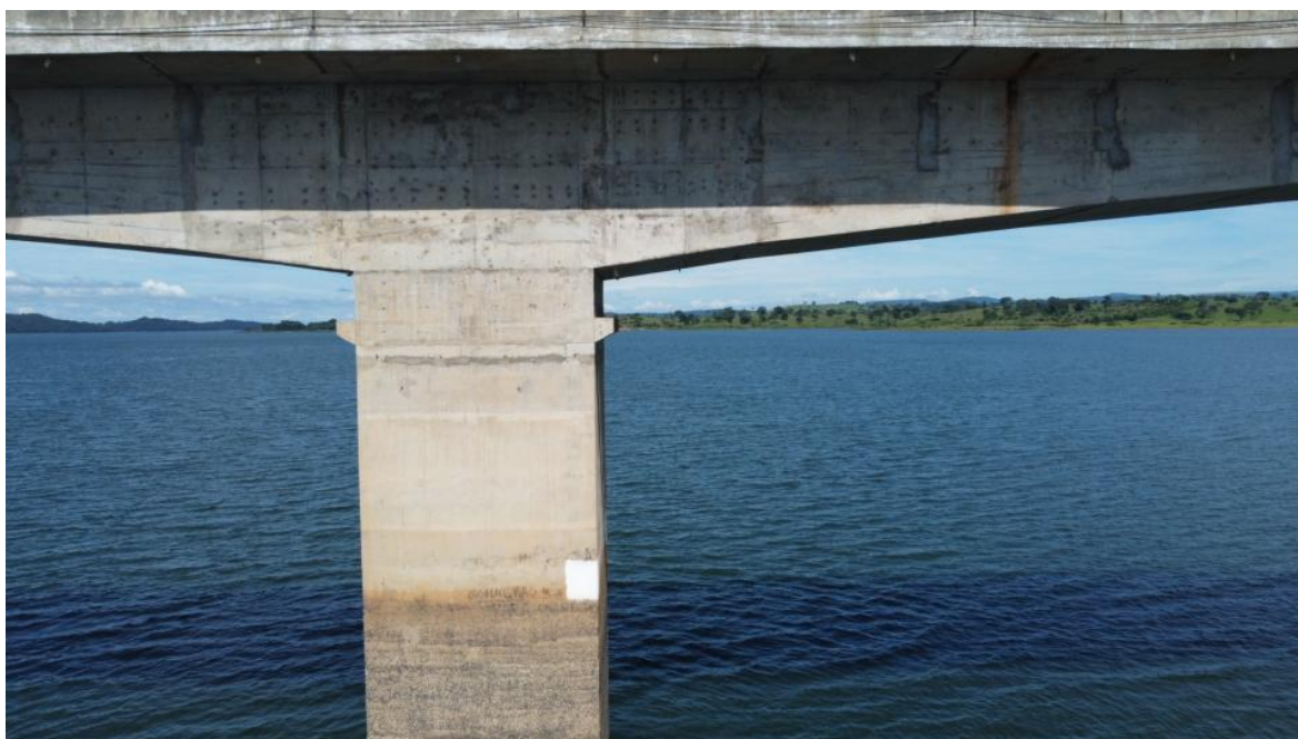
Foto 87 – Pilar P8 íntegro, apenas com desagregação superficial, marcas de escoamento superficial de água e reparos superficiais (Coordenadas: 18°19'26.45”S, 48°33'50.40”W)
