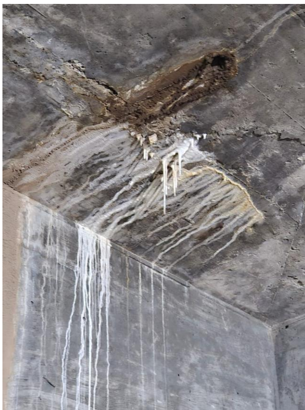
Foto 213 – Infiltração pontual, para o qual é indicada a solução 2 da Nota Técnica
