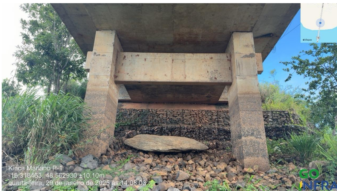
Foto 124 – Pilar P17 íntegro, apenas com desagregação superficial, marcas de escoamento superficial de água e reparos superficiais (Coordenadas: 18°19'6.15"S, 48°33'46.30"W)
