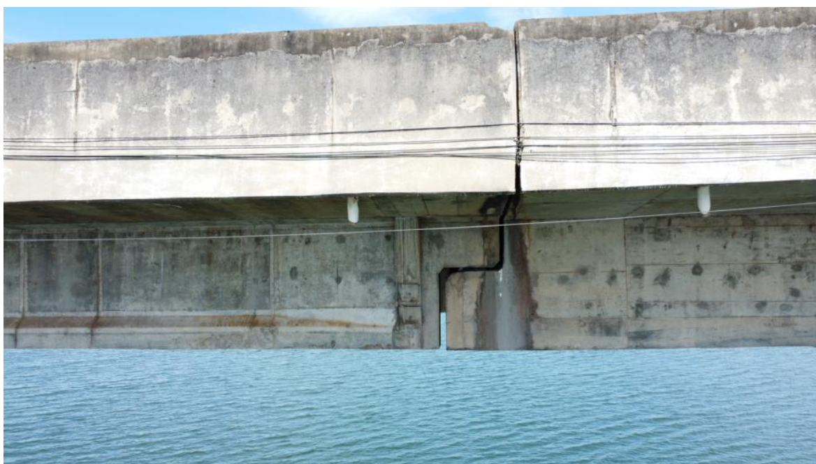
Foto 151 – Vão P9-P10 com detalhes do apoio entre lajes, com marcas de escoamento superficial de água e reparos superficiais. Observação: detalhes dos aparelhos de apoio, em sua maioria rompidos, estão nas imagens iniciais (Coordenadas: 18°19'22.22"S, 48°33'48.91" W)
