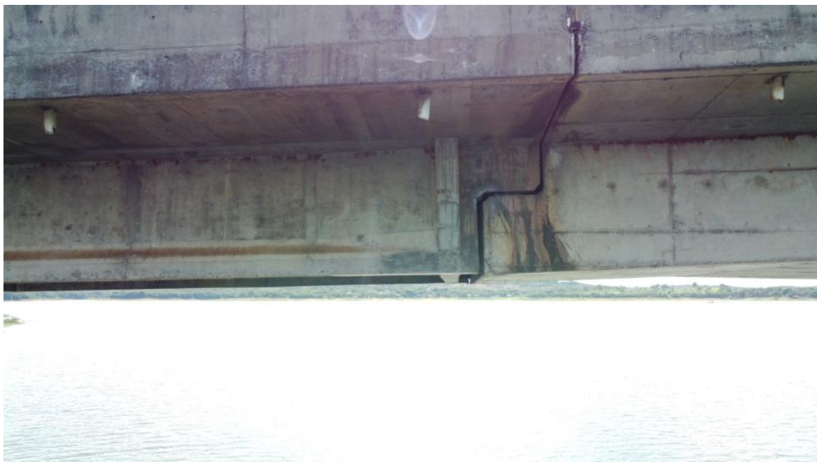
Foto 165 – Vão P14-P15 com detalhes do apoio entre lajes, com marcas de escoamento superficial de água e reparos superficiais. Observação: detalhes dos aparelhos de apoio, em sua maioria rompidos, estão nas imagens iniciais (Coordenadas: 18°19'9.17"S, 48°33'47.41" W)
