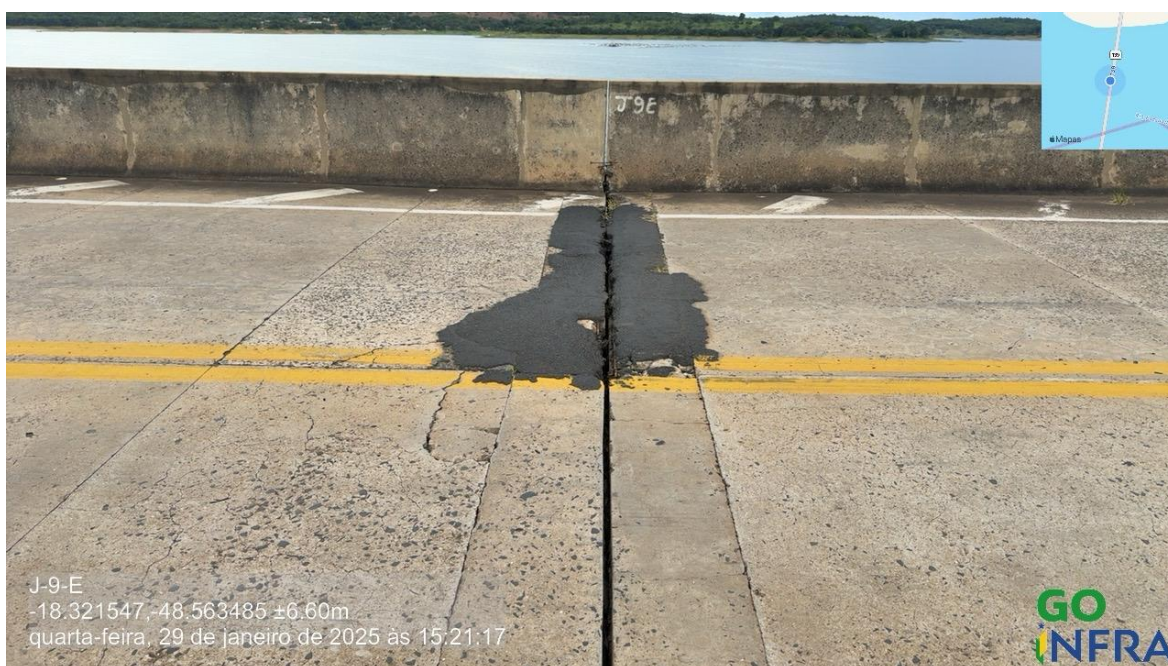
Foto 179 – Junta 9 sentido GO/MG, reparos superficiais
