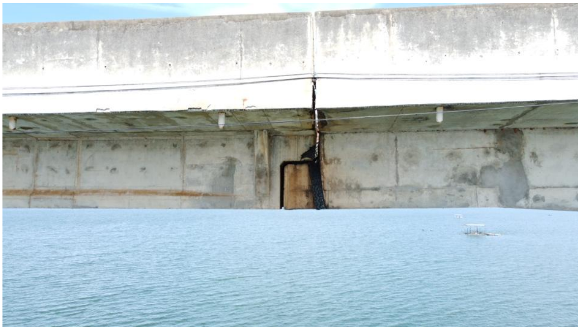
Foto 158 – Vão P11-P12 com detalhes do apoio entre lajes, com marcas de escoamento superficial de água e reparos superficiais. Observação: detalhes dos aparelhos de apoio, em sua maioria rompidos, estão nas imagens iniciais (Coordenadas: 18°19'16.61"S, 48°33'48.70" W)
