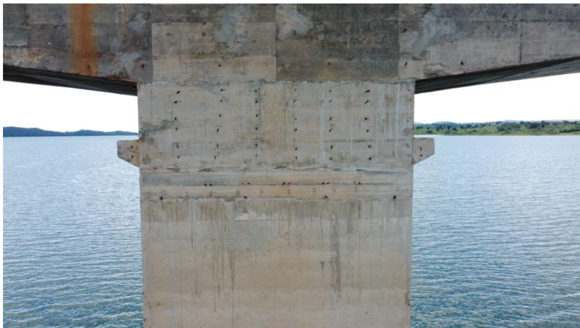
Foto 72 – Pilar P6 íntegro, apenas com desagregação superficial, marcas de escoamento superficial de água e reparos superficiais (Coordenadas: 18°19'32.02"S, 48°33'50.53"W)
