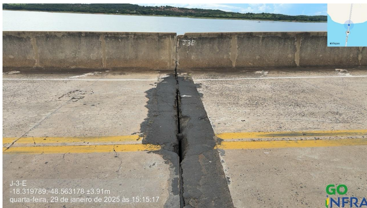
Foto 173 – Junta 3 sentido GO/MG, reparos superficiais
