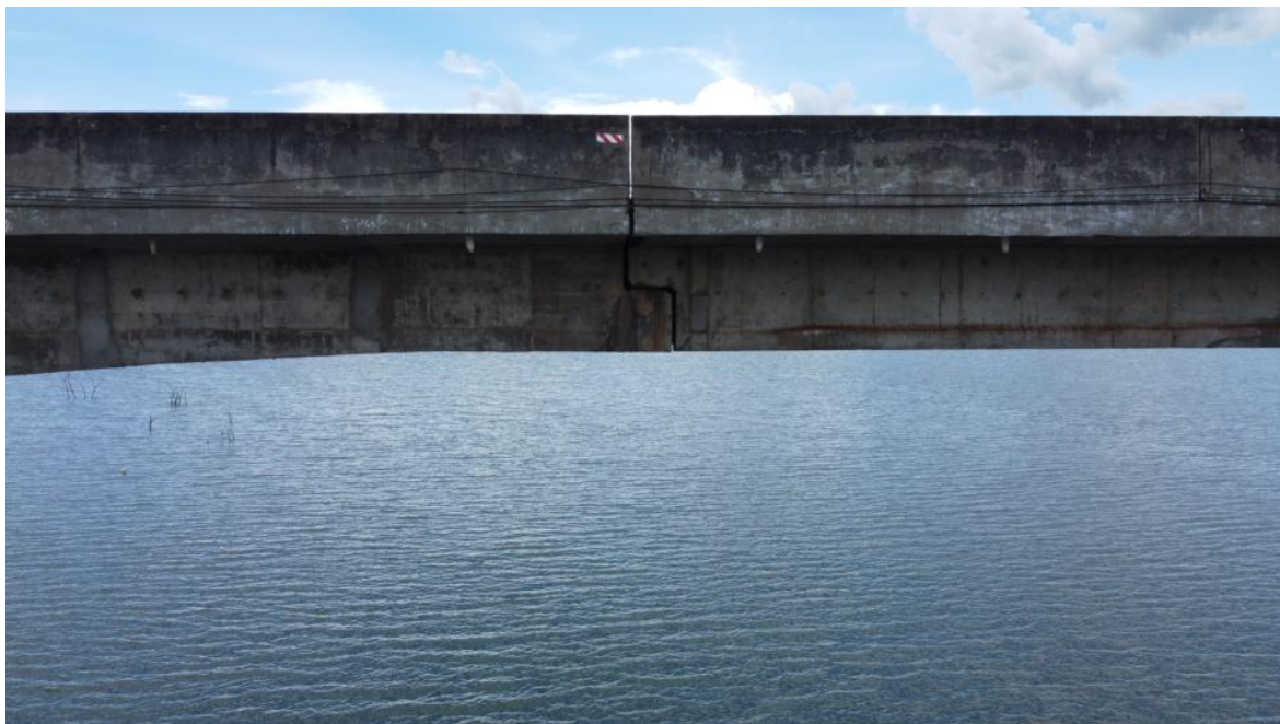
Foto 130 – Vão P4-P5 com detalhes do apoio entre lajes, com marcas de escoamento superficial de água e reparos superficiais. Observação: detalhes dos aparelhos de apoio, em sua maioria rompidos, estão nas imagens iniciais (Coordenadas: 18°19'36.26"S, 48°33'52.07"W)
