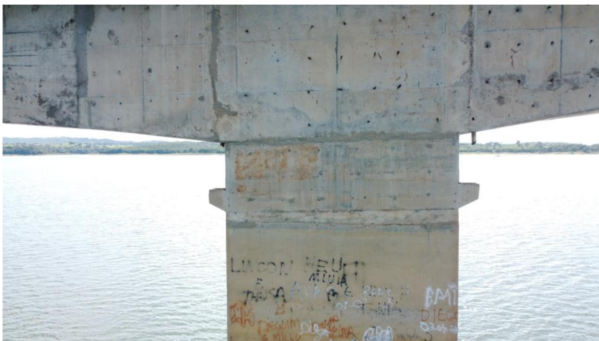
Foto 105 – Pilar P13 íntegro, apenas com desagregação superficial, marcas de escoamento superficial de água e reparos superficiais (Coordenadas: 18°19'12.94"S, 48°33'48.13"W)
