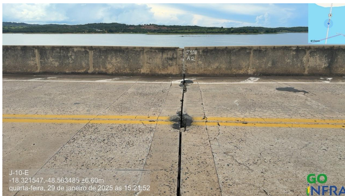
Foto 180 – Junta 10 sentido GO/MG, reparos superficiais
