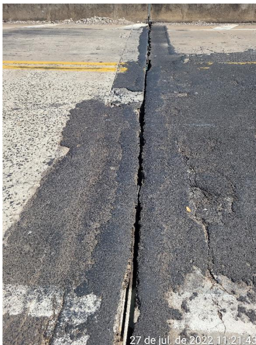
Foto 7 – Detalhe de junta de dilatação vista na pista de rolamento
