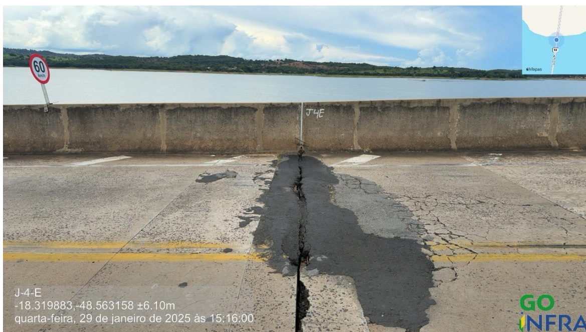
Foto 174 – Junta 4 sentido GO/MG, reparos superficiais
