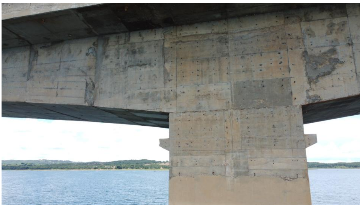
Foto 83 – Pilar P7 íntegro, apenas com desagregação superficial, marcas de escoamento superficial de água e reparos superficiais. Observação: drenos na laje contribuindo para a drenagem interna dos “caixões” (Coordenadas: 18°19'29.20"S, 48°33'50.75"W)
