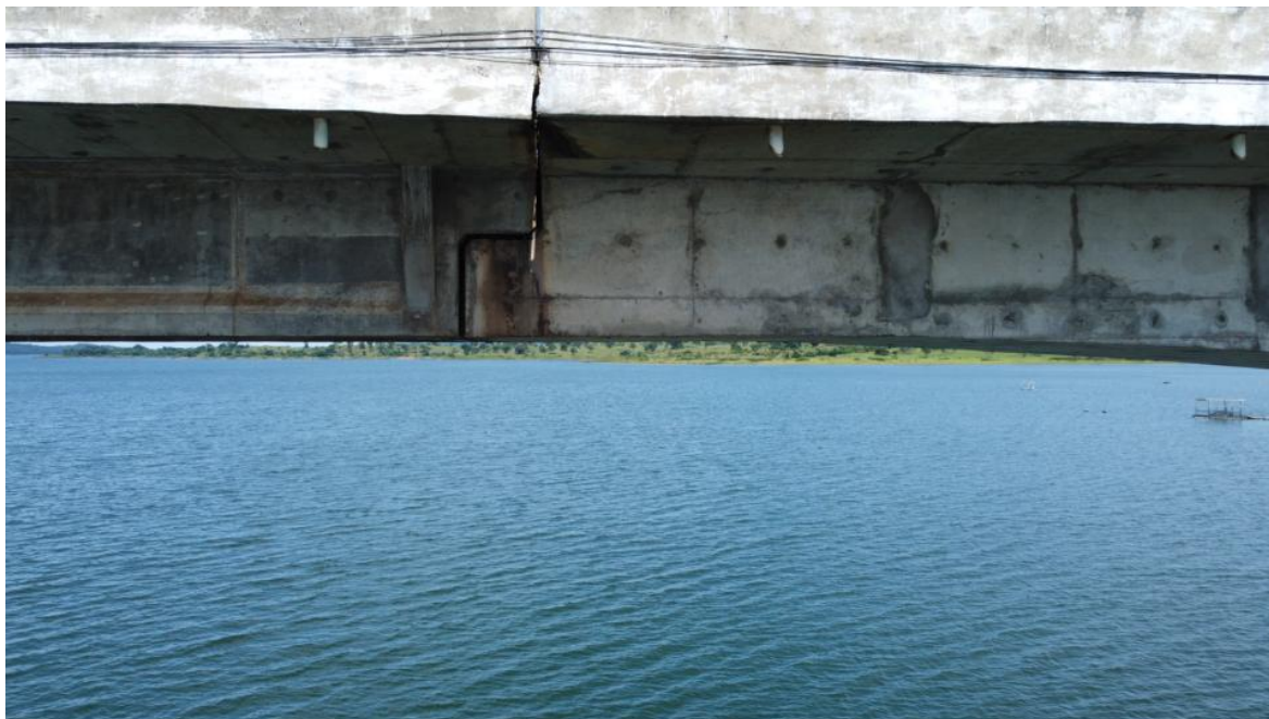
Foto 156 – Vão P10-P11 com detalhes do apoio entre lajes, com marcas de escoamento superficial de água e reparos superficiais. Observação: detalhes dos aparelhos de apoio, em sua maioria rompidos, estão nas imagens iniciais (Coordenadas: 18°19'19.40"S, 48°33'49.25" W)
