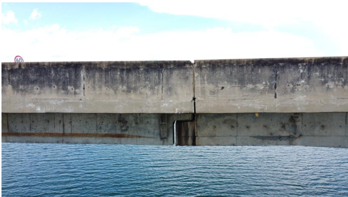
Foto 137 – Vão P6-P7 com detalhes do apoio entre lajes, com marcas de escoamento superficial de água e reparos superficiais. Observação: detalhes dos aparelhos de apoio, em sua maioria rompidos, estão nas imagens iniciais (Coordenadas: 18°19'30.86"S, 48°33'51.11"W)
