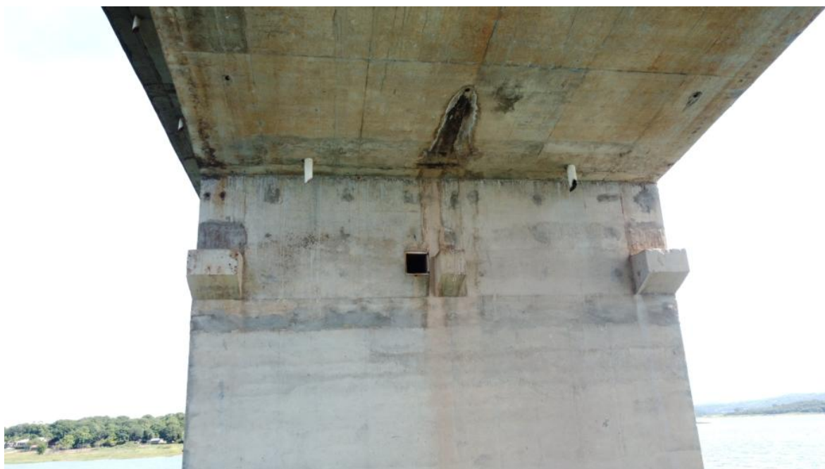
Foto 99 – Pilar P11 íntegro, apenas com desagregação superficial, marcas de escoamento superficial de água de pequenas infiltrações do caixão e reparos superficiais. Observação: drenos na laje contribuindo para a drenagem interna dos “caixões” (Coordenadas: 18°19'18.06"S, 48°33'48.63"W)
