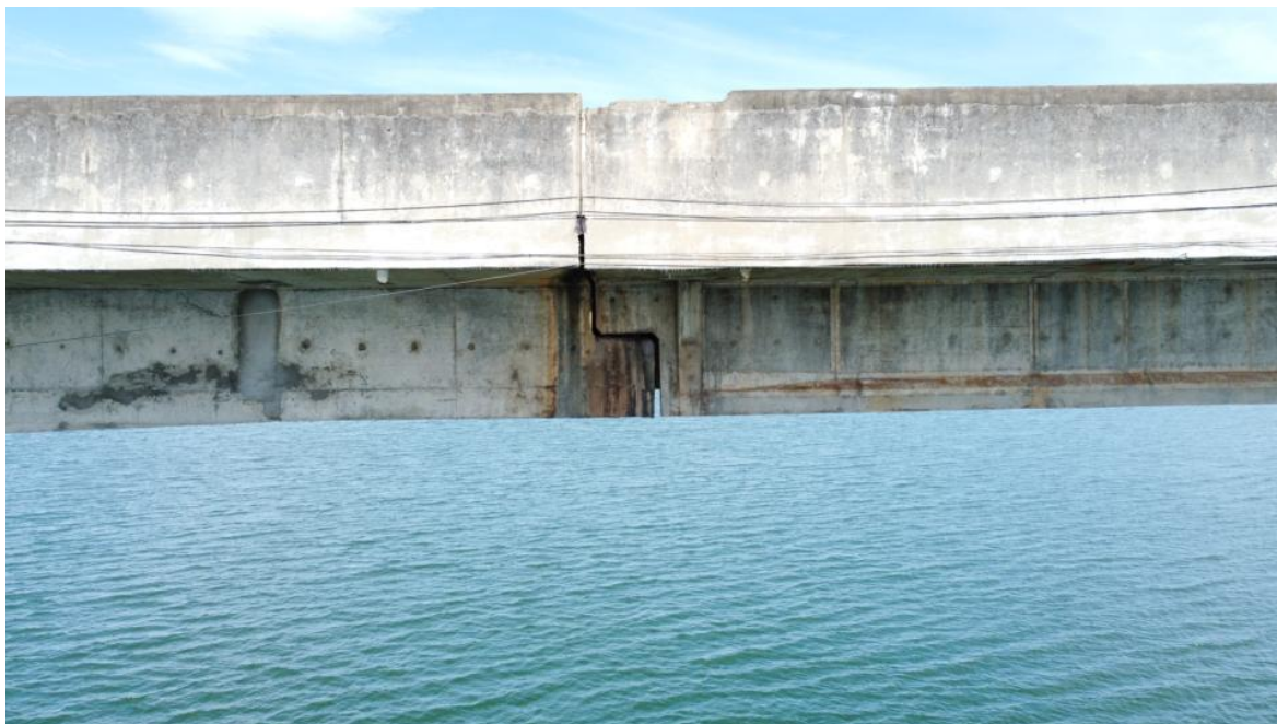
Foto 142 – Vão P7-P8 com detalhes do apoio entre lajes, com marcas de escoamento superficial de água e reparos superficiais. Observação: detalhes dos aparelhos de apoio, em sua maioria rompidos, estão nas imagens iniciais (Coordenadas: 18°19'28.18"S, 48°33'50.64" W)
