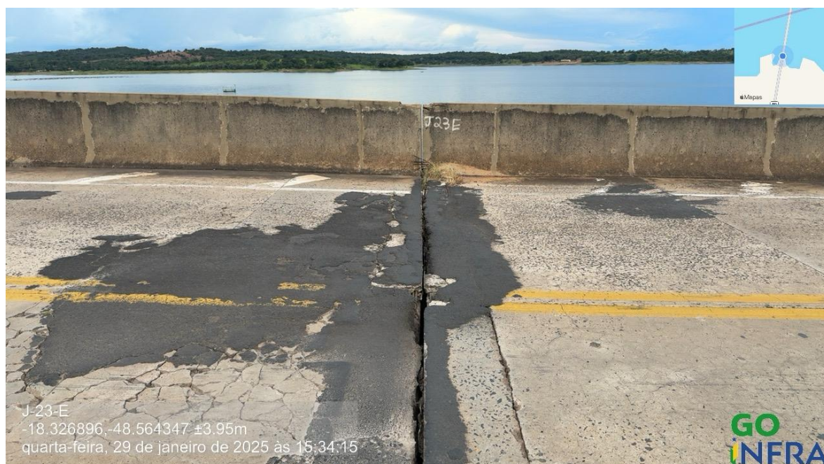
Foto 193 – Junta 23 sentido GO/MG, armadura exposta de laje de sacrifício e reparos superficiais
