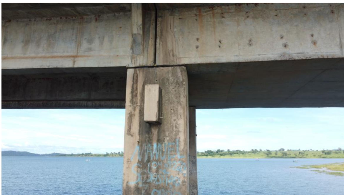
Foto 114 – Pilar P15 íntegro, apenas com desagregação superficial, marcas de escoamento superficial de água e reparos superficiais (Coordenadas: 18°19'8.32"S, 48°33'46.85"W)
