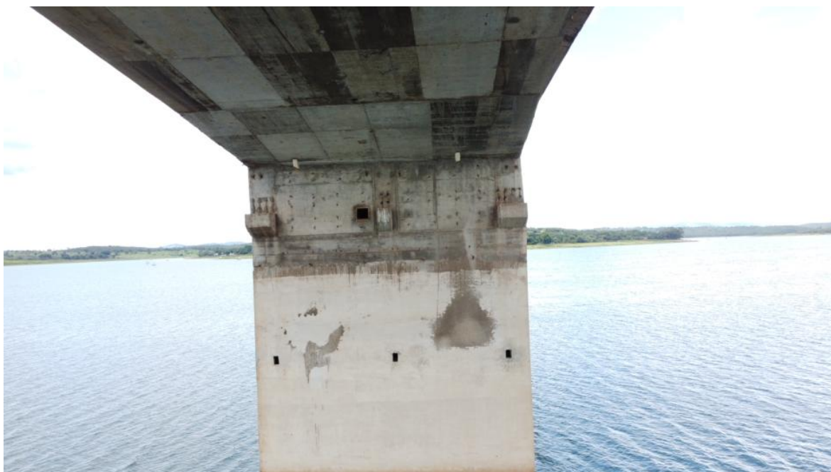
Foto 67 – Pilar P5 íntegro, apenas com desagregação superficial, marcas de escoamento superficial de água e reparos superficiais. Observação: drenos na laje contribuindo para a drenagem interna dos “caixões” (Coordenadas: 18°19'34.03"S, 48°33'51.27"W)
