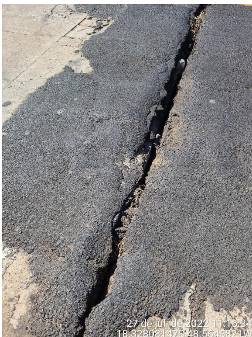
Foto 4 – Detalhe de junta de dilatação vista na pista de rolamento
