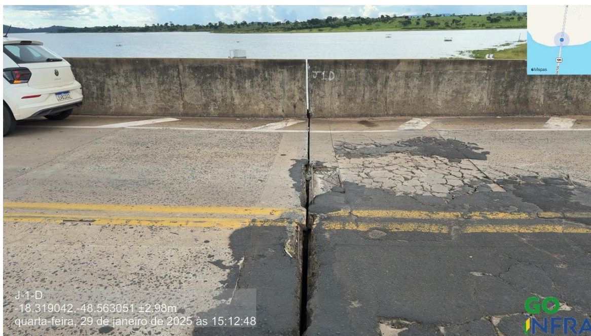
Foto 171 – Junta 1 sentido GO/MG, armadura exposta de laje de sacrifício e reparos superficiais
