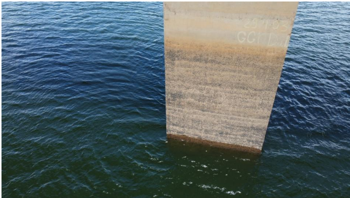
Foto 84 – Pilar P7 íntegro, apenas com desagregação superficial, marcas de escoamento superficial de água e reparos superficiais (Coordenadas: 18°19'29.20"S, 48°33'50.75"W)
