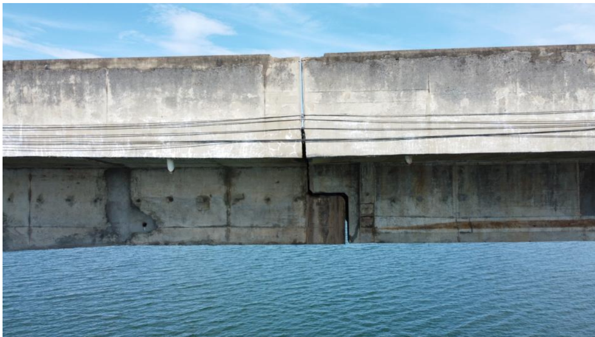
Foto 150 – Vão P9-P10 com detalhes do apoio entre lajes, com marcas de escoamento superficial de água e reparos superficiais. Observação: detalhes dos aparelhos de apoio, em sua maioria rompidos, estão nas imagens iniciais (Coordenadas: 18°19'22.77"S, 48°33'49.72" W)
