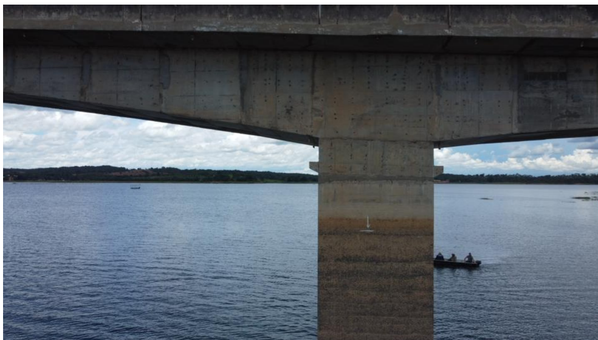
Foto 59 – Pilar P3 íntegro, apenas com desagregação superficial e marcas de escoamento superficial de água (Coordenadas: 18°19'39.60"S, 48°33'52.08"W)
