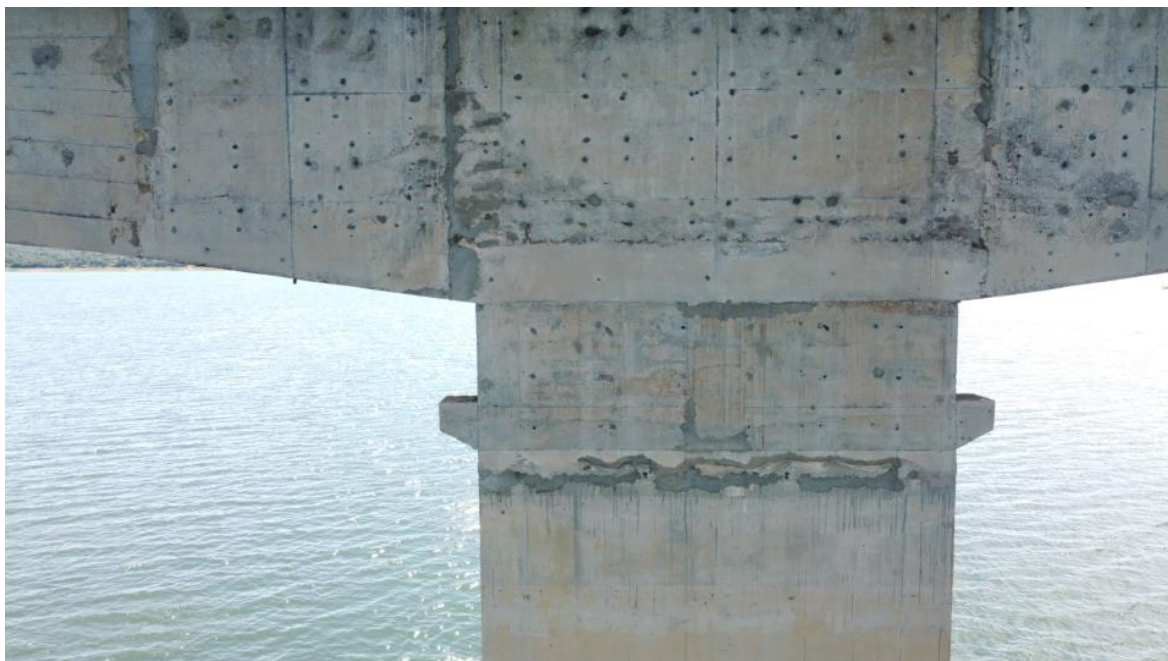
Foto 85 – Pilar P8 íntegro, apenas com desagregação superficial, marcas de escoamento superficial de água e reparos superficiais (Coordenadas: 18°19'26.45"S, 48°33'50.40"W)
