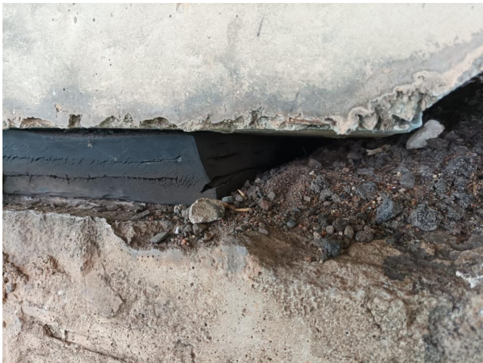
Foto 49 – Detalhe do neopreme existente
