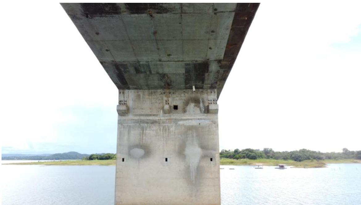
Foto 70 – Pilar P6 íntegro, apenas com desagregação superficial, marcas de escoamento superficial de água e reparos superficiais. Observação: drenos na laje contribuindo para a drenagem interna dos “caixões” (Coordenadas: 18°19'32.02”S, 48°33'50.53”W)
