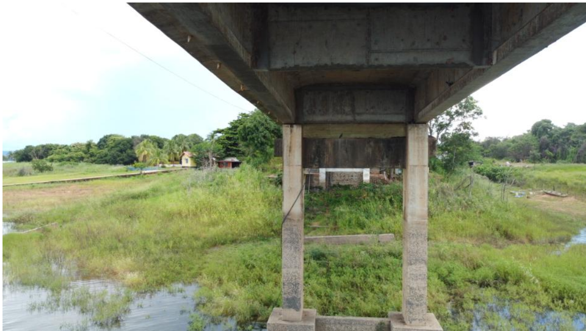
Foto 54 – Pilar P2 íntegro, apenas com desagregação superficial e marcas de escoamento superficial de água (Coordenadas: 18°19'41.69"S, 48°33'53"W)
