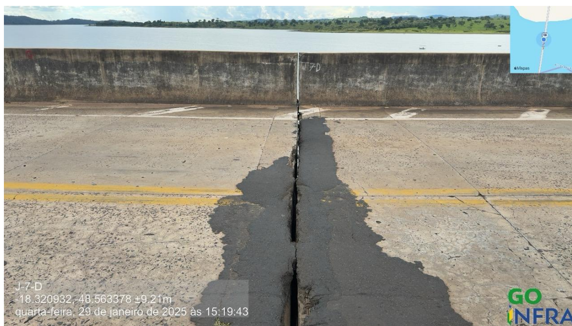
Foto 177 – Junta 7 sentido GO/MG, reparos superficiais
