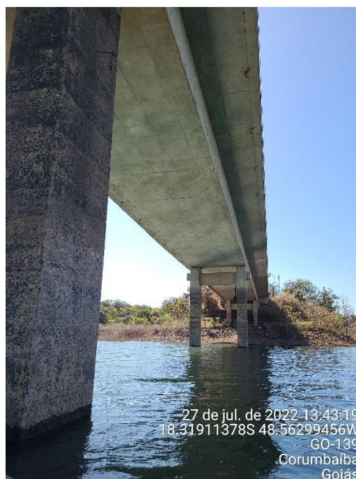
Foto 14 - Vista da parte inferior do segmento pré-fabricado apoiado nas extremidades dos balanços progressivos
