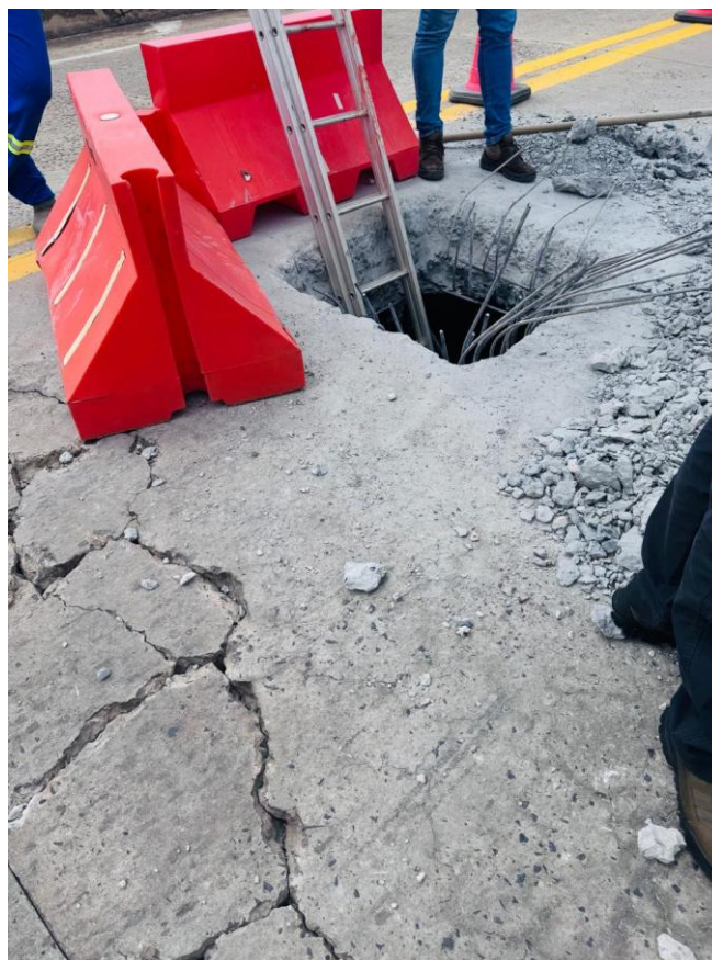
Foto 198 – Abertura do poço de inspeção localizado entre os pilares P6 e P7
