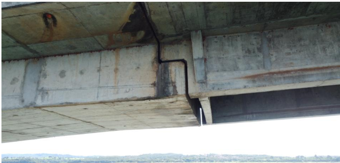
Foto 164 – Vão P13-P14 com detalhes do apoio entre lajes, com marcas de escoamento superficial de água e reparos superficiais. Observação: detalhes dos aparelhos de apoio, em sua maioria rompidos, estão nas imagens iniciais (Coordenadas: 18°19'11.38"S, 48°33'47.06" W)
