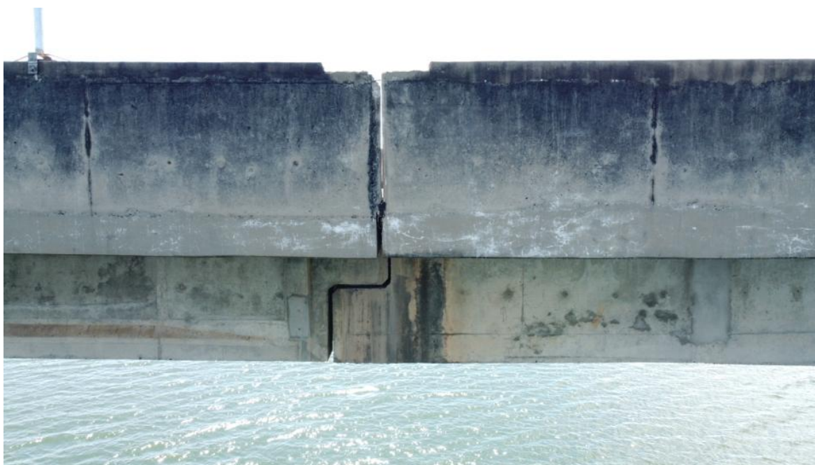
Foto 141 – Vão P7-P8 com detalhes do apoio entre lajes, com marcas de escoamento superficial de água e reparos superficiais. Observação: detalhes dos aparelhos de apoio, em sua maioria rompidos, estão nas imagens iniciais (Coordenadas: 18°19'28.18"S, 48°33'50.64" W)
