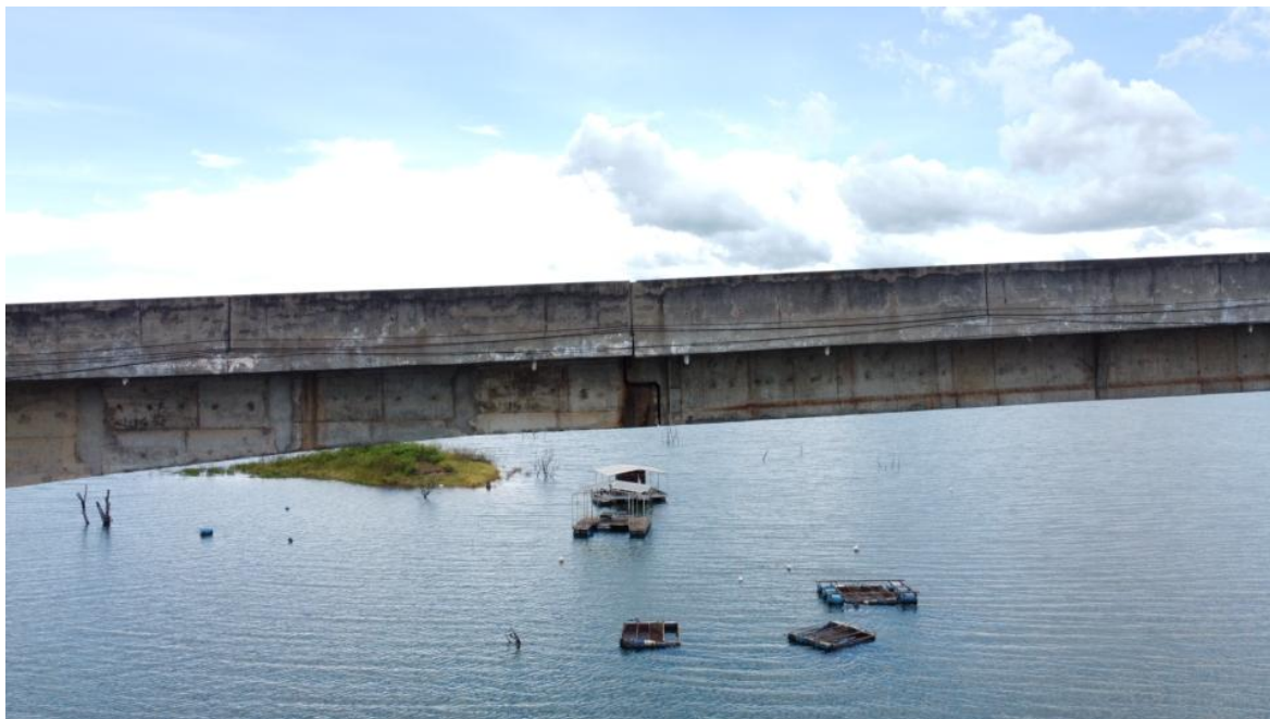
Foto 128 – Vão P3-P4 com detalhes do apoio entre lajes, com marcas de escoamento superficial de água e reparos superficiais. Observação: detalhes dos aparelhos de apoio, em sua maioria rompidos, estão nas imagens iniciais (Coordenadas: 18°19'41.04"S, 48°33'52.76"W)
