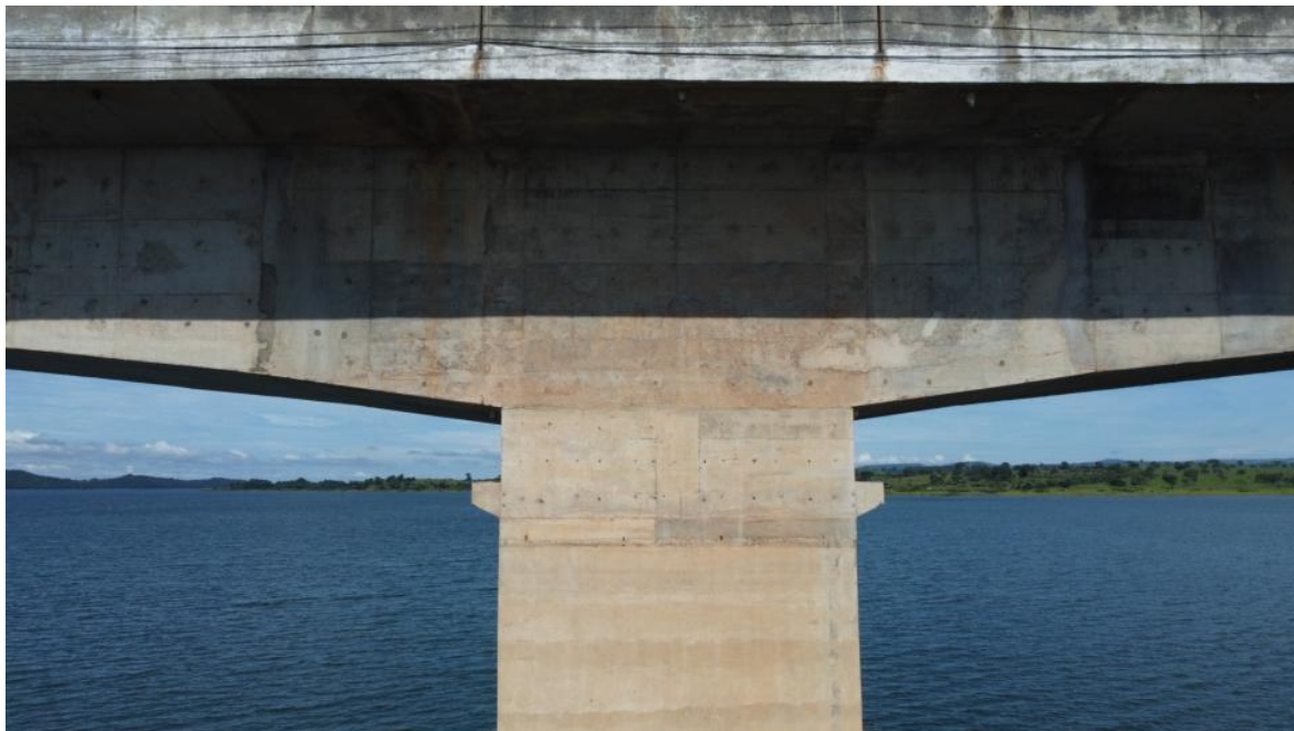
Foto 90 – Pilar P9 íntegro, apenas com desagregação superficial, marcas de escoamento superficial de água e reparos superficiais (Coordenadas: 18°19'23.83"S, 48°33'49.90"W)
