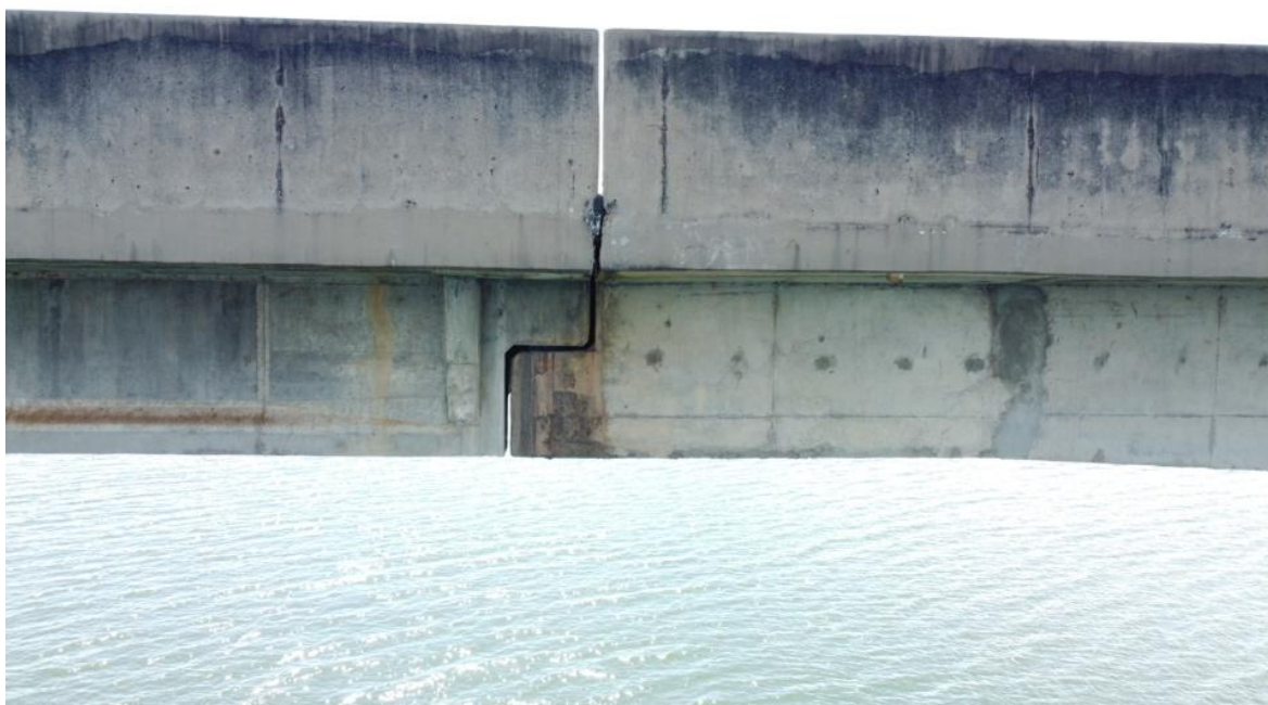
Foto 149 – Vão P9-P10 com detalhes do apoio entre lajes, com marcas de escoamento superficial de água e reparos superficiais. Observação: detalhes dos aparelhos de apoio, em sua maioria rompidos, estão nas imagens iniciais (Coordenadas: 18°19'22.77"S, 48°33'49.72" W)
