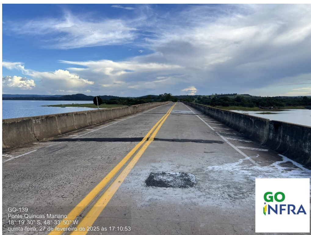
Foto 199 – Poço de inspeção devidamente vedado após inspeção
