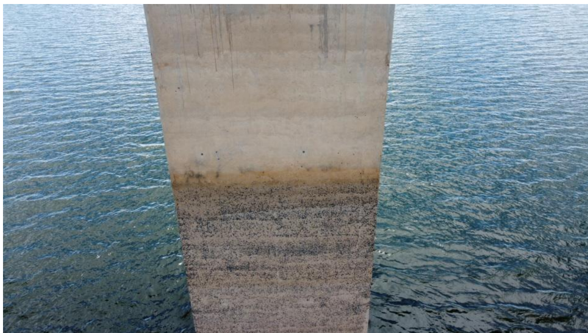
Foto 73 – Pilar P6 íntegro, apenas com desagregação superficial, marcas de escoamento superficial de água e reparos superficiais (Coordenadas: 18°19'32.02"S, 48°33'50.53"W)
