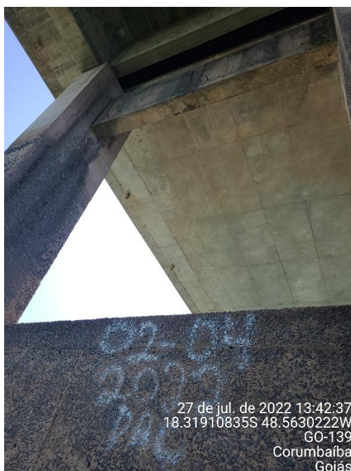
Foto 13 – Vista da parte inferior do segmento pré-fabricado apoiado nas extremidades dos balanços progressivos
