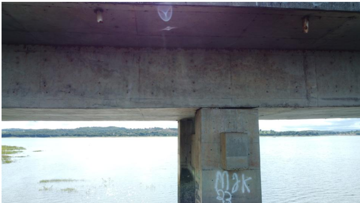
Foto 120 – Pilar P16 íntegro, apenas com desagregação superficial, marcas de escoamento superficial de água e reparos superficiais (Coordenadas: 18°19'7.24"S, 48°33'46.72"W)
