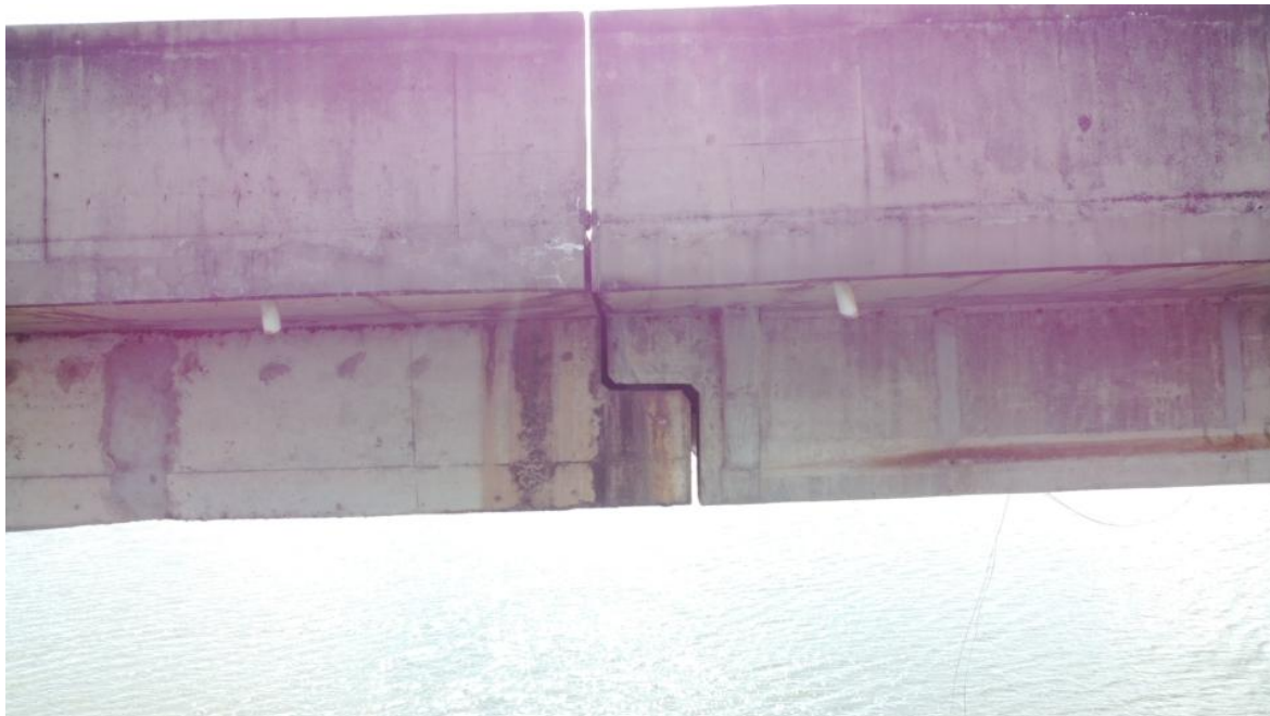
Foto 162 – Vão P12-P13 com detalhes do apoio entre lajes, com marcas de escoamento superficial de água e reparos superficiais. Observação: detalhes dos aparelhos de apoio, em sua maioria rompidos, estão nas imagens iniciais (Coordenadas: 18°19'14.09"S, 48°33'47.48" W)
