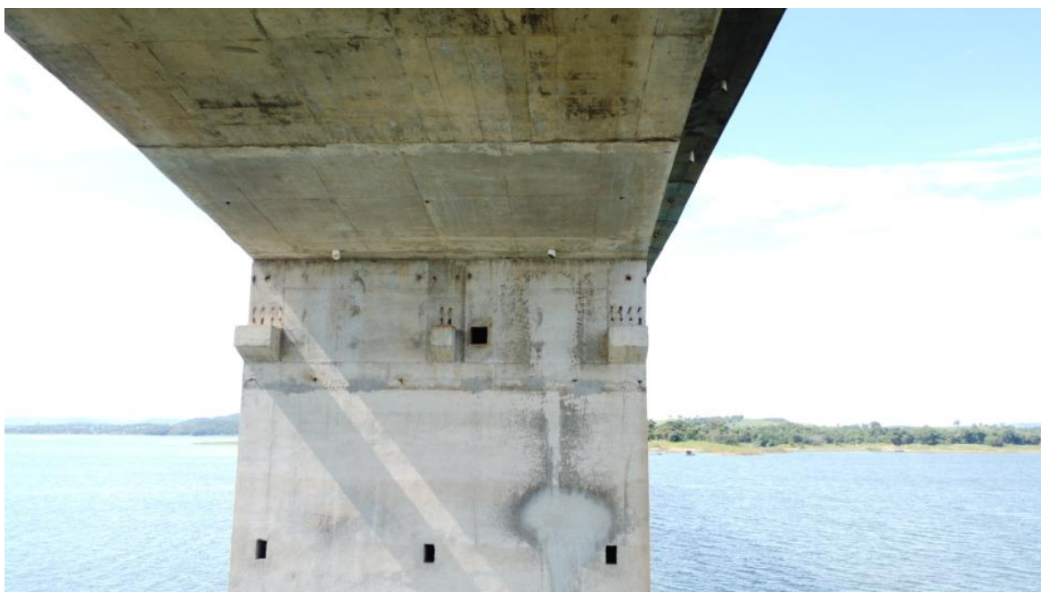
Foto 92 – Pilar P9 íntegro, apenas com desagregação superficial, marcas de escoamento superficial de água e reparos superficiais. Observação: drenos na laje contribuindo para a drenagem interna dos “caixões” (Coordenadas: 18°19'23.83”S, 48°33'49.90”W)
