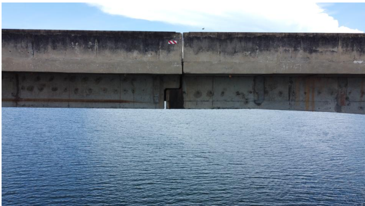
Foto 133 – Vão P5-P6 com detalhes do apoio entre lajes, com marcas de escoamento superficial de água e reparos superficiais. Observação: detalhes dos aparelhos de apoio, em sua maioria rompidos, estão nas imagens iniciais (Coordenadas: 18°19'33.55"S, 48°33'51.66"W)
