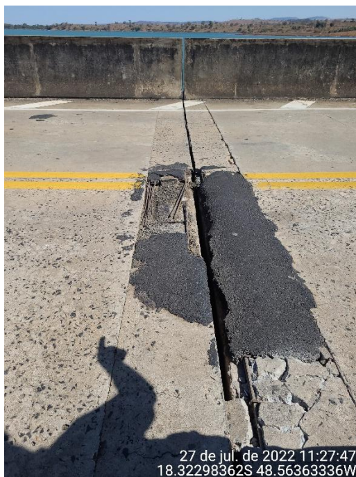
Foto 8 – Detalhe de junta de dilatação vista na pista de rolamento
