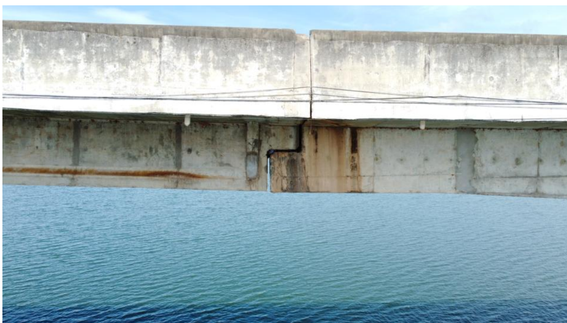
Foto 163 – Vão P13-P14 com detalhes do apoio entre lajes, com marcas de escoamento superficial de água e reparos superficiais. Observação: detalhes dos aparelhos de apoio, em sua maioria rompidos, estão nas imagens iniciais (Coordenadas: 18°19'11.38"S, 48°33'47.06" W)
