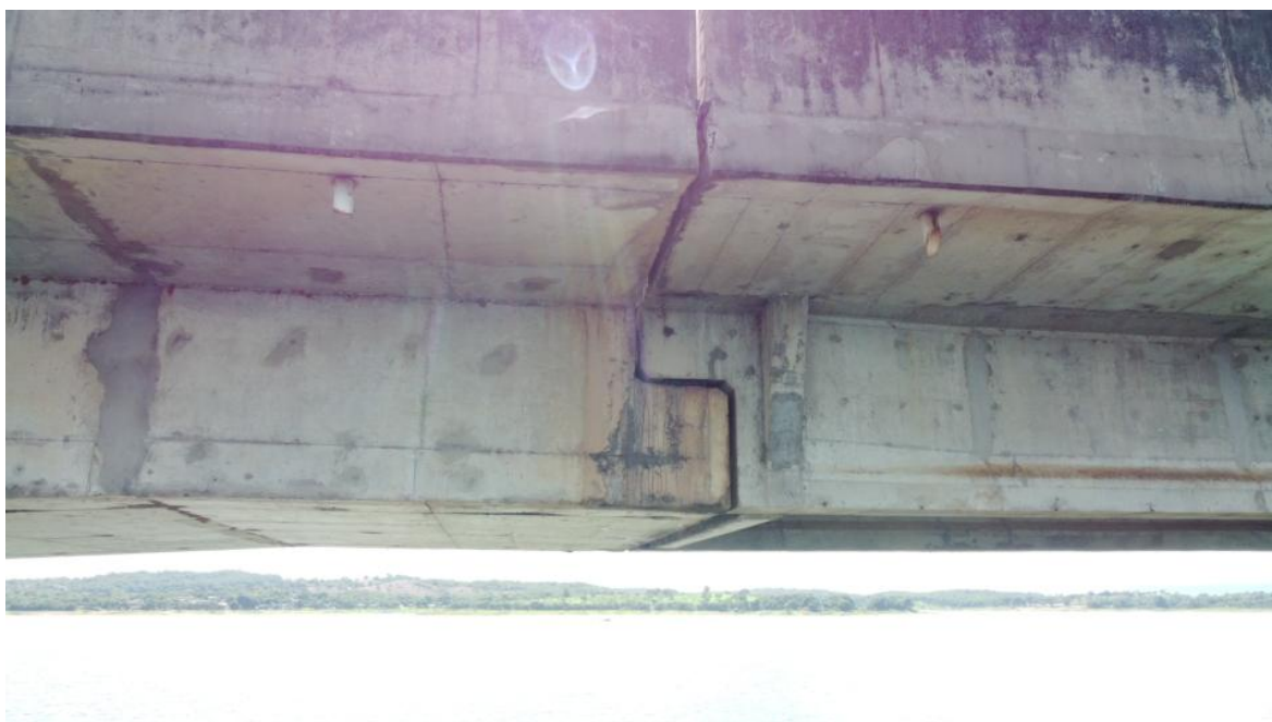
Foto 157 – Vão P11-P12 com detalhes do apoio entre lajes, com marcas de escoamento superficial de água e reparos superficiais. Observação: detalhes dos aparelhos de apoio, em sua maioria rompidos, estão nas imagens iniciais (Coordenadas: 18°19'16.61"S, 48°33'48.70" W)
