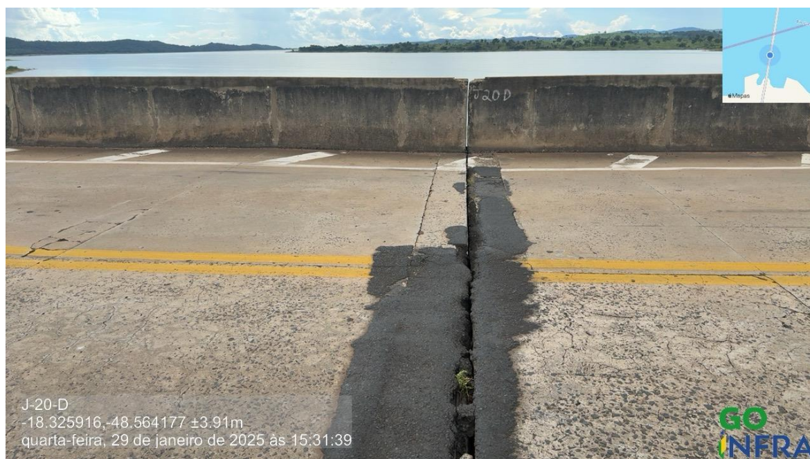
Foto 190 – Junta 20 sentido GO/MG, reparos superficiais
