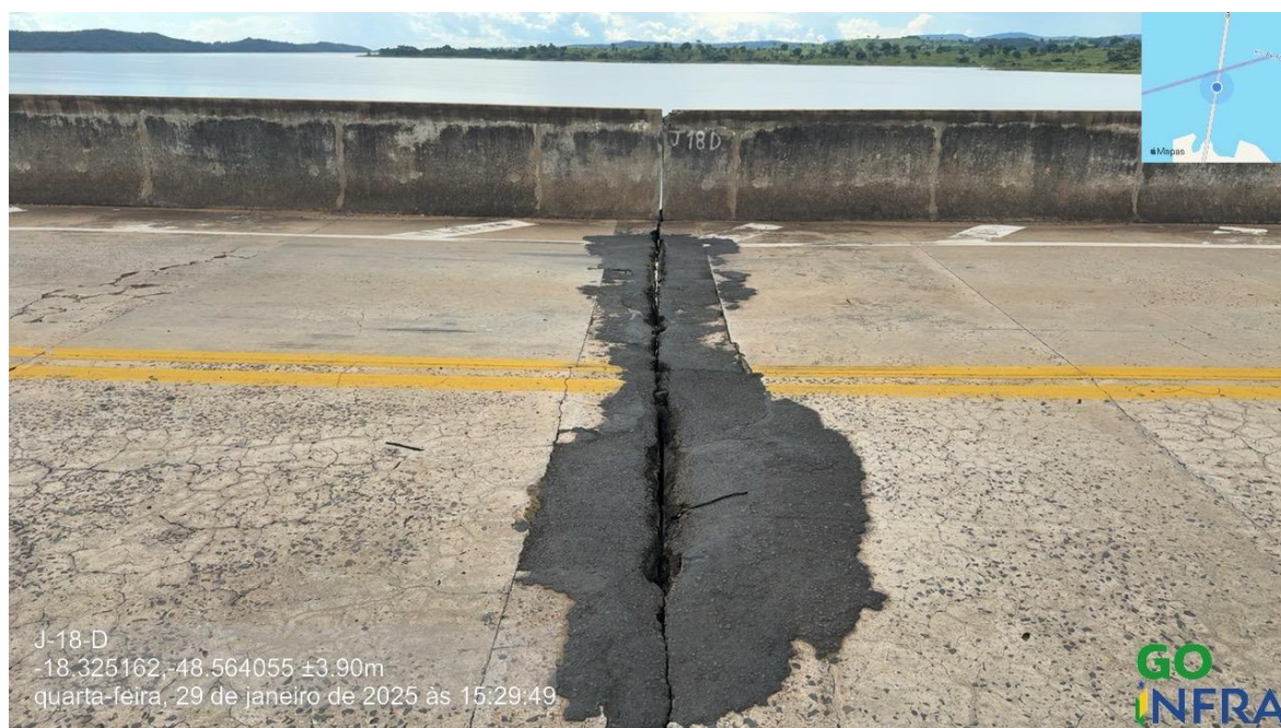
Foto 188 – Junta 18 sentido GO/MG, reparos superficiais
