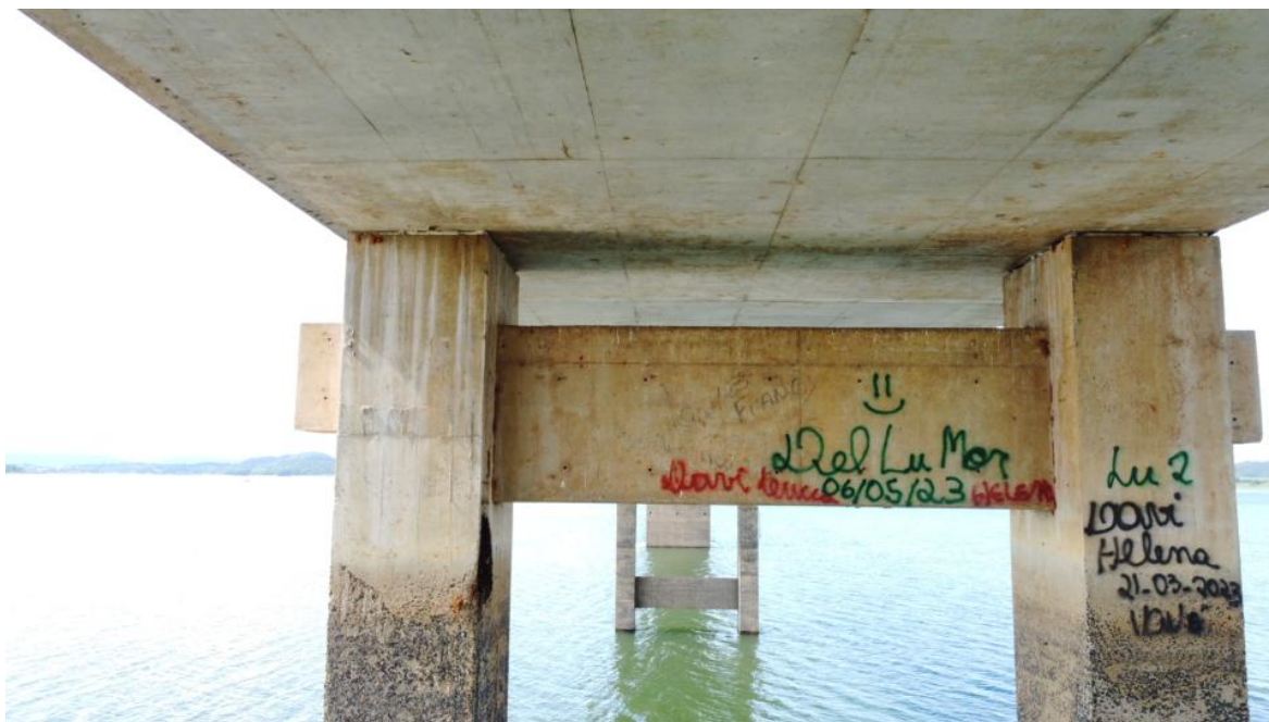
Foto 117 – Pilar P16 íntegro, apenas com desagregação superficial, marcas de escoamento superficial de água e reparos superficiais (Coordenadas: 18°19'7.24"S, 48°33'46.72"W)
