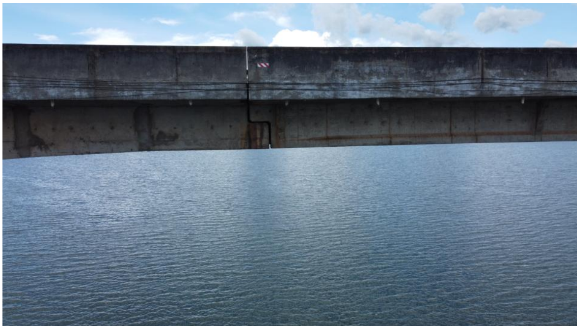
Foto 134 – Vão P5-P6 com detalhes do apoio entre lajes, com marcas de escoamento superficial de água e reparos superficiais. Observação: detalhes dos aparelhos de apoio, em sua maioria rompidos, estão nas imagens iniciais (Coordenadas: 18°19'33.55"S, 48°33'51.66"W)
