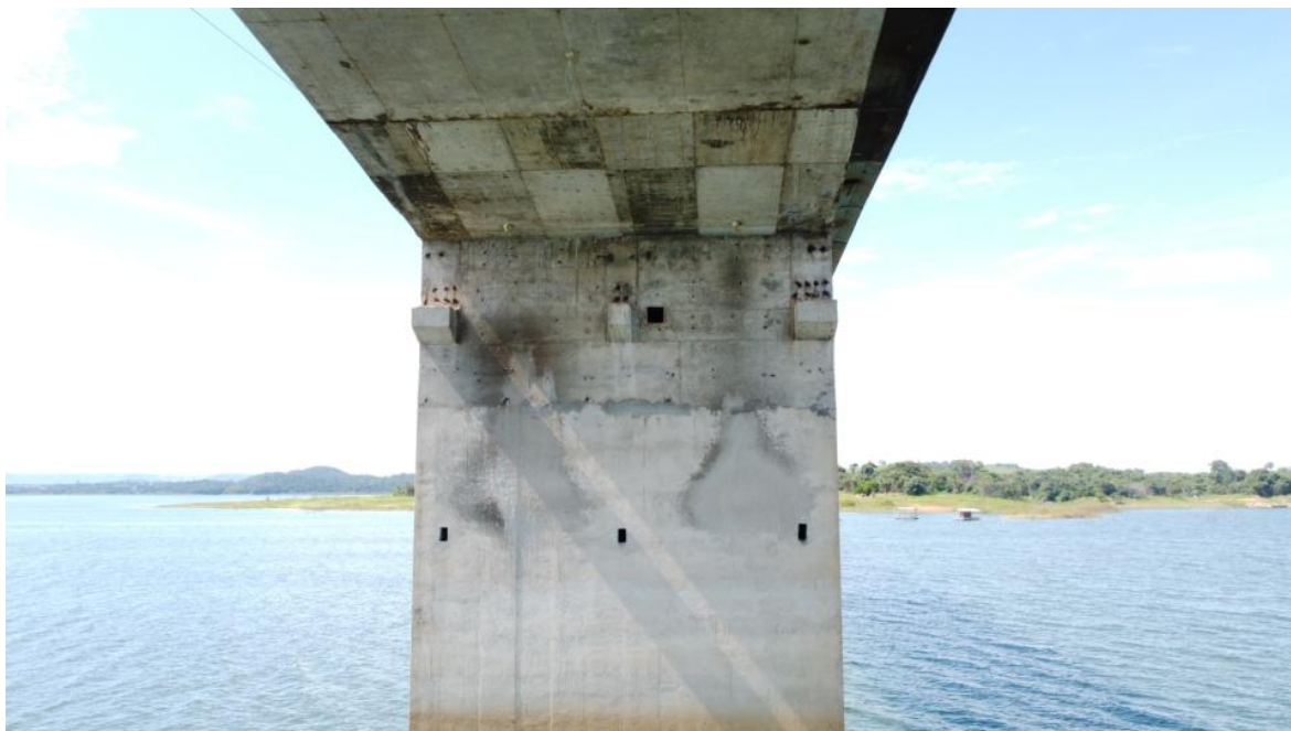
Foto 77 – Pilar P7 íntegro, apenas com desagregação superficial, marcas de escoamento superficial de água e reparos superficiais. Observação: drenos na laje contribuindo para a drenagem interna dos “caixões” (Coordenadas: 18°19'29.20"S, 48°33'50.75"W)
