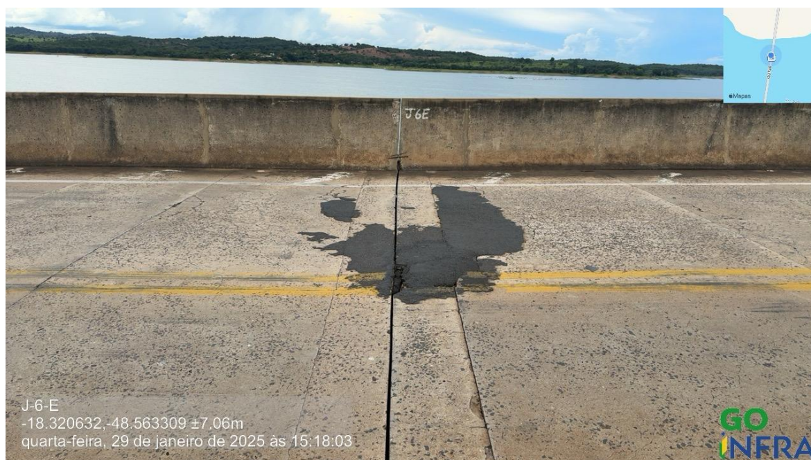
Foto 176 – Junta 6 sentido GO/MG, reparos superficiais
