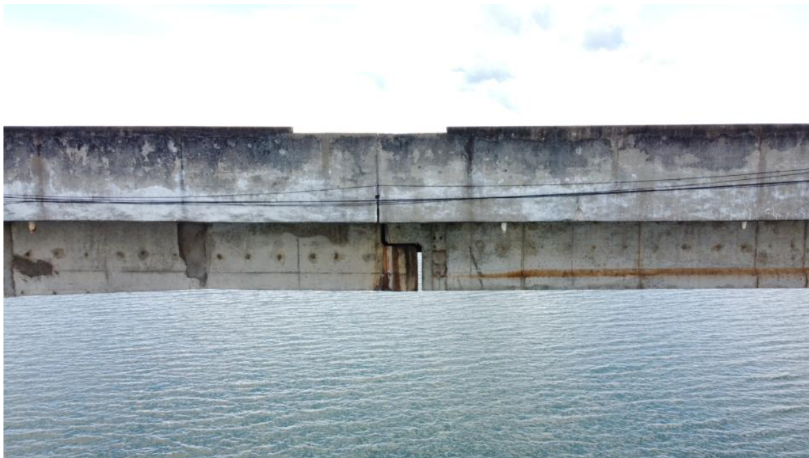
Foto 138 – Vão P6-P7 com detalhes do apoio entre lajes, com marcas de escoamento superficial de água e reparos superficiais. Observação: detalhes dos aparelhos de apoio, em sua maioria rompidos, estão nas imagens iniciais (Coordenadas: 18°19'30.86"S, 48°33'51.11"W)
