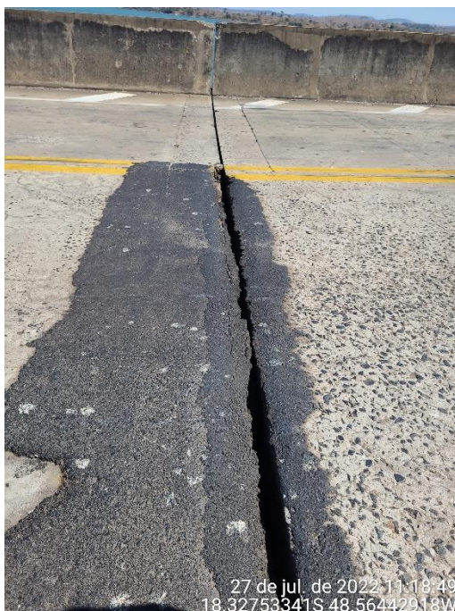
Foto 5 – Detalhe de junta de dilatação vista na pista de rolamento
