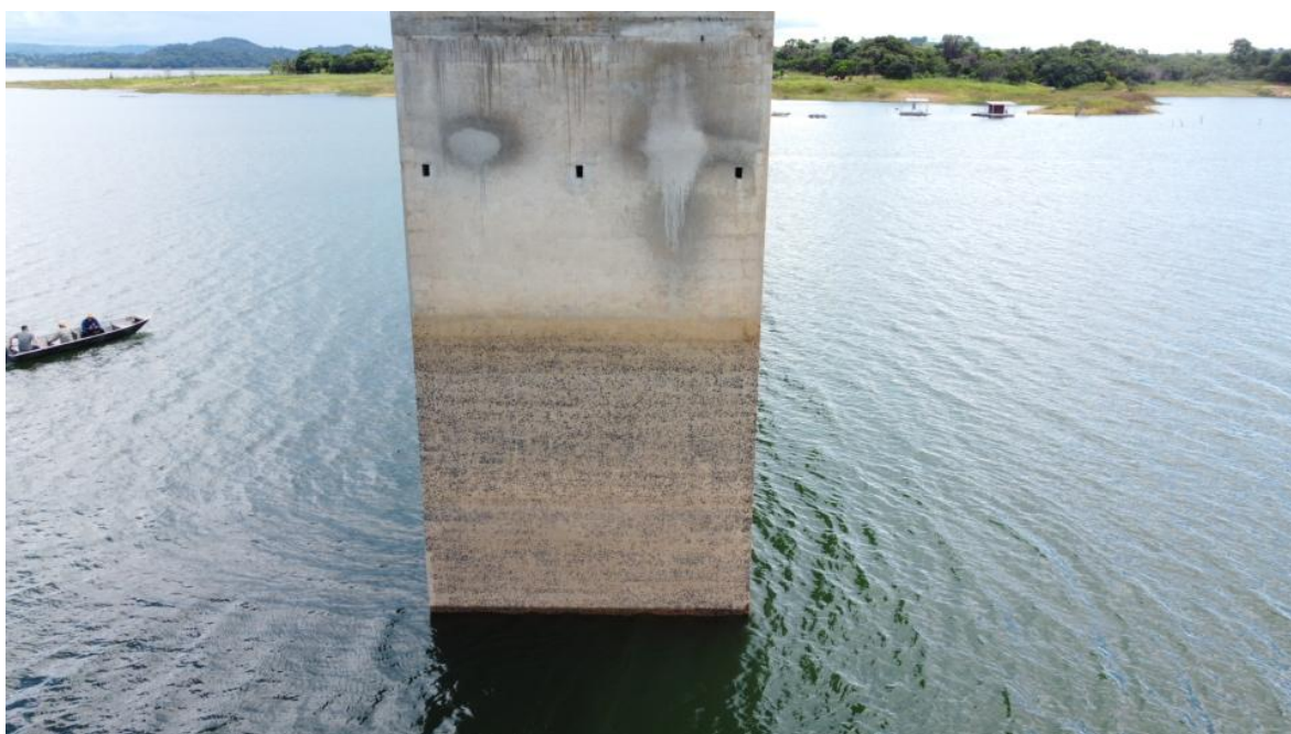
Foto 71 – Pilar P6 íntegro, apenas com desagregação superficial, marcas de escoamento superficial de água e reparos superficiais (Coordenadas: 18°19'32.02”S, 48°33'50.53”W)
