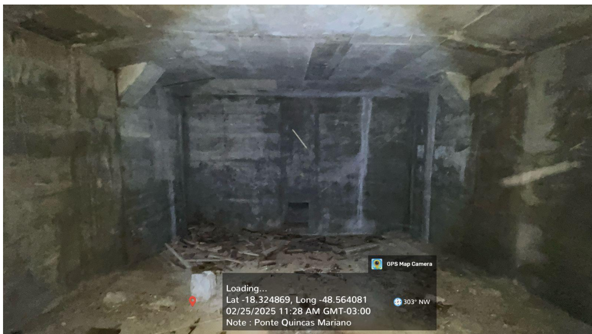
Foto 206 – Vista aproximada das “paredes” da parte interna da estrutura localizada entre os pilares P6 e P7, íntegras e sem identificação de patologia que comprometa sua função estrutural
