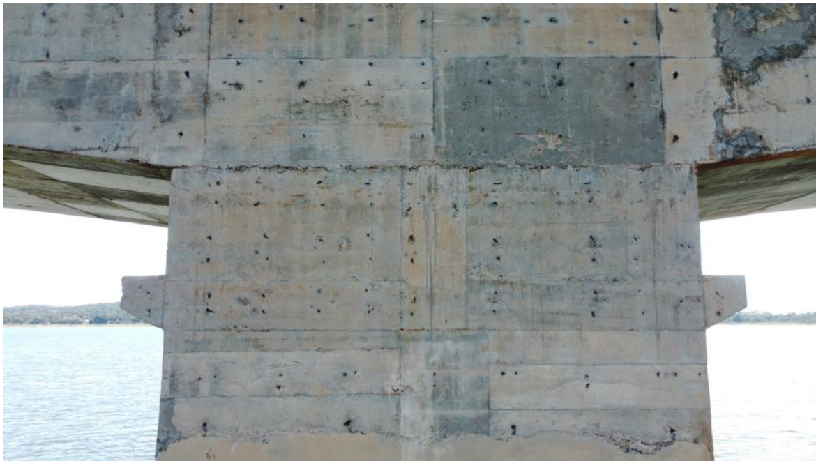
Foto 76 – Pilar P7 íntegro, apenas com desagregação superficial, marcas de escoamento superficial de água e reparos superficiais (Coordenadas: 18°19'29.20"S, 48°33'50.75"W)
