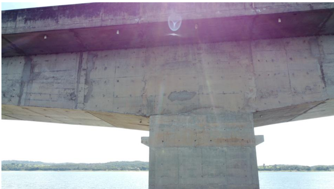
Foto 101 – Pilar P12 íntegro, apenas com desagregação superficial, marcas de escoamento superficial de água e reparos superficiais (Coordenadas: 18°19'15.63"S, 48°33'48.68"W)
