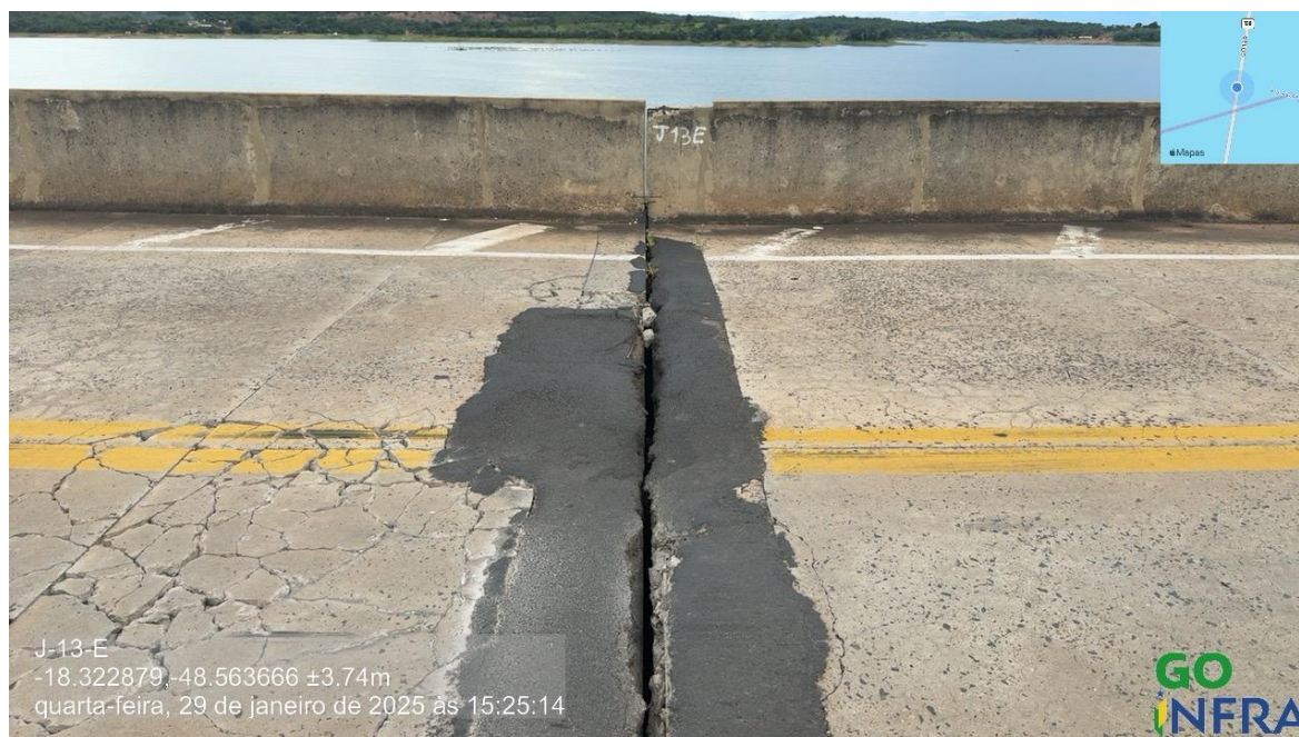
Foto 183 – Junta 13 sentido GO/MG, armadura exposta de laje de sacrifício e reparos superficiais
