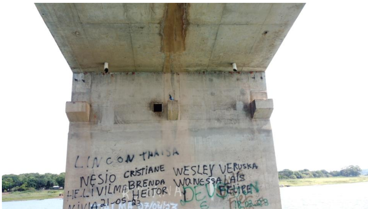
Foto 108 – Pilar P13 íntegro, apenas com desagregação superficial, marcas de escoamento superficial de água de pequenas infiltrações do caixão e reparos superficiais. Observação: drenos na laje contribuindo para a drenagem interna dos “caixões” (Coordenadas: 18°19'12.94”S, 48°33'48.13”W)
