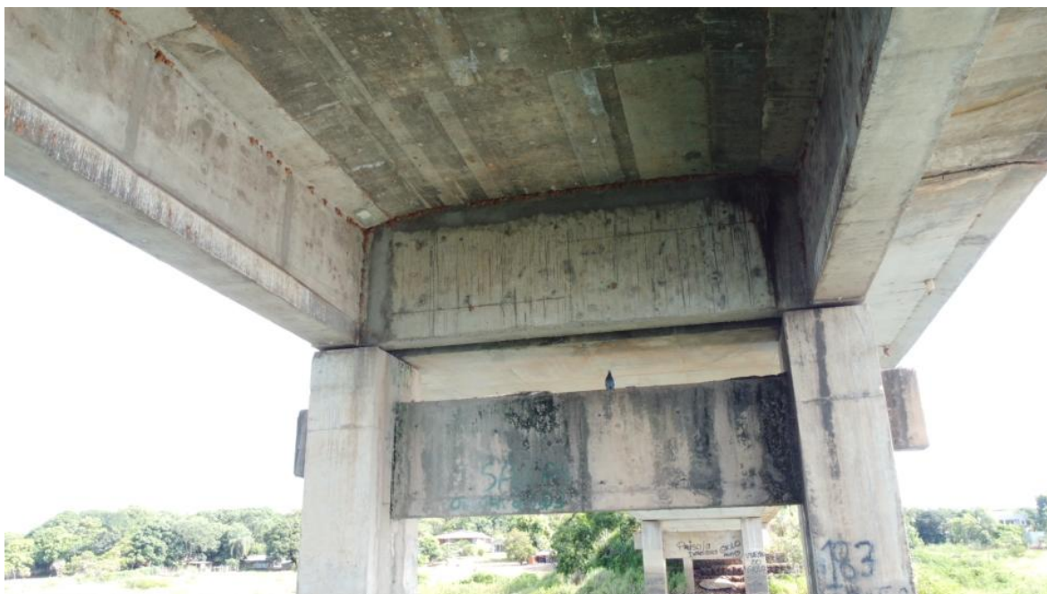
Foto 115 – Pilar P15 íntegro, apenas com desagregação superficial, marcas de escoamento superficial de água e reparos superficiais (Coordenadas: 18°19'8.32"S, 48°33'46.85"W)
