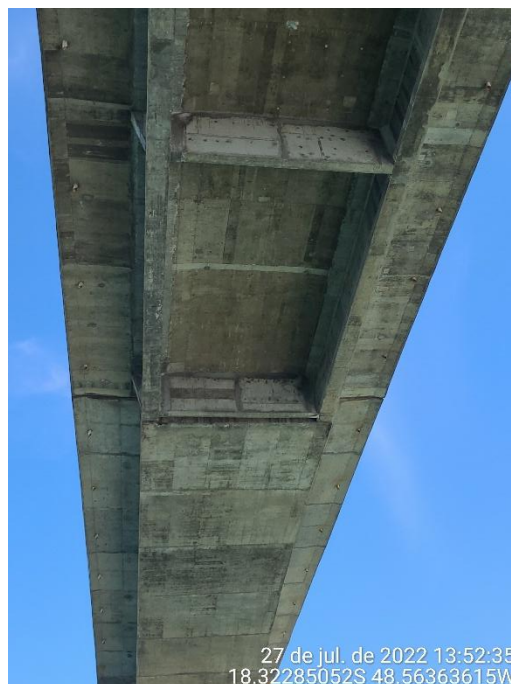
Foto 22 – Vista da parte inferior do segmento pré-fabricado apoiado nas extremidades dos balanços progressivos
