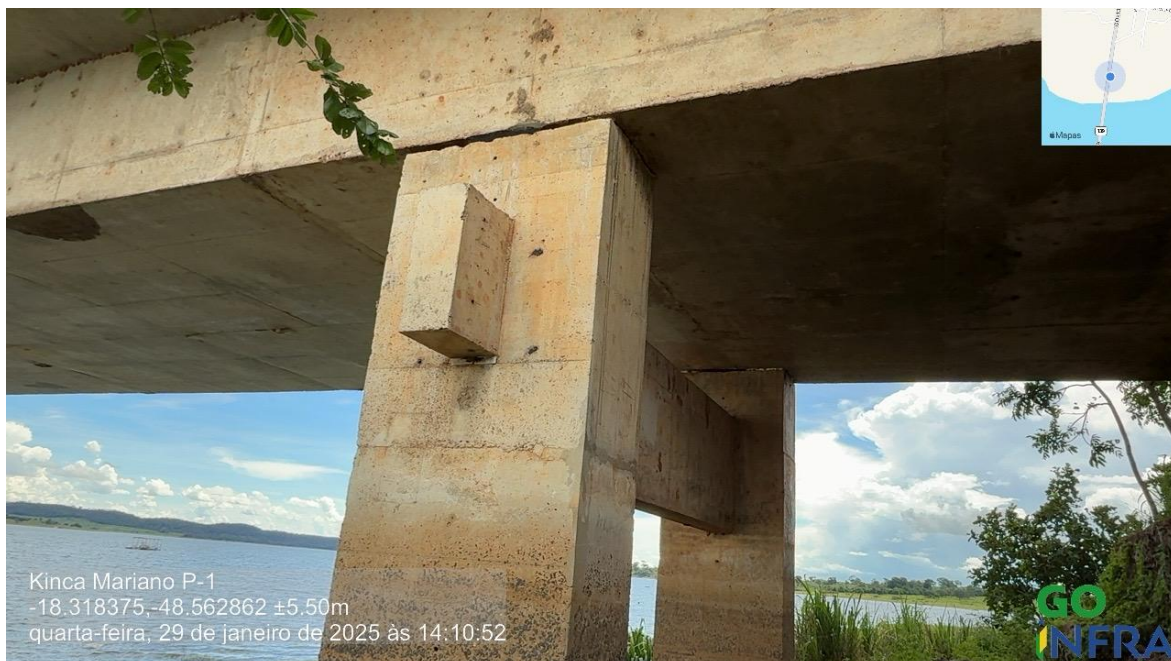
Foto 121 – Pilar P17 íntegro, apenas com desagregação superficial, marcas de escoamento superficial de água e reparos superficiais (Coordenadas: 18°19'6.15"S, 48°33'46.30"W)
