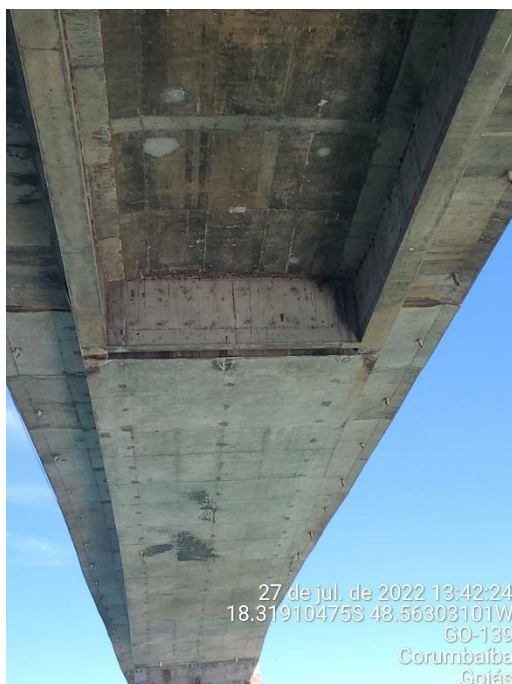
Foto 11 – Vista da parte inferior do segmento pré-fabricado apoiado nas extremidades dos balanços progressivos
