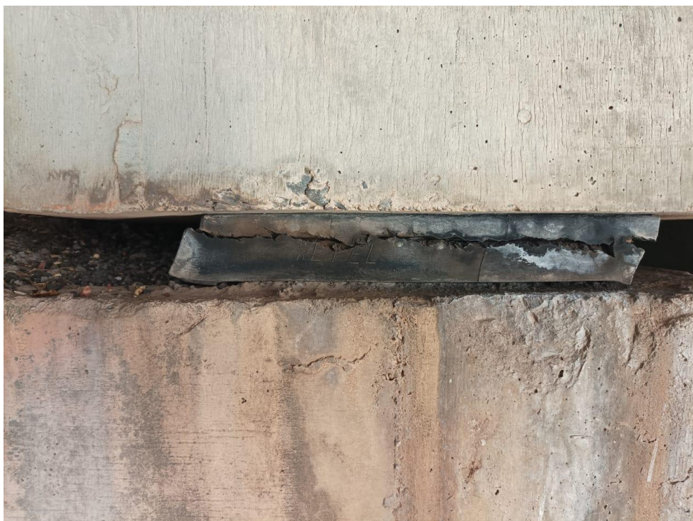
Foto 47 – Detalhe do neopreme existente
