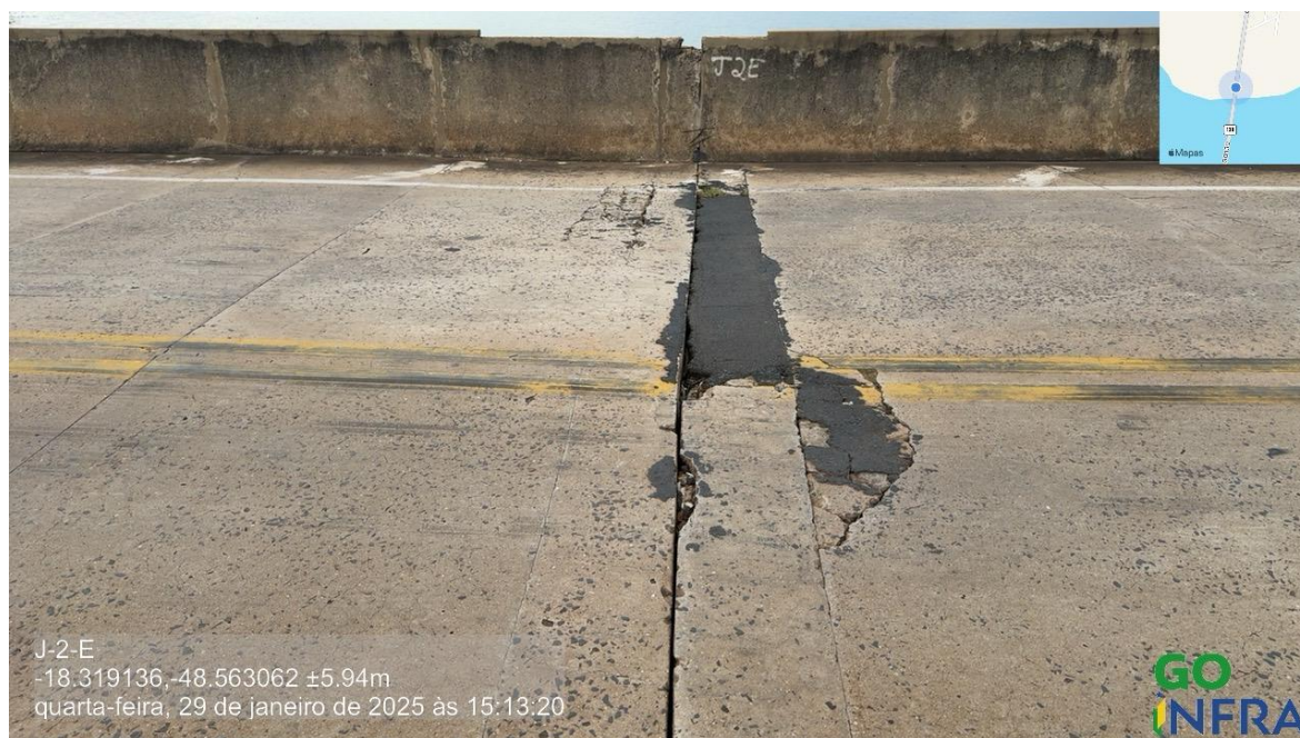
Foto 172 – Junta 2 sentido GO/MG, reparos superficiais
