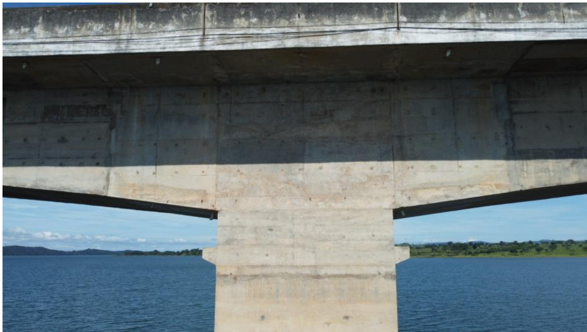
Foto 94 – Pilar P10 íntegro, apenas com desagregação superficial, marcas de escoamento superficial de água e reparos superficiais (Coordenadas: 18°19'20.66"S, 48°33'48.92"W)
