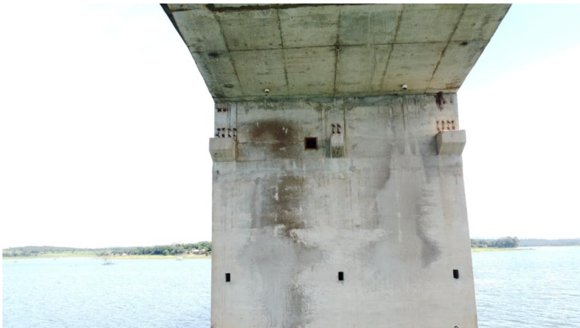
Foto 88 – Pilar P8 íntegro, apenas com desagregação superficial, marcas de escoamento superficial de água e reparos superficiais. Observação: drenos na laje contribuindo para a drenagem interna dos “caixões” (Coordenadas: 18°19'26.45"S, 48°33'50.40"W)
