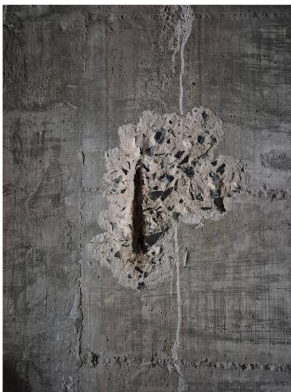
Foto 215 – Desagregação pontual, para a qual deverá ser utilizada a solução 1 da Nota Técnica
