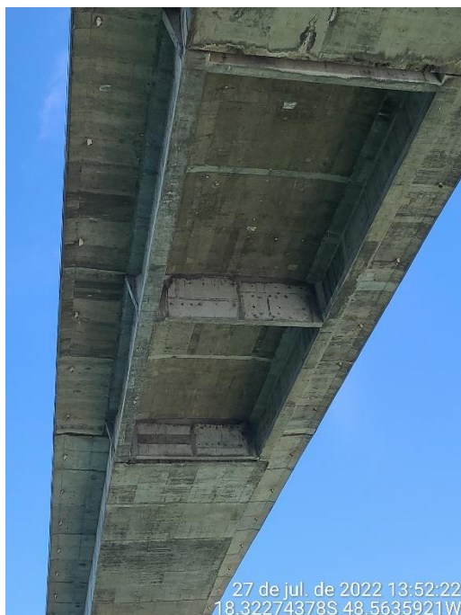
Foto 21 – Vista da parte inferior do segmento pré-fabricado apoiado nas extremidades dos balanços progressivos
