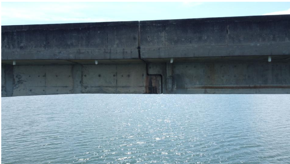
Foto 155 – Vão P10-P11 com detalhes do apoio entre lajes, com marcas de escoamento superficial de água e reparos superficiais. Observação: detalhes dos aparelhos de apoio, em sua maioria rompidos, estão nas imagens iniciais (Coordenadas: 18°19'19.40"S, 48°33'49.25" W)
