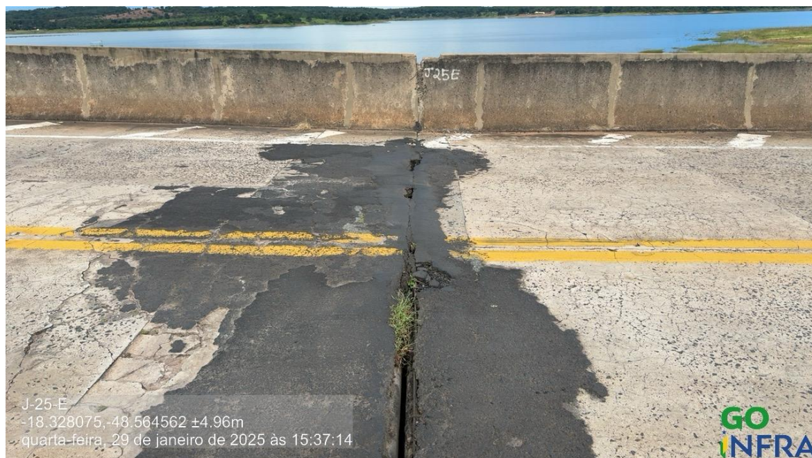
Foto 195 – Junta 25 sentido GO/MG, armadura exposta de laje de sacrifício e reparos superficiais
