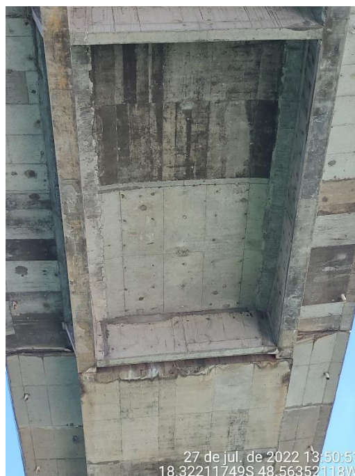
Foto 20 – Vista da parte inferior do segmento pré-fabricado apoiado nas extremidades dos balanços progressivos
