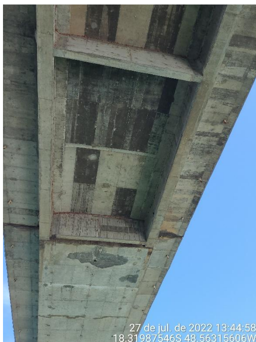
Foto 17 – Vista da parte inferior do segmento pré-fabricado apoiado nas extremidades dos balanços progressivos
