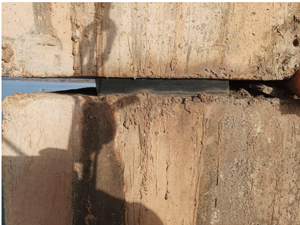
Foto 42 – Detalhe do neopreme existente
