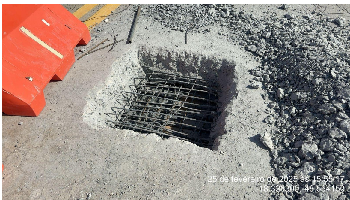
Foto 197 – Abertura do poço de inspeção localizado entre os pilares P6 e P7
