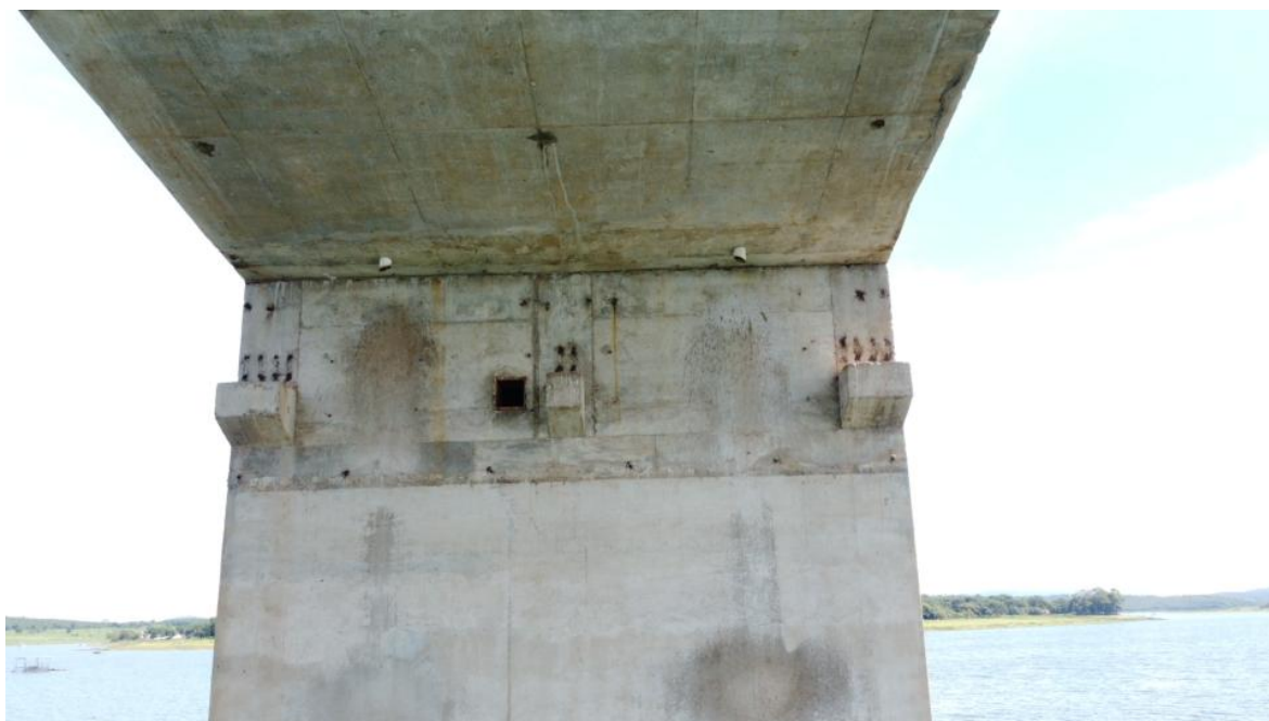
Foto 91 – Pilar P9 íntegro, apenas com desagregação superficial, marcas de escoamento superficial de água e reparos superficiais. Observação: drenos na laje contribuindo para a drenagem interna dos “caixões” (Coordenadas: 18°19'23.83"S, 48°33'49.90"W)
