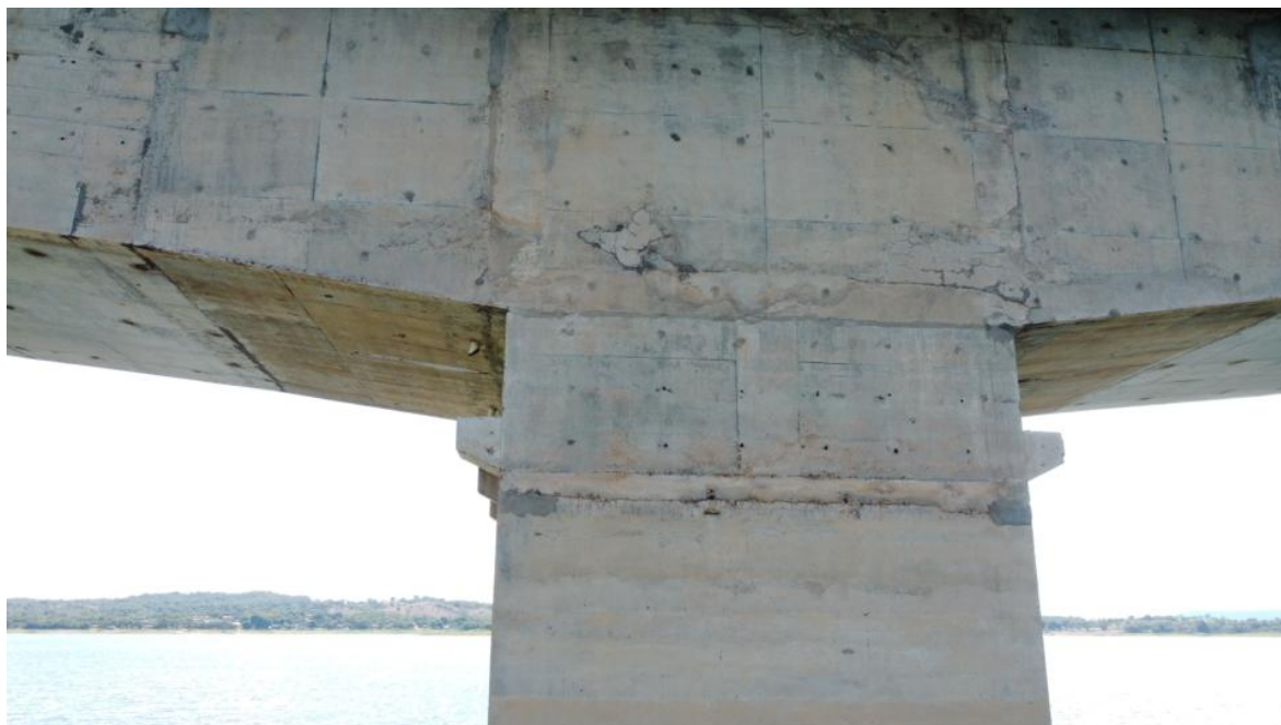
Foto 98 – Pilar P11 íntegro, apenas com desagregação superficial, marcas de escoamento superficial de água e reparos superficiais. Observação: drenos na laje contribuindo para a drenagem interna dos “caixões” (Coordenadas: 18°19'18.06"S, 48°33'48.63"W)
