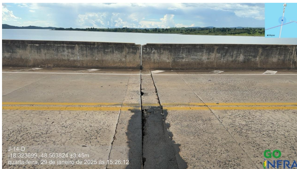
Foto 184 – Junta 14 sentido GO/MG, reparos superficiais
