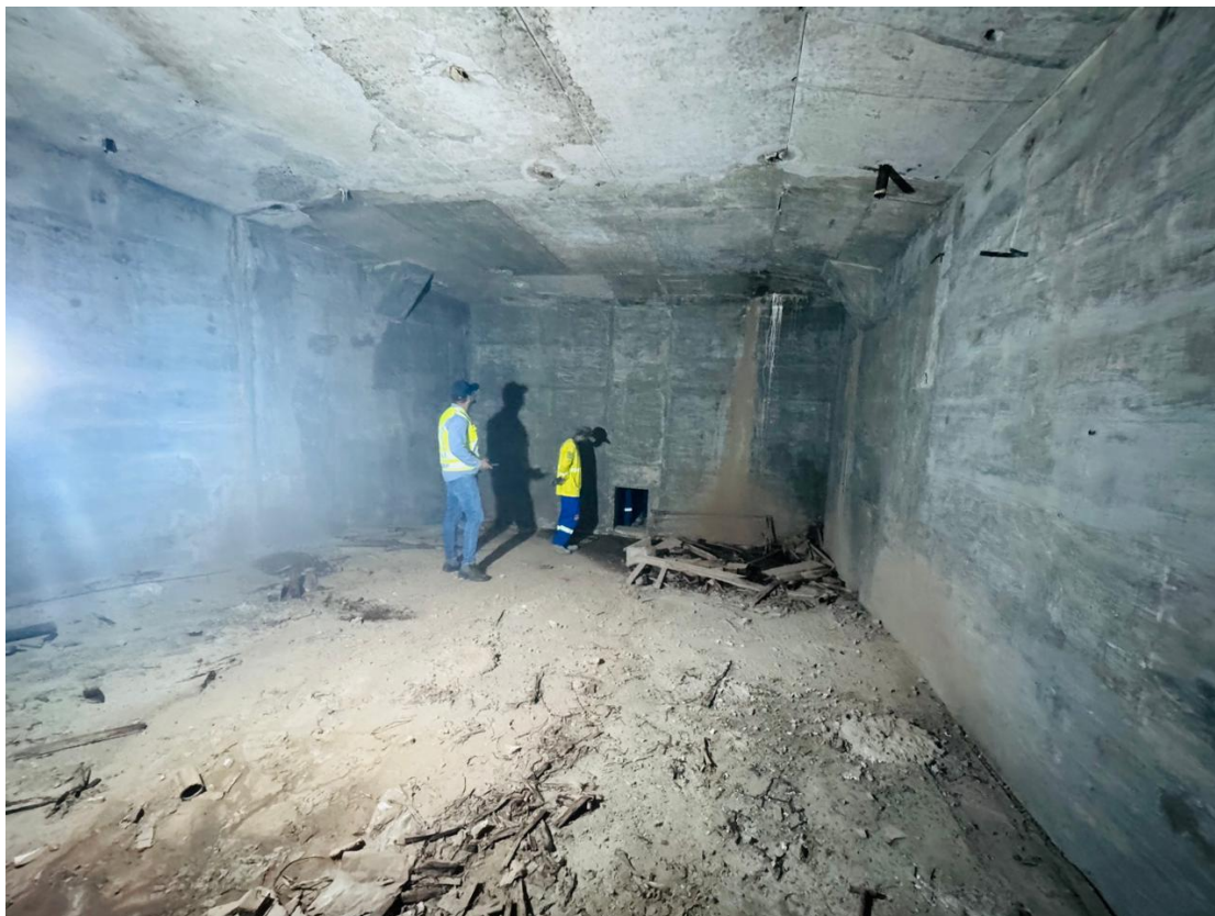
Foto 203 – Vista aproximada das “paredes” da parte interna da estrutura localizada entre os pilares P6 e P7, íntegras e sem identificação de patologia que comprometa sua função estrutural
