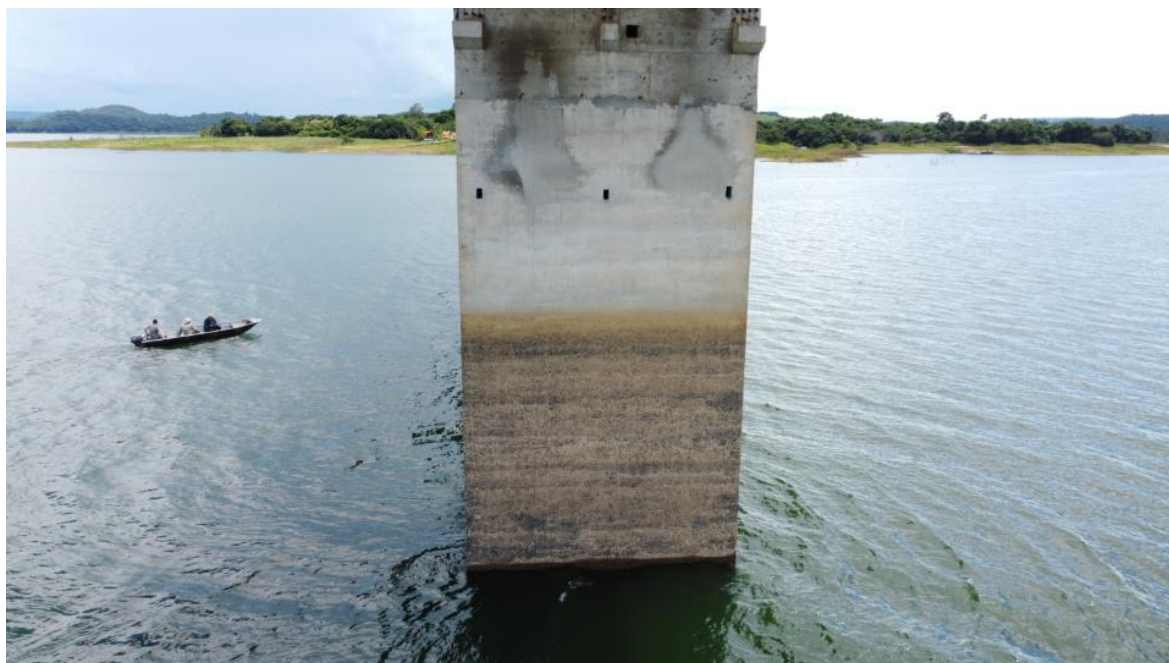
Foto 81 – Pilar P7 íntegro, apenas com desagregação superficial, marcas de escoamento superficial de água e reparos superficiais (Coordenadas: 18°19'29.20"S, 48°33'50.75"W)
