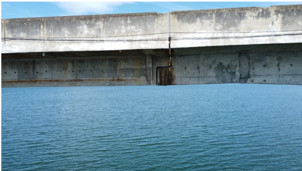
Foto 144 – Vão P7-P8 com detalhes do apoio entre lajes, com marcas de escoamento superficial de água e reparos superficiais. Observação: detalhes dos aparelhos de apoio, em sua maioria rompidos, estão nas imagens iniciais (Coordenadas: 18°19'27.51"S, 48°33'50.59" W)
