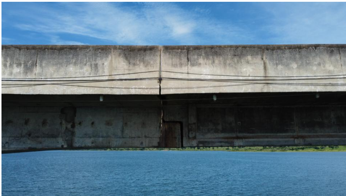
Foto 146 – Vão P8-P9 com detalhes do apoio entre lajes, com marcas de escoamento superficial de água e reparos superficiais. Observação: detalhes dos aparelhos de apoio, em sua maioria rompidos, estão nas imagens iniciais (Coordenadas: 18°19'25.45"S, 48°33'50.30" W)
