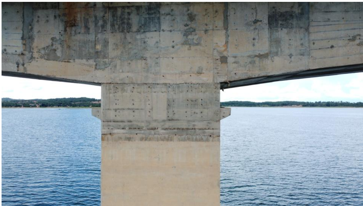
Foto 69 – Pilar P5 íntegro, apenas com desagregação superficial, marcas de escoamento superficial de água e reparos superficiais (Coordenadas: 18°19'34.03"S, 48°33'51.27"W)
