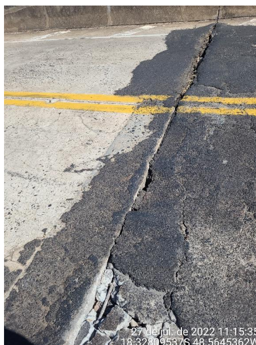
Foto 3 – Detalhe de junta de dilatação e desagregação na pista de rolamento
