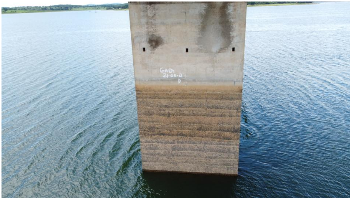
Foto 62 – Pilar P4 íntegro, apenas com desagregação superficial, marcas de escoamento superficial de água e reparos superficiais (Coordenadas: 18°19'36.79"S, 48°33'51.63"W)
