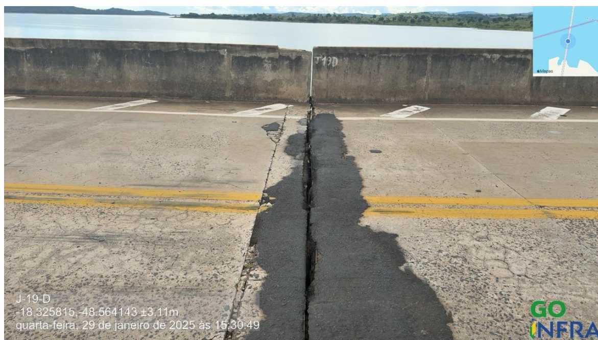
Foto 189 – Junta 19 sentido GO/MG, reparos superficiais
