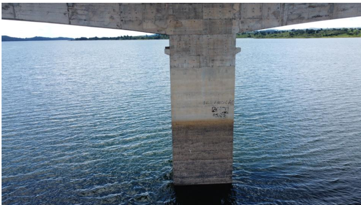
Foto 79 – Pilar P7 íntegro, apenas com desagregação superficial, marcas de escoamento superficial de água e reparos superficiais. Observação: drenos na laje contribuindo para a drenagem interna dos “caixões” (Coordenadas: 18°19'29.20"S, 48°33'50.75"W)
