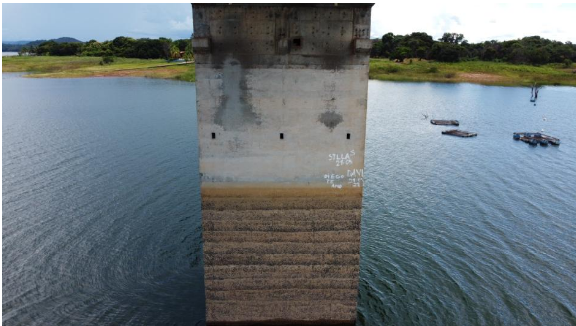
Foto 60 – Pilar P4 íntegro, apenas com desagregação superficial, marcas de escoamento superficial de água e reparos superficiais (Coordenadas: 18°19'36.79"S, 48°33'51.63"W)
