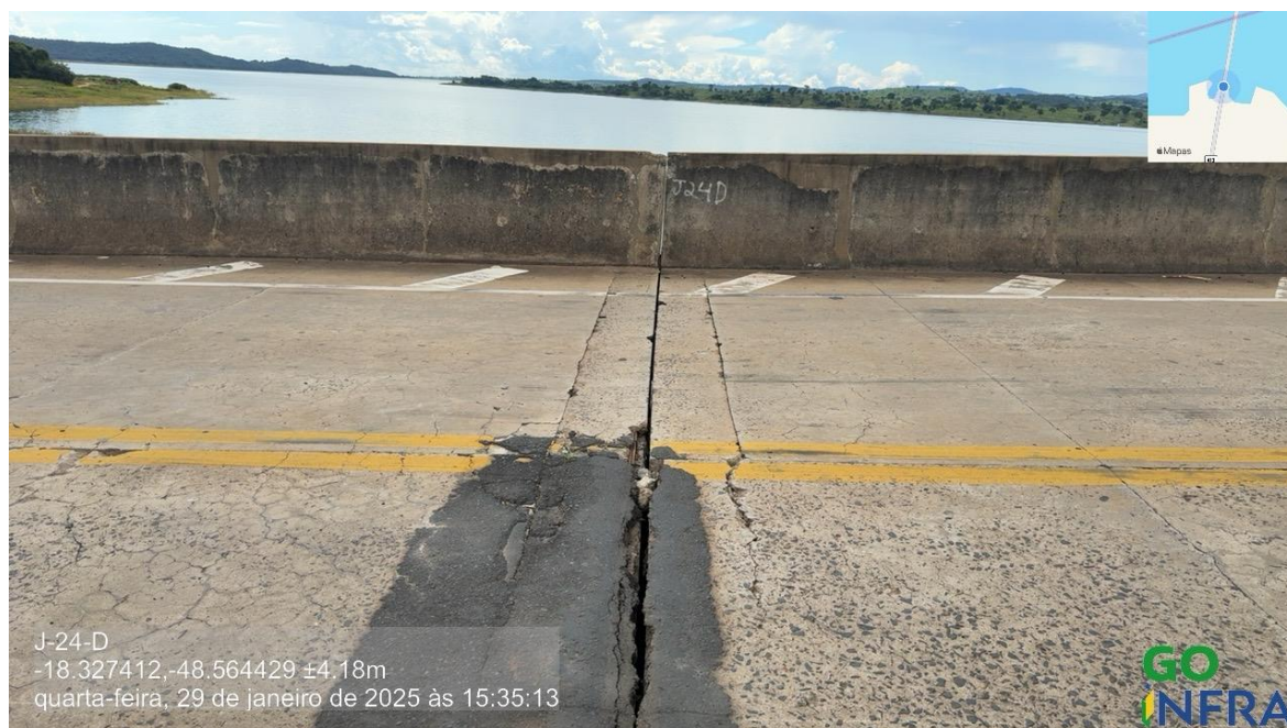
Foto 194 – Junta 24 sentido GO/MG, armadura exposta de laje de sacrifício e reparos superficiais
