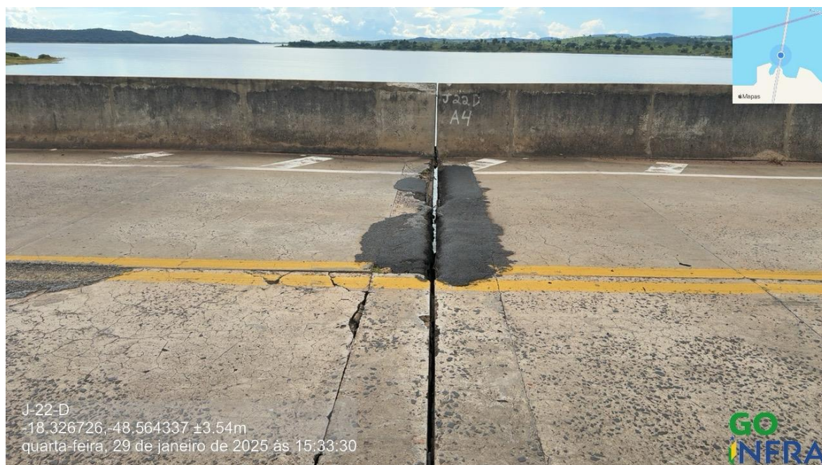
Foto 192 – Junta 22 sentido GO/MG, armadura exposta de laje de sacrifício e reparos superficiais
