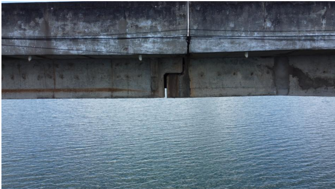
Foto 140 – Vão P6-P7 com detalhes do apoio entre lajes, com marcas de escoamento superficial de água e reparos superficiais. Observação: detalhes dos aparelhos de apoio, em sua maioria rompidos, estão nas imagens iniciais (Coordenadas: 18°19'30.18"S, 48°33'51" W)
