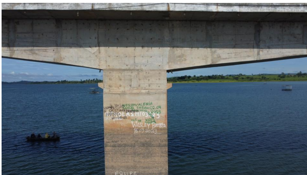
Foto 107 – Pilar P13 íntegro, apenas com desagregação superficial, marcas de escoamento superficial de água e reparos superficiais (Coordenadas: 18°19'12.94”S, 48°33'48.13”W)
