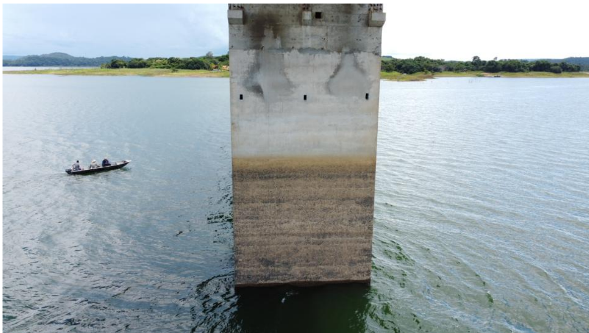
Foto 82 – Pilar P7 íntegro, apenas com desagregação superficial, marcas de escoamento superficial de água e reparos superficiais (Coordenadas: 18°19'29.20"S, 48°33'50.75"W)
