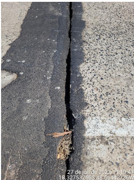
Foto 6 – Detalhe de junta de dilatação vista na pista de rolamento
