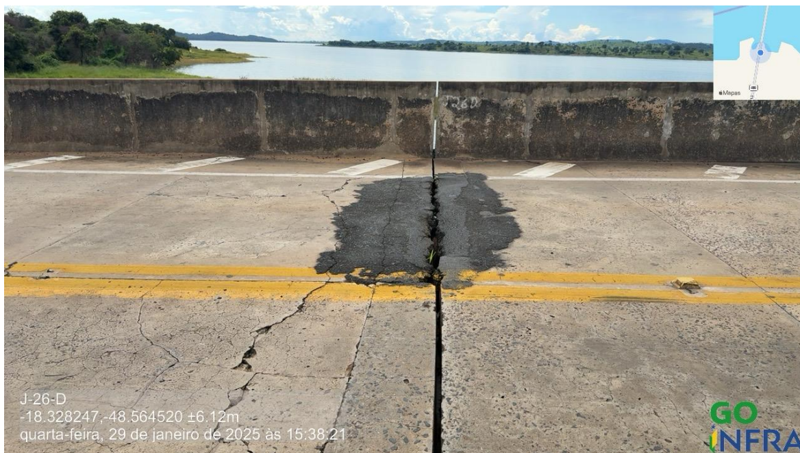
Foto 196 – Junta 26 sentido GO/MG, reparos superficiais
