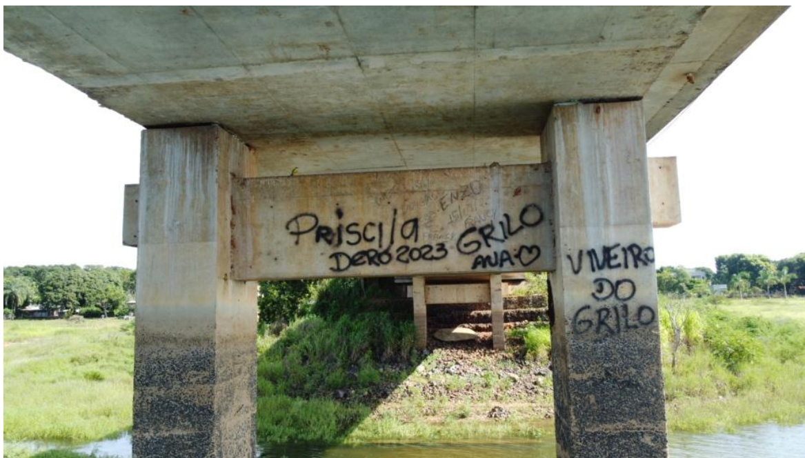
Foto 119 – Pilar P16 íntegro, apenas com desagregação superficial, marcas de escoamento superficial de água e reparos superficiais (Coordenadas: 18°19'7.24"S, 48°33'46.72"W)
