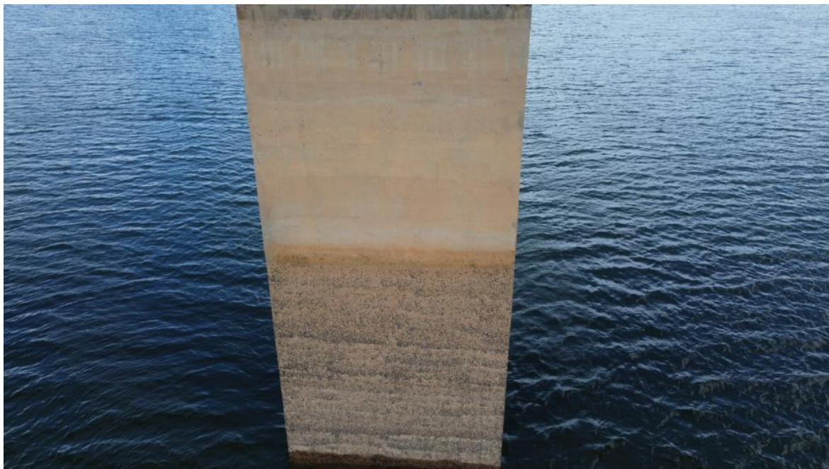
Foto 68 – Pilar P5 íntegro, apenas com desagregação superficial, marcas de escoamento superficial de água e reparos superficiais (Coordenadas: 18°19'34.03"S, 48°33'51.27"W)
