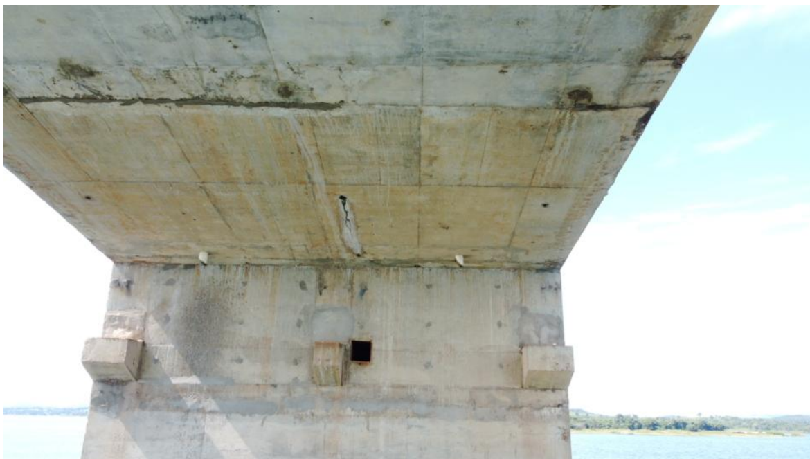
Foto 97 – Pilar P11 íntegro, apenas com desagregação superficial, marcas de escoamento superficial de água e reparos superficiais. Observação: drenos na laje contribuindo para a drenagem interna dos “caixões” (Coordenadas: 18°19'18.06"S, 48°33'48.63"W)
