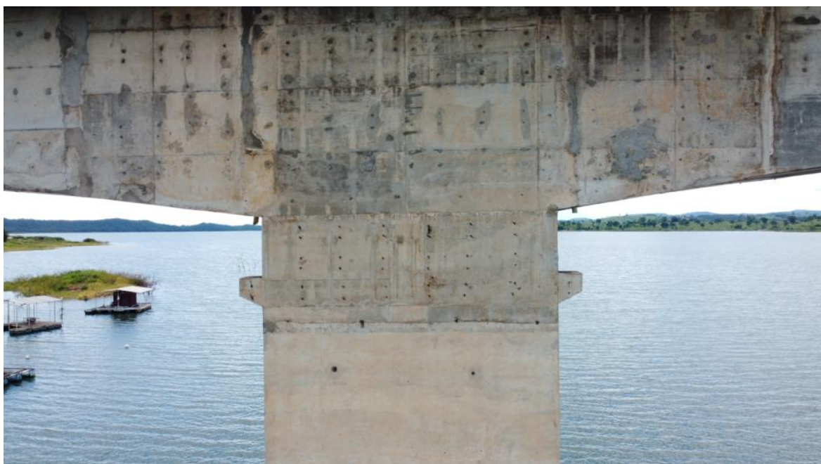
Foto 61 – Pilar P4 íntegro, apenas com desagregação superficial, marcas de escoamento superficial de água e reparos superficiais (Coordenadas: 18°19'36.79"S, 48°33'51.63"W)
