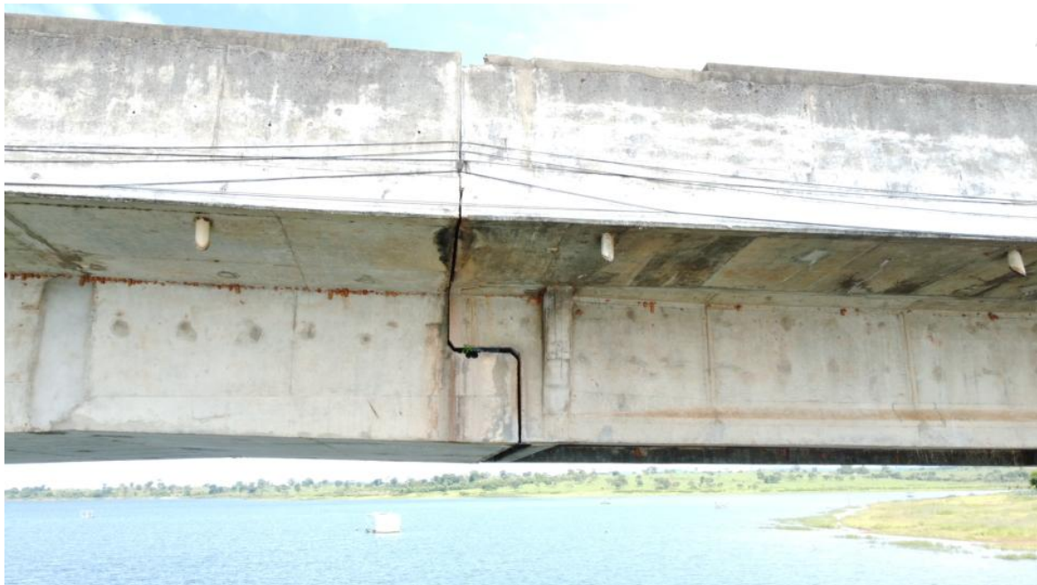
Foto 166 – Vão P14-P15 com detalhes do apoio entre lajes, com marcas de escoamento superficial de água e reparos superficiais. Observação: detalhes dos aparelhos de apoio, em sua maioria rompidos, estão nas imagens iniciais (Coordenadas: 18°19'9.17"S, 48°33'47.41" W)
