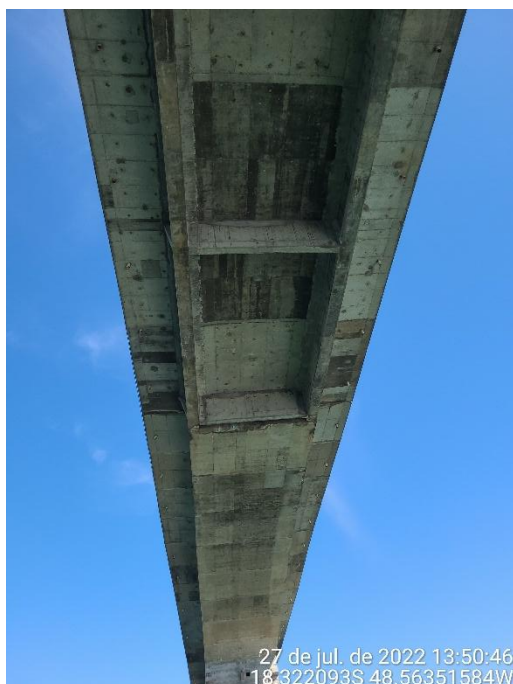
Foto 19 – Vista da parte inferior do segmento pré-fabricado apoiado nas extremidades dos balanços progressivos
