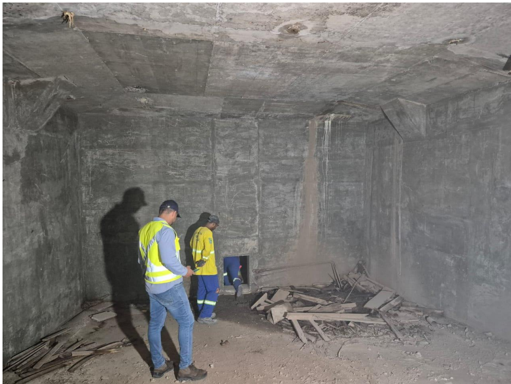
Foto 215 – Desagregação pontual, para a qual deverá ser utilizada a solução 1 da Nota Técnica
