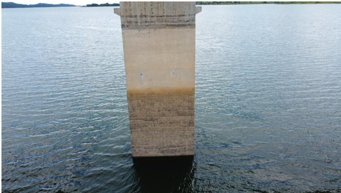
Foto 66 – Pilar P5 íntegro, apenas com desagregação superficial, marcas de escoamento superficial de água e reparos superficiais (Coordenadas: 18°19'34.03"S, 48°33'51.27"W)
