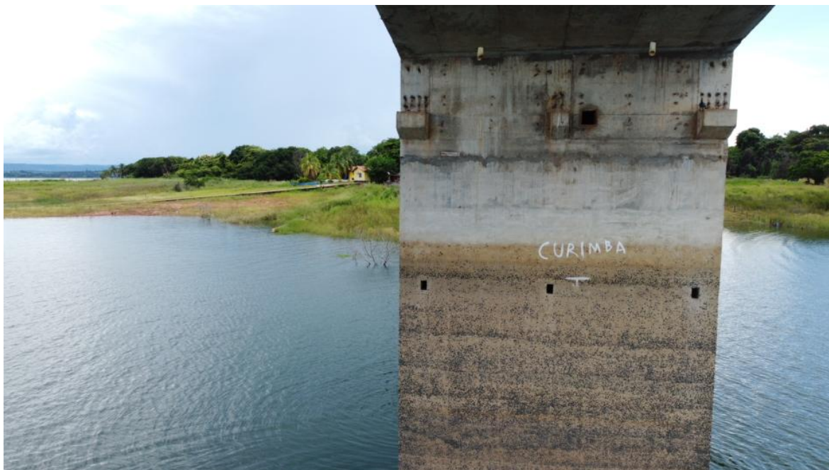
Foto 56 – Pilar P3 íntegro, apenas com desagregação superficial e marcas de escoamento superficial de água (Coordenadas: 18°19'39.60"S, 48°33'52.08"W)
