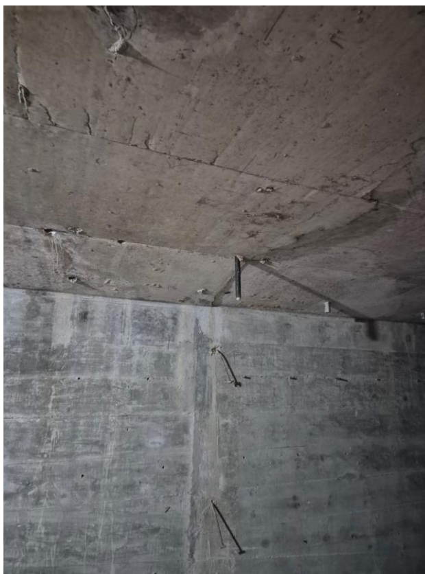
Foto 217 – Vista interna do caixão sem indicações de patologias
