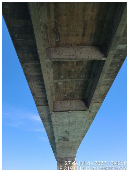
Foto 12 - Vista da parte inferior do segmento pré-fabricado apoiado nas extremidades dos balanços progressivos
