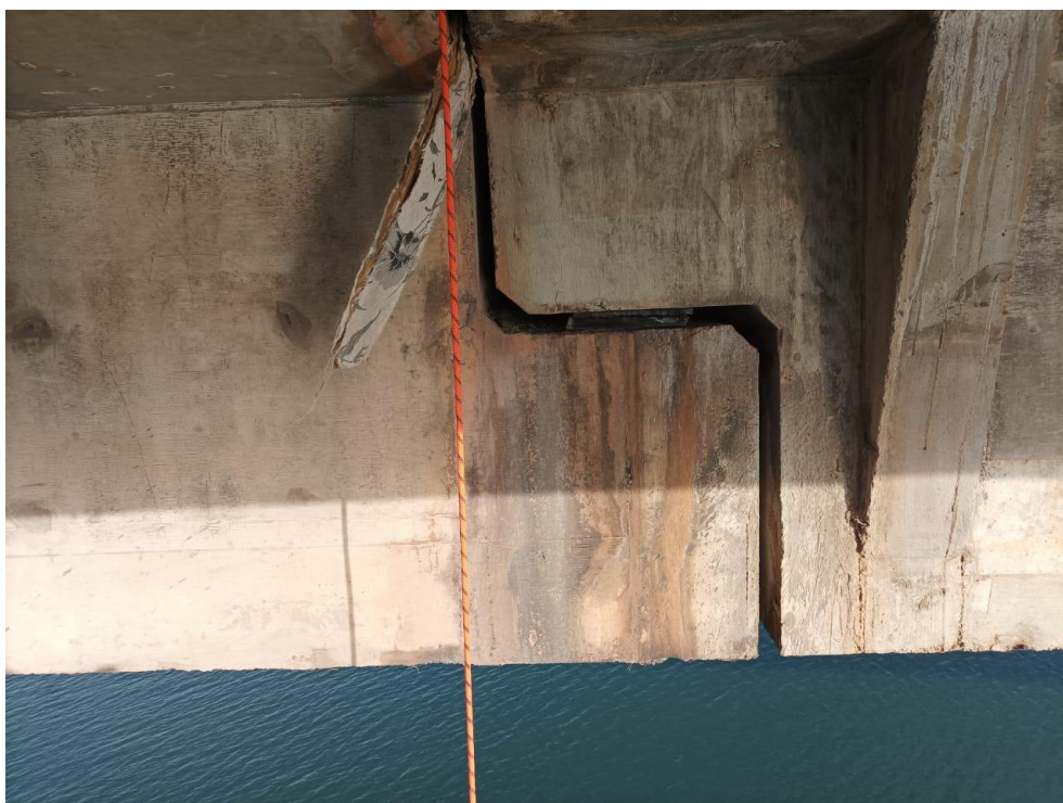
Foto 44 – Detalhe de encontro de viga Gerber
