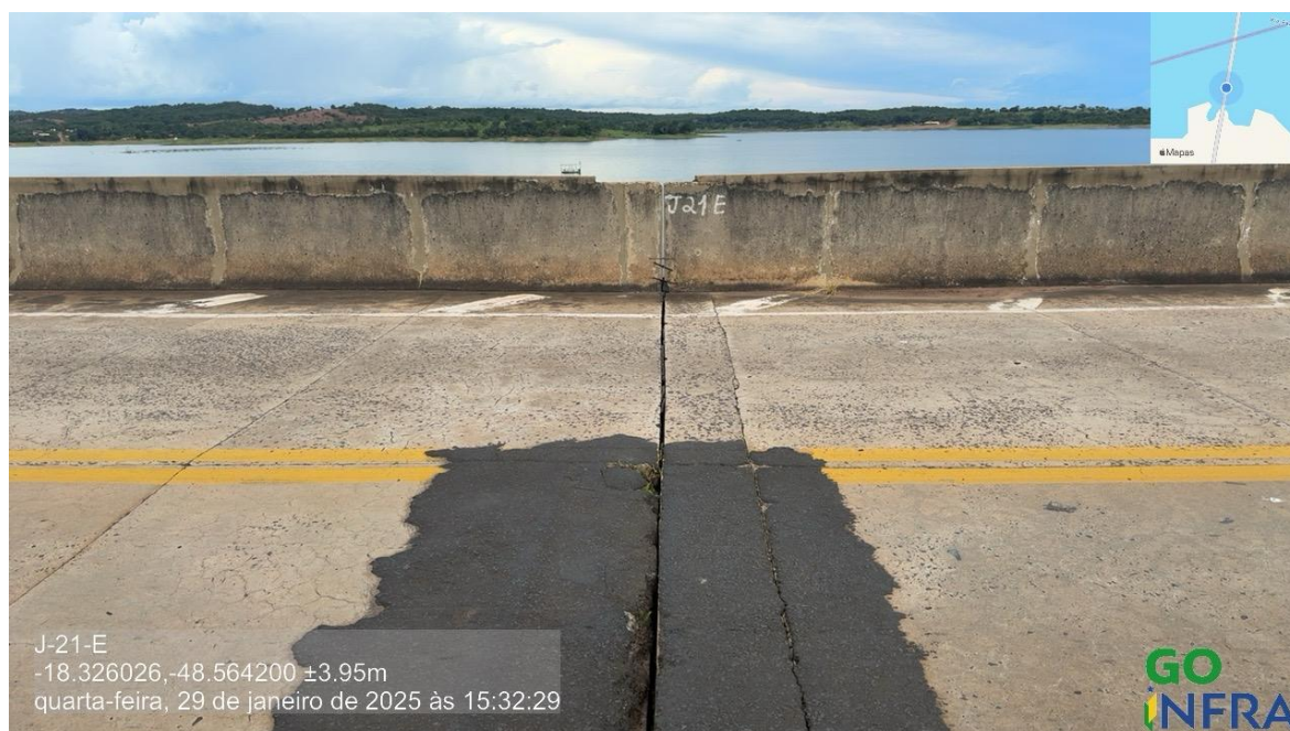
Foto 191 – Junta 21 sentido GO/MG, reparos superficiais
