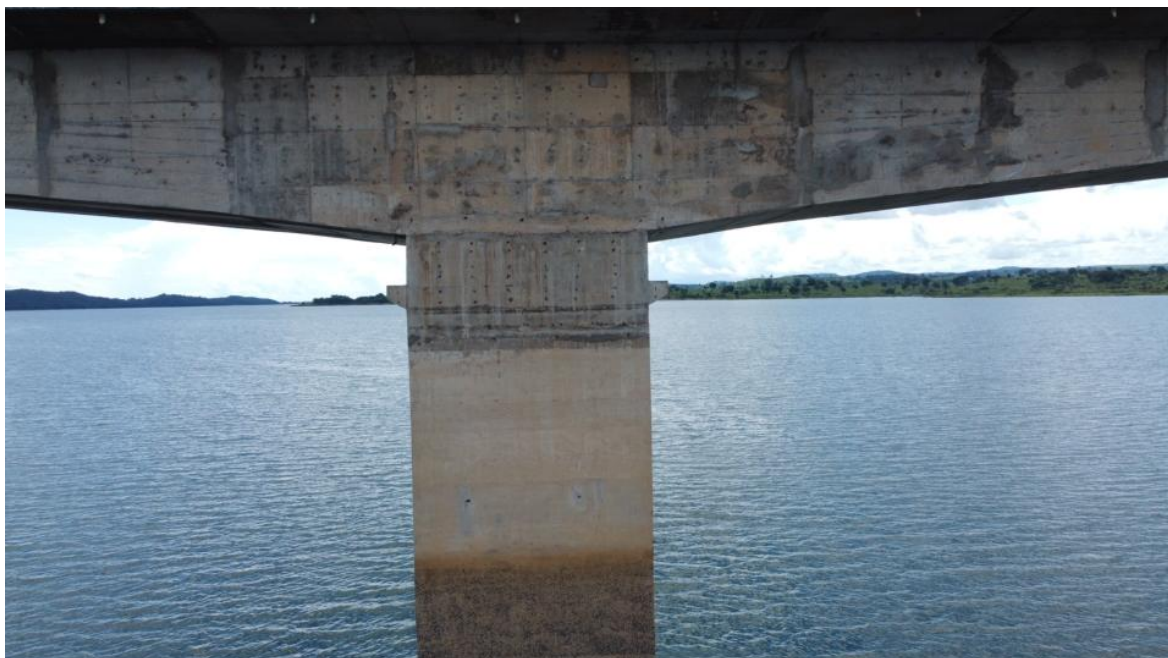
Foto 65 – Pilar P5 íntegro, apenas com desagregação superficial, marcas de escoamento superficial de água e reparos superficiais (Coordenadas: 18°19'34.03"S, 48°33'51.27"W)
