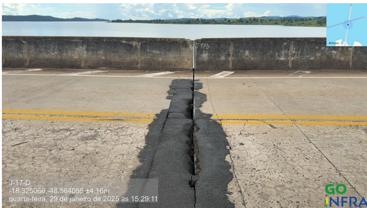
Foto 187 – Junta 17 sentido GO/MG, reparos superficiais
