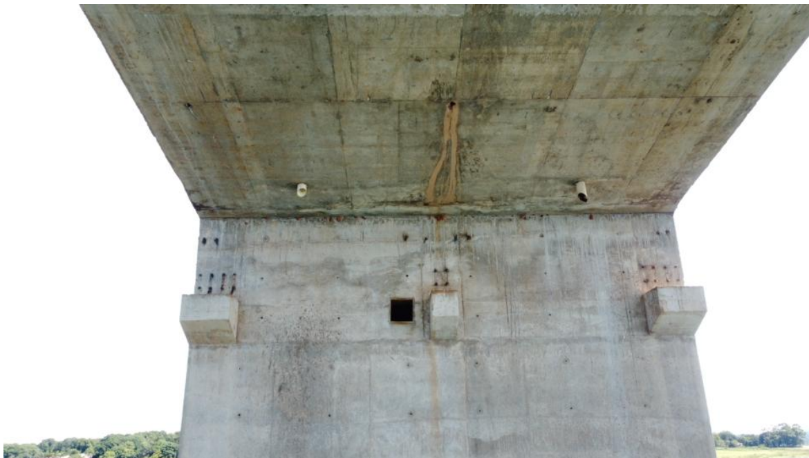
Foto 104 – Pilar P12 íntegro, apenas com desagregação superficial, marcas de escoamento superficial de água e reparos superficiais. Observação: drenos na laje contribuindo para a drenagem interna dos “caixões” (Coordenadas: 18°19'15.63"S, 48°33'48.68"W)
