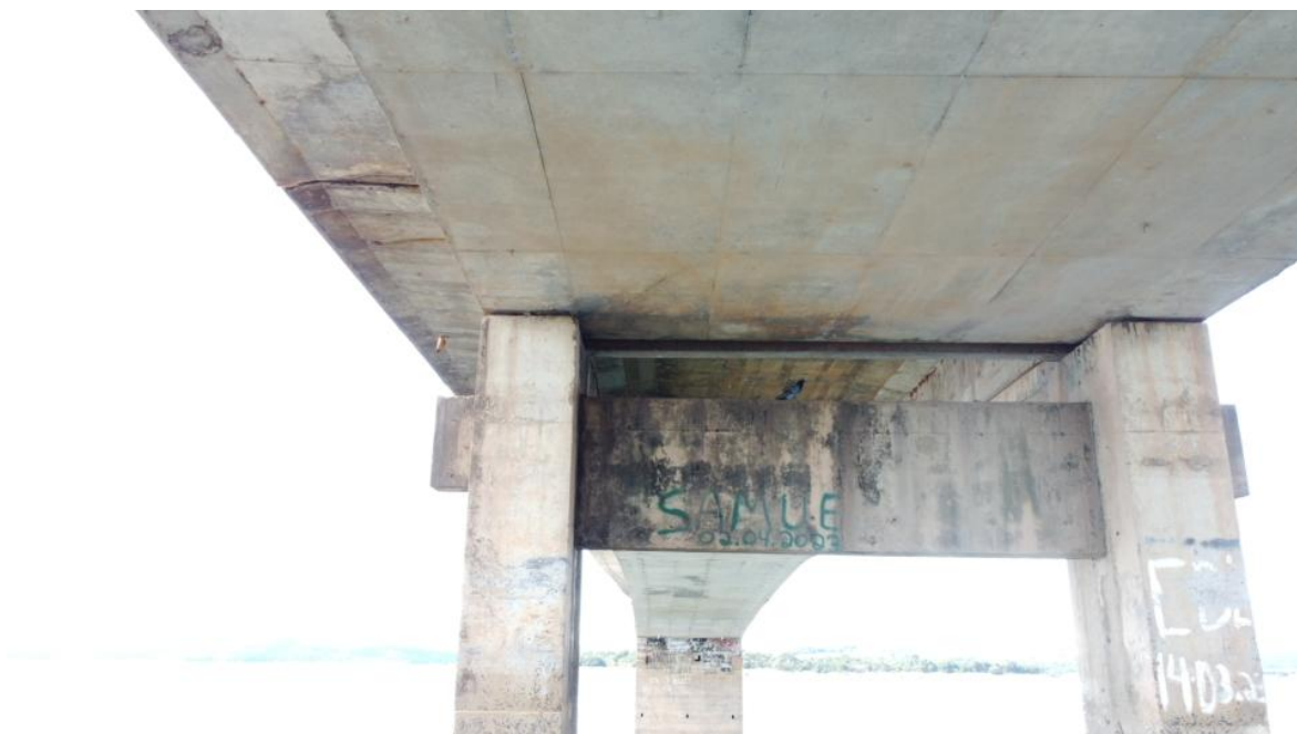
Foto 113 – Pilar P15 íntegro, apenas com desagregação superficial, marcas de escoamento superficial de água de pequenas infiltrações do caixão e reparos superficiais (Coordenadas: 18°19'8.32"S, 48°33'46.85"W)
