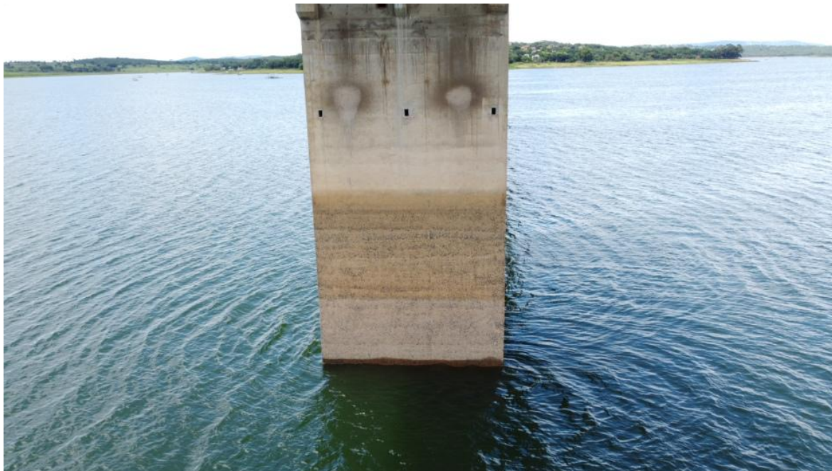
Foto 74 – Pilar P6 íntegro, apenas com desagregação superficial, marcas de escoamento superficial de água e reparos superficiais (Coordenadas: 18°19'32.02"S, 48°33'50.53"W)
