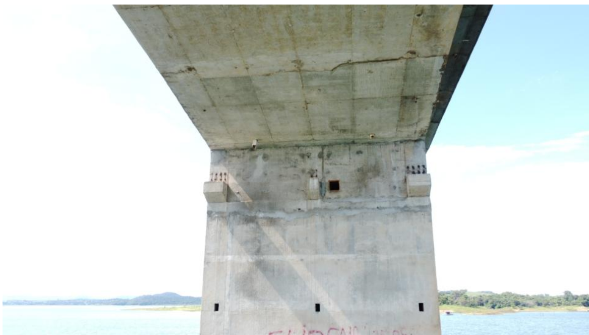
Foto 86 – Pilar P8 íntegro, apenas com desagregação superficial, marcas de escoamento superficial de água e reparos superficiais. Observação: drenos na laje contribuindo para a drenagem interna dos “caixões” (Coordenadas: 18°19'26.45”S, 48°33'50.40”W)
