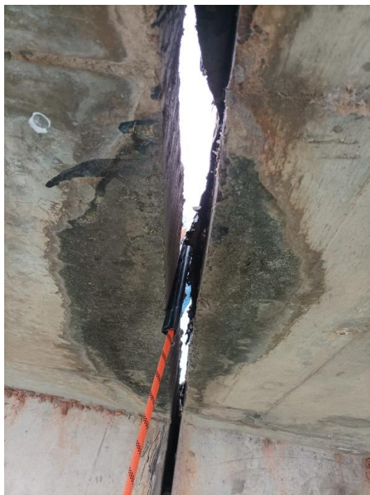
Foto 50 – Inspeção inferior de junta
