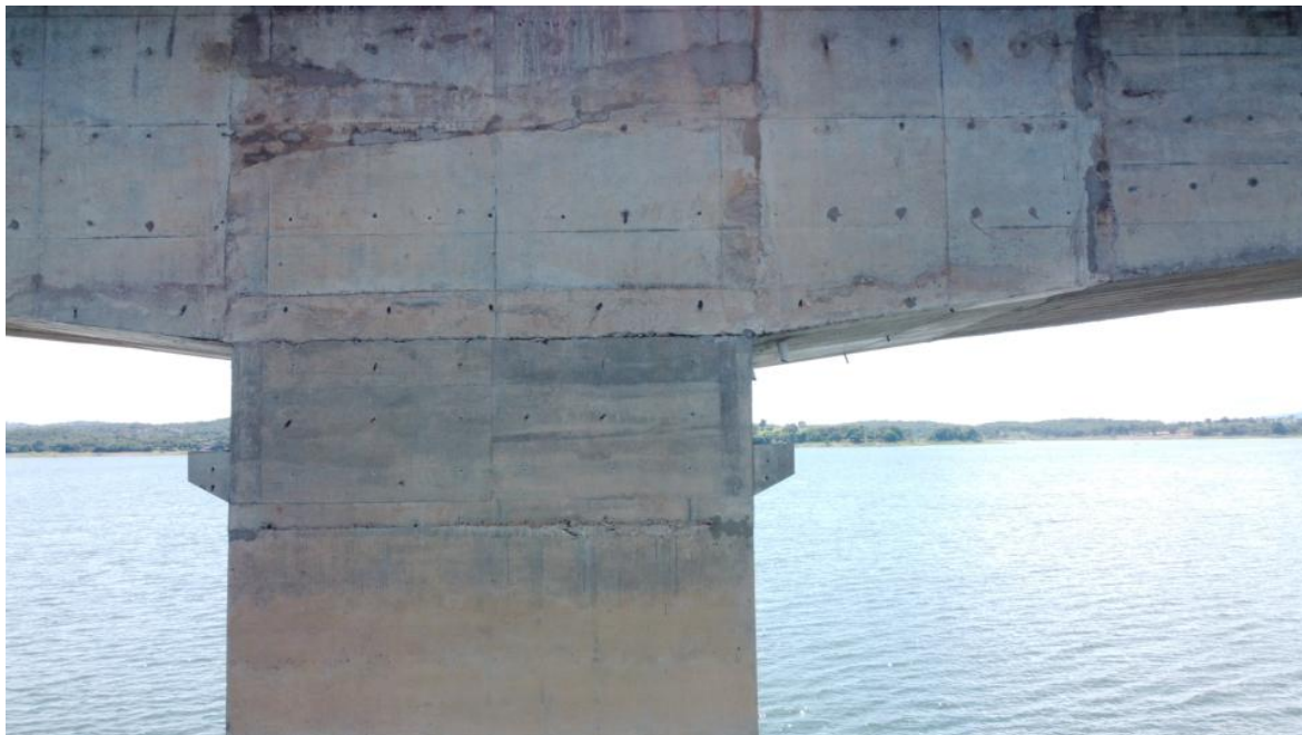
Foto 96 – Pilar P10 íntegro, apenas com desagregação superficial, marcas de escoamento superficial de água e reparos superficiais (Coordenadas: 18°19'20.66"S, 48°33'48.92"W)
