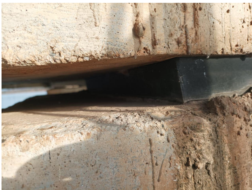
Foto 40 – Detalhe do neopreme existente
