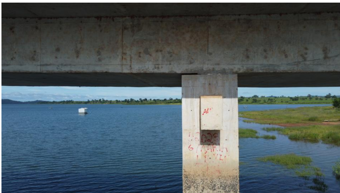
Foto 118 – Pilar P16 íntegro, apenas com desagregação superficial, marcas de escoamento superficial de água e reparos superficiais (Coordenadas: 18°19'7.24"S, 48°33'46.72"W)
