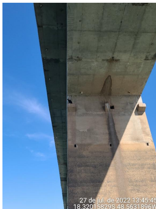
Foto 18 – Vista da parte inferior do segmento pré-fabricado apoiado nas extremidades dos balanços progressivos
