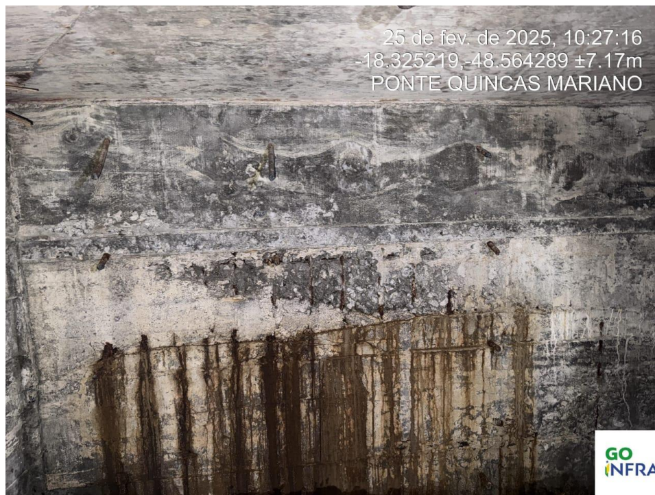
Foto 207 – Vista aproximada de parte interna da estrutura localizada entre os pilares P6 e P7, com desagregação e armadura exposta. Caso de adoção da solução 3 da Nota Técnica.
