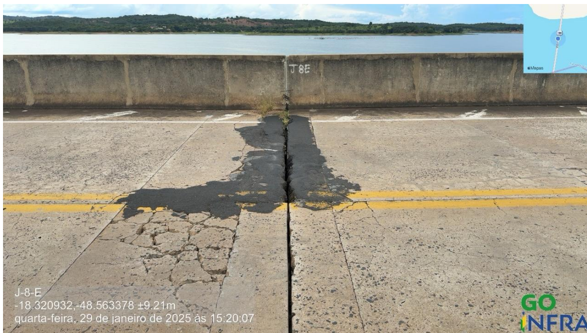
Foto 178 – Junta 8 sentido GO/MG, reparos superficiais
