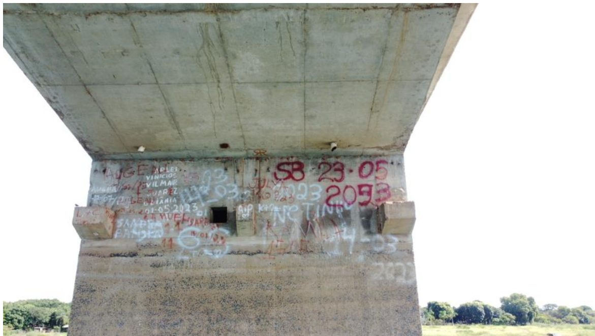
Foto 112 – Pilar P14 íntegro, apenas com desagregação superficial, marcas de escoamento superficial de água e reparos superficiais. Observação: drenos na laje contribuindo para a drenagem interna dos “caixões” (Coordenadas: 18°19'10.19"S, 48°33'47.62"W)
