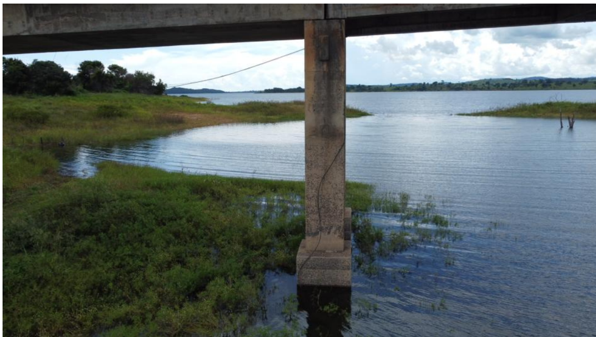
Foto 55 – Pilar P2 íntegro, apenas com desagregação superficial e marcas de escoamento superficial de água (Coordenadas: 18°19'41.69"S, 48°33'53"W)
