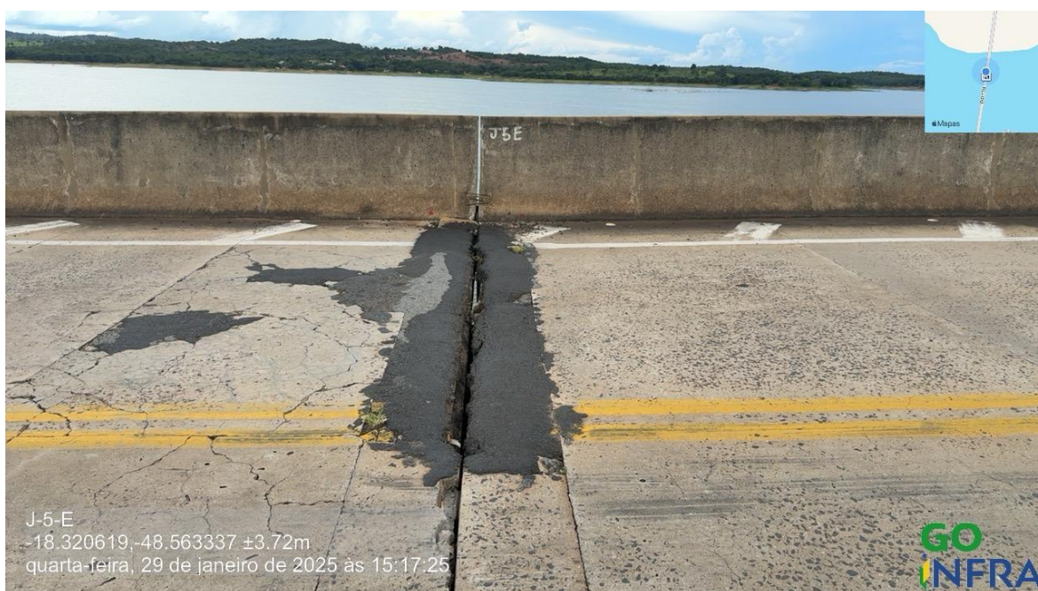
Foto 175 – Junta 5 sentido GO/MG, reparos superficiais
