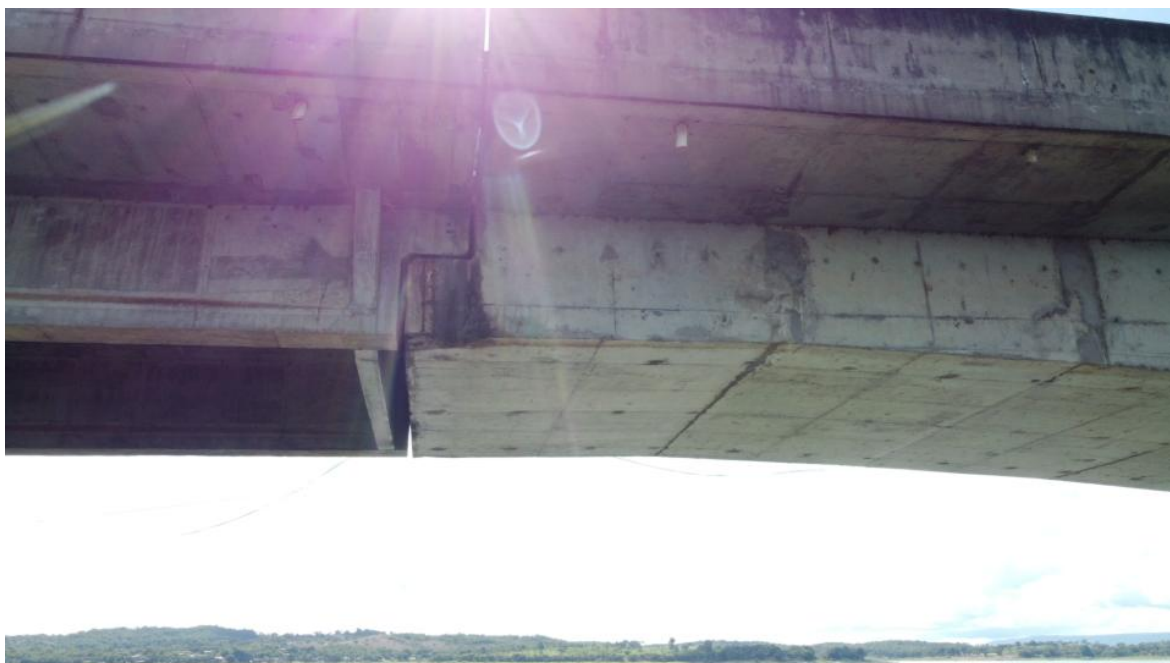
Foto 159 – Vão P12-P13 com detalhes do apoio entre lajes, com marcas de escoamento superficial de água e reparos superficiais. Observação: detalhes dos aparelhos de apoio, em sua maioria rompidos, estão nas imagens iniciais (Coordenadas: 18°19'14.60"S, 48°33'48.39" W)
