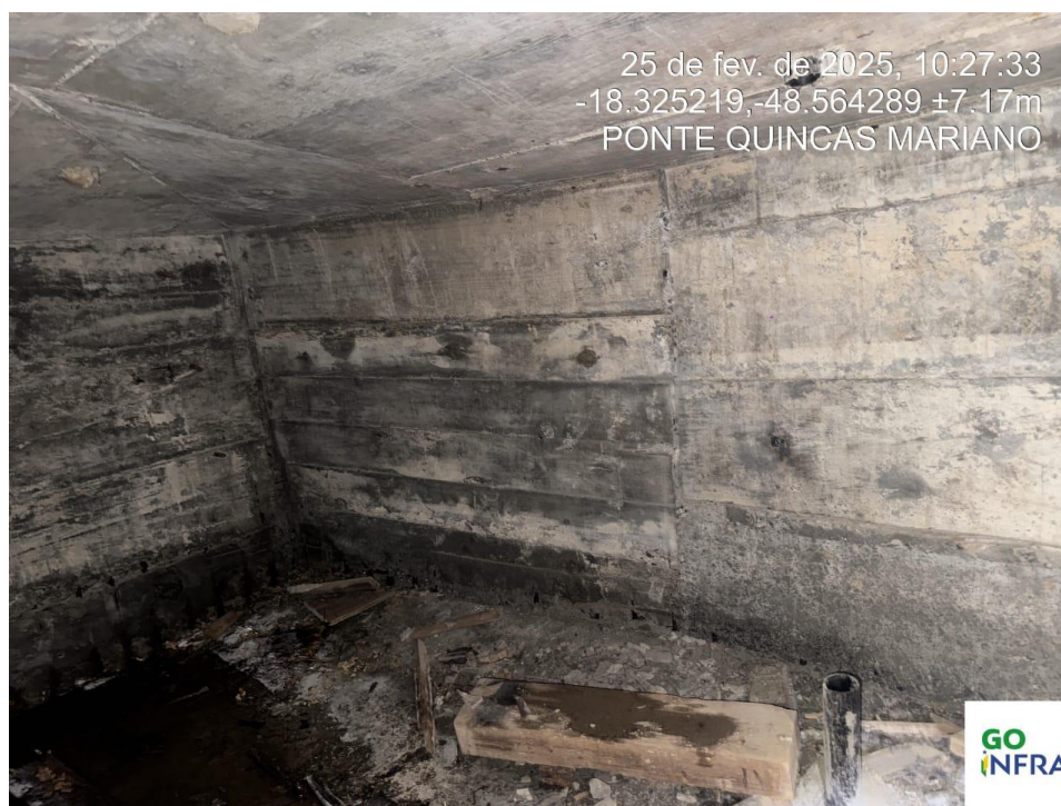
Foto 211 – Infiltração pontual, para o qual é indicada a solução 2 da Nota Técnica
