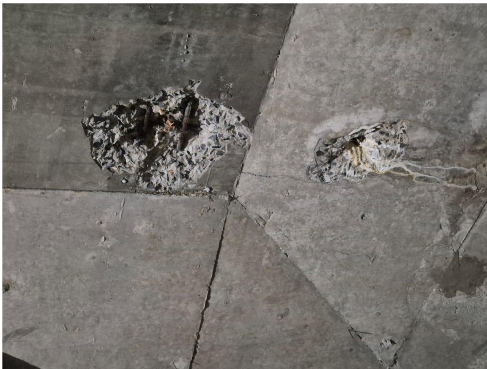
Foto 212 – Infiltração e desagregação pontuais causando a exposição de armaduras que deverá ser reparada com a Solução 3 indicada na Nota Técnica
