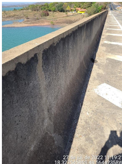
Foto 9 – Guarda reparado com concreto
