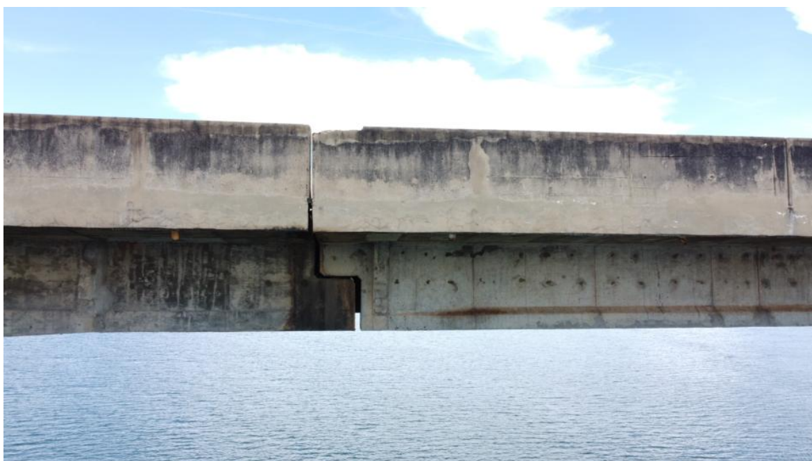
Foto 135 – Vão P5-P6 com detalhes do apoio entre lajes, com marcas de escoamento superficial de água e reparos superficiais. Observação: detalhes dos aparelhos de apoio, em sua maioria rompidos, estão nas imagens iniciais (Coordenadas: 18°19'32.93"S, 48°33'51.48"W)
