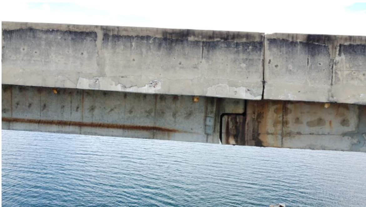
Foto 127 – Vão P3-P4 com detalhes do apoio entre lajes, com marcas de escoamento superficial de água e reparos superficiais. Observação: detalhes dos aparelhos de apoio, em sua maioria rompidos, estão nas imagens iniciais (Coordenadas: 18°19'41.04"S, 48°33'52.76"W)
