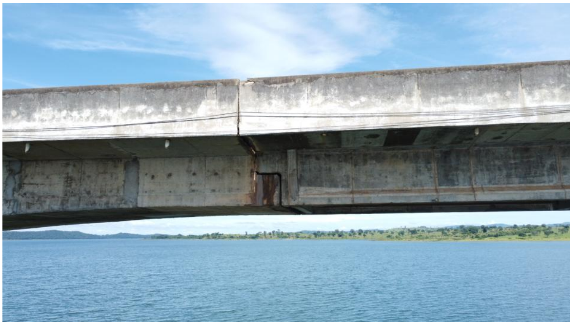
Foto 155 – Vão P10-P11 com detalhes do apoio entre lajes, com marcas de escoamento superficial de água e reparos superficiais. Observação: detalhes dos aparelhos de apoio, em sua maioria rompidos, estão nas imagens iniciais (Coordenadas: 18°19'19.40"S, 48°33'49.25" W)
