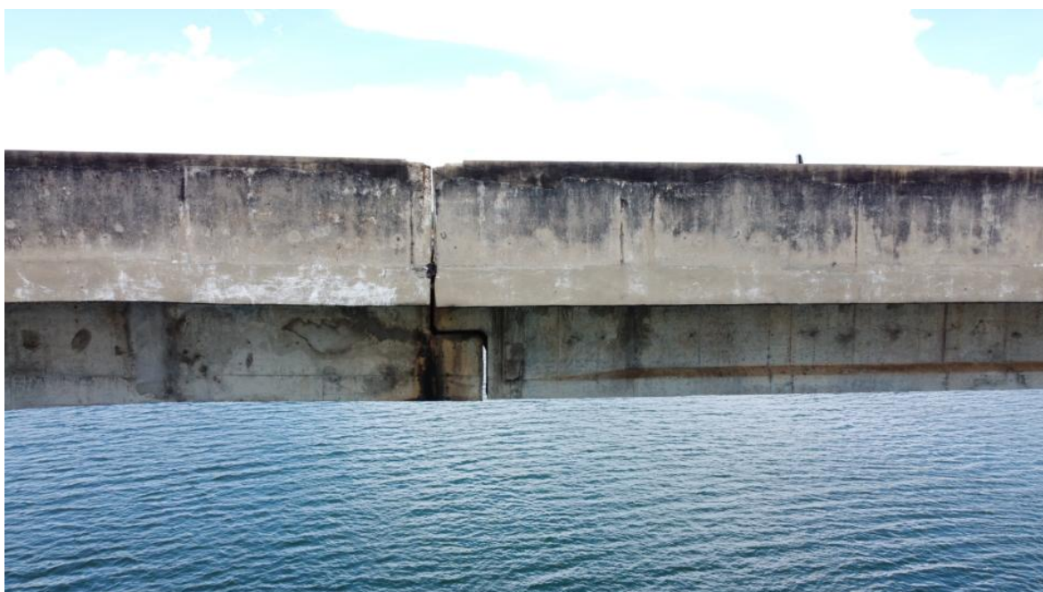
Foto 139 – Vão P6-P7 com detalhes do apoio entre lajes, com marcas de escoamento superficial de água e reparos superficiais. Observação: detalhes dos aparelhos de apoio, em sua maioria rompidos, estão nas imagens iniciais (Coordenadas: 18°19'30.18"S, 48°33'51" W)
