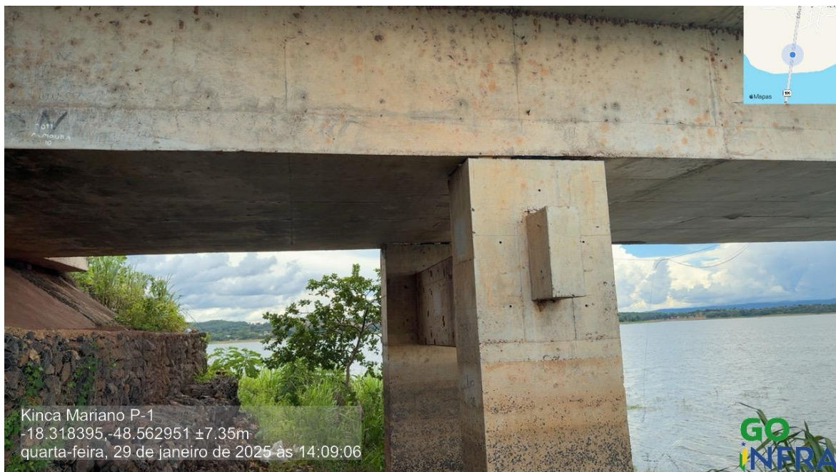
Foto 123 – Pilar P17 íntegro, apenas com desagregação superficial, marcas de escoamento superficial de água e reparos superficiais (Coordenadas: 18°19'6.15"S, 48°33'46.30"W)
