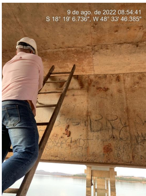
Foto 23 – Realização de ensaios de esclerometria e avaliação visual da superfície da Superestrutura
