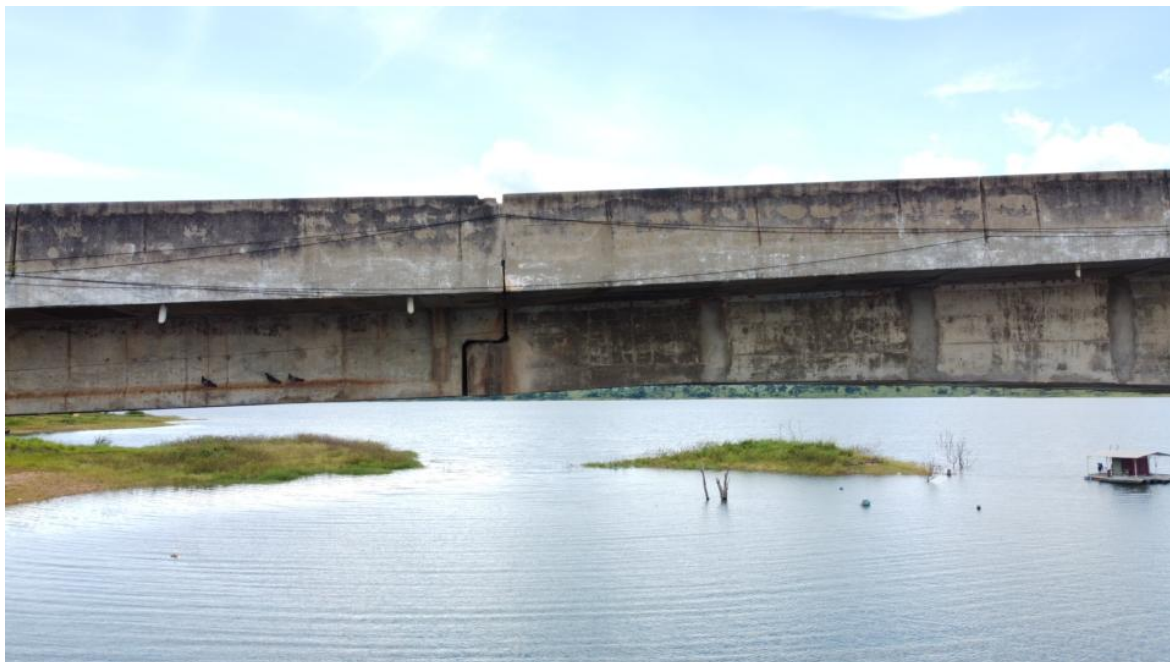
Foto 126 – Vão P2-P3 com detalhes do apoio entre lajes, com marcas de escoamento superficial de água e reparos superficiais. Observação: detalhes dos aparelhos de apoio, em sua maioria rompidos, estão nas imagens iniciais (Coordenadas: 18°19'41.04"S, 48°33'52.76"W)
