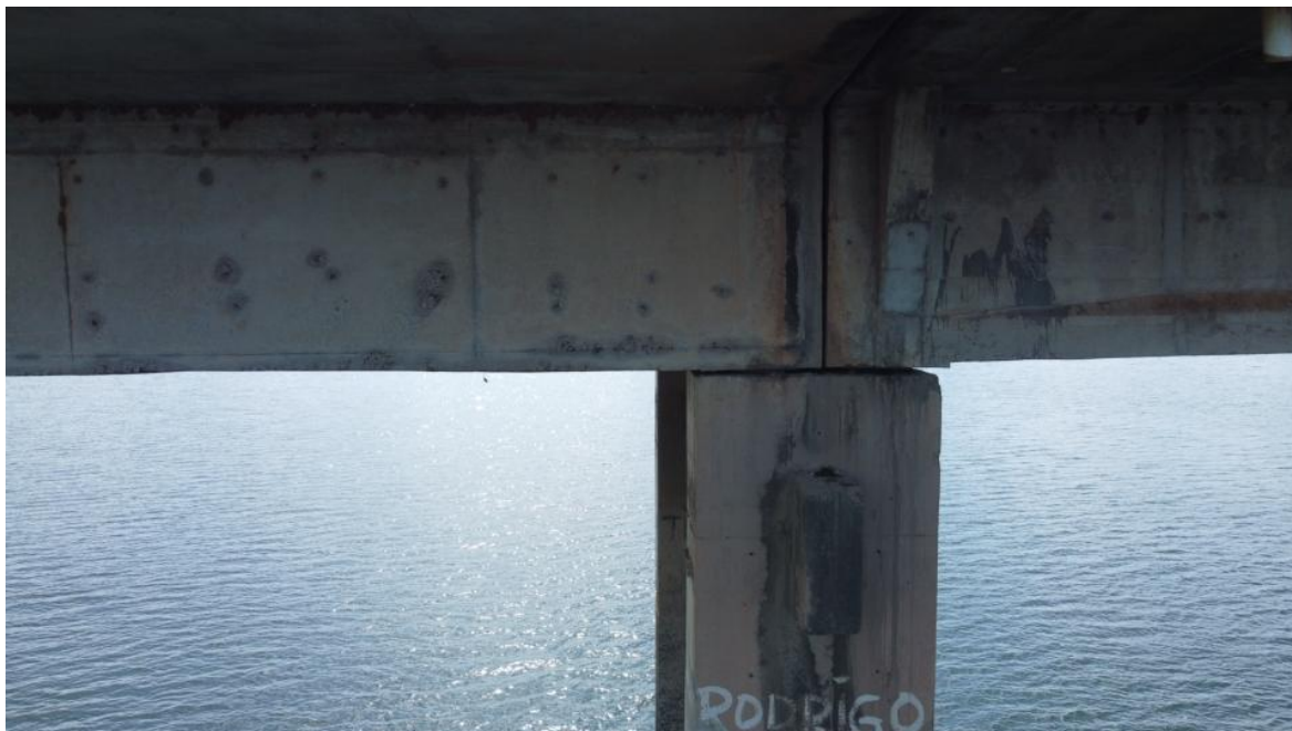
Foto 116 – Pilar P15 íntegro, apenas com desagregação superficial, marcas de escoamento superficial de água e reparos superficiais (Coordenadas: 18°19'8.32"S, 48°33'46.85"W)
