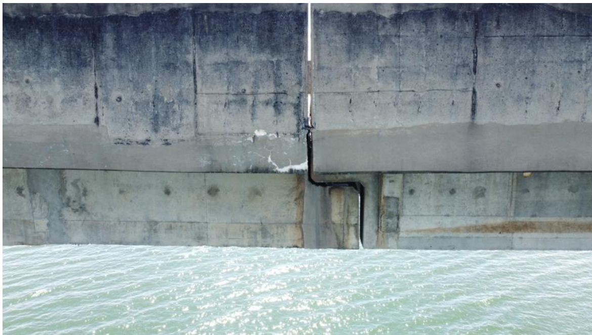
Foto 152 – Vão P9-P10 com detalhes do apoio entre lajes, com marcas de escoamento superficial de água e reparos superficiais. Observação: detalhes dos aparelhos de apoio, em sua maioria rompidos, estão nas imagens iniciais (Coordenadas: 18°19'22.22"S, 48°33'48.91" W)
